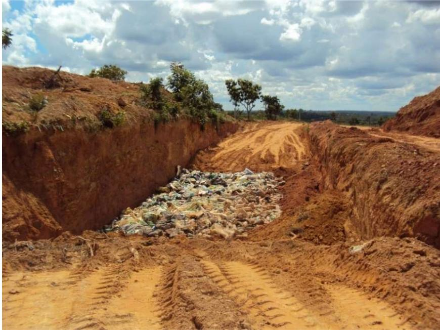
Figura 53: Vista Geral de Vala Utilizada para o Aterramento dos Resíduos Dispostos
