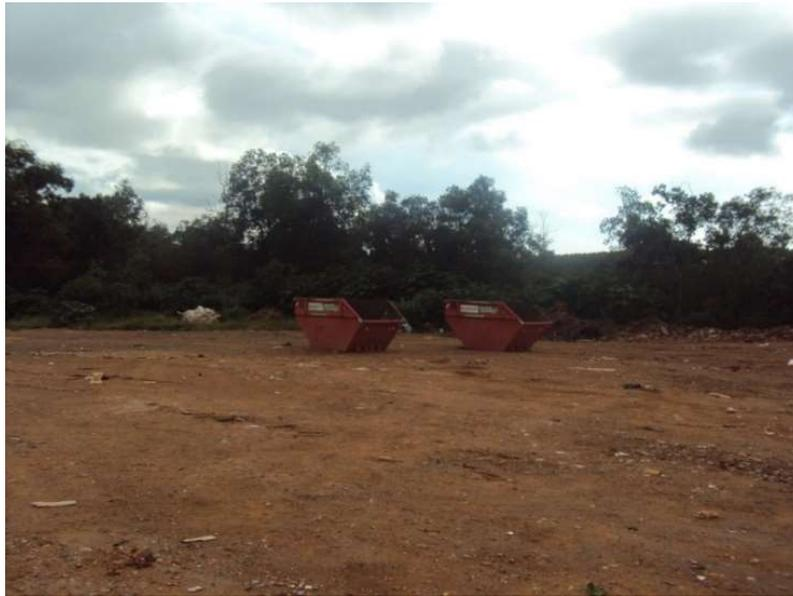
Figura 12: Vista de Caçambas Posicionadas em Pontos Estratégicos para o Recebimento dos Resíduos da Construção Civil
