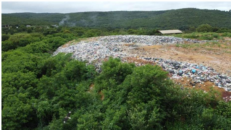
Figura 36: Local Utilizado como Destino Final dos RSUs sem Recobrimento
