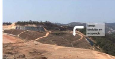
FIGURA 3 - Destaque das células concluídas em recuperação
