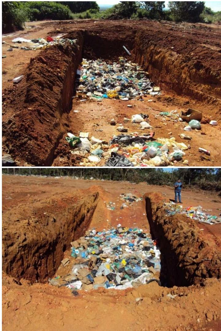
Figura 3: Detalhes do Lixão do Município de Augusto de Lima - Áreas da Vala Utilizada como Destinação Final dos RSUs Posteriormente Recobertos
