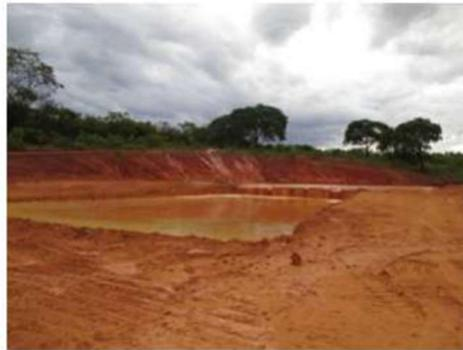
Figura: Bacia de acumulação de sedimentos em pleno funcionamento.
