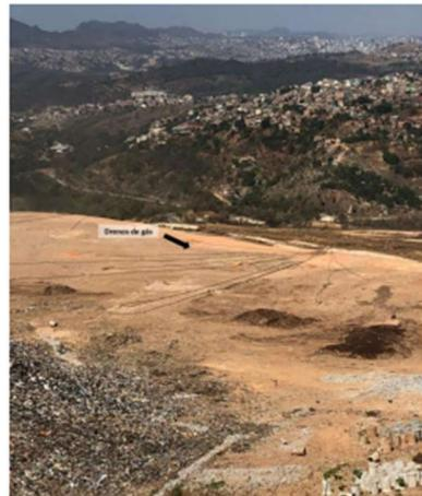
FIGURA 5 - Drenos de gás para direcionamento do metano para queima
