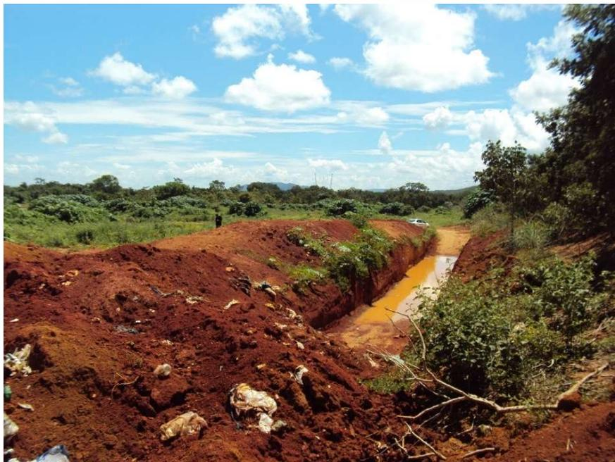
Figura 33: Registro Fotográfico do Sistema de Aterramento Composto por Valas, sem a Devida Drenagem, Ocasionalmente Alagando as Valas
