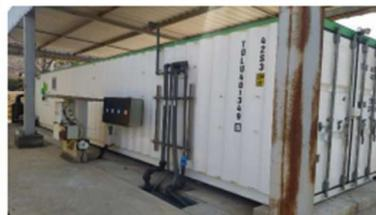
FIGURA 11 - Estação de tratamento de chorume osmose reversa
