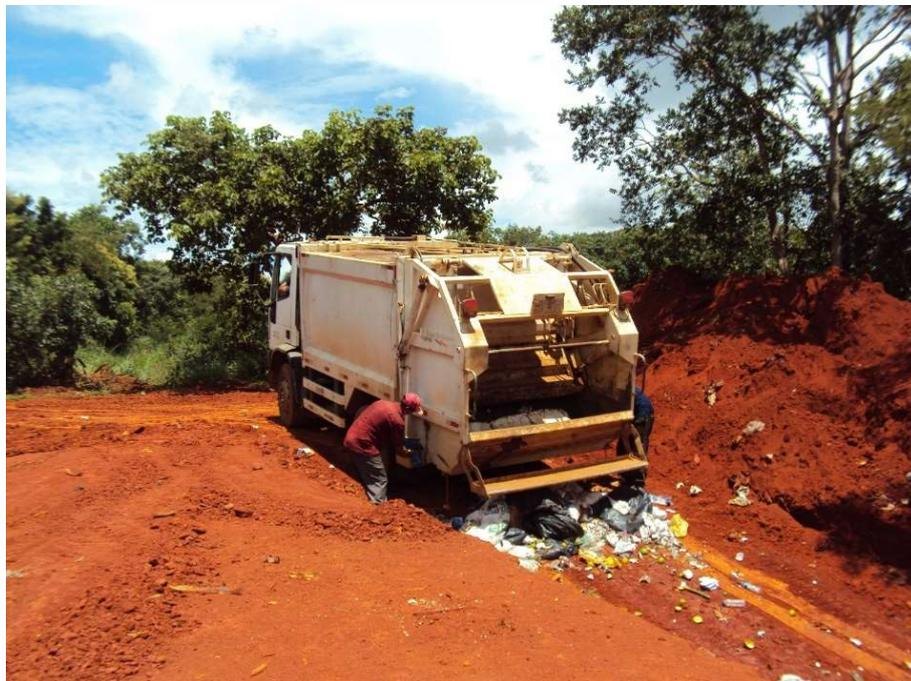
Figura 57: Descarga de Resíduos Sólidos na Vala para posterior recobrimento com solo
