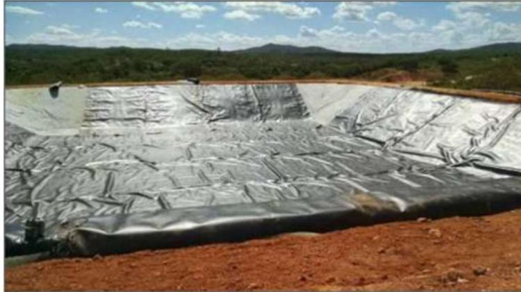
Lagoa de pré tratamento do chorume impermeabilizada com geocomposto bentonítico e geomembrana de PEAD texturizada de 2mm de espessura
