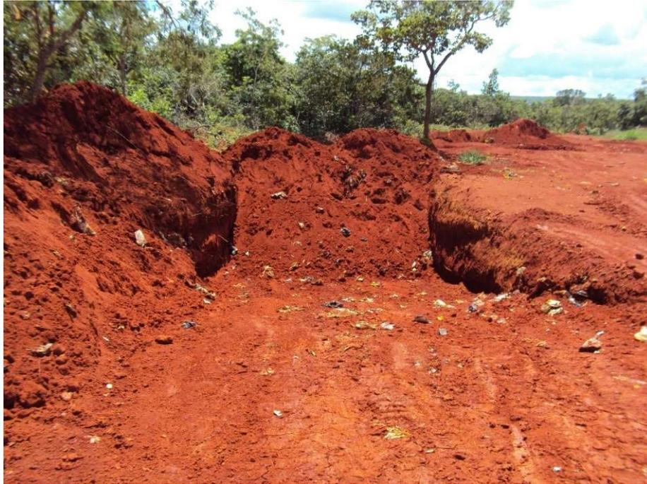
Figura 58: Vala com o Recobrimento da Parcela de Resíduos Depositada
