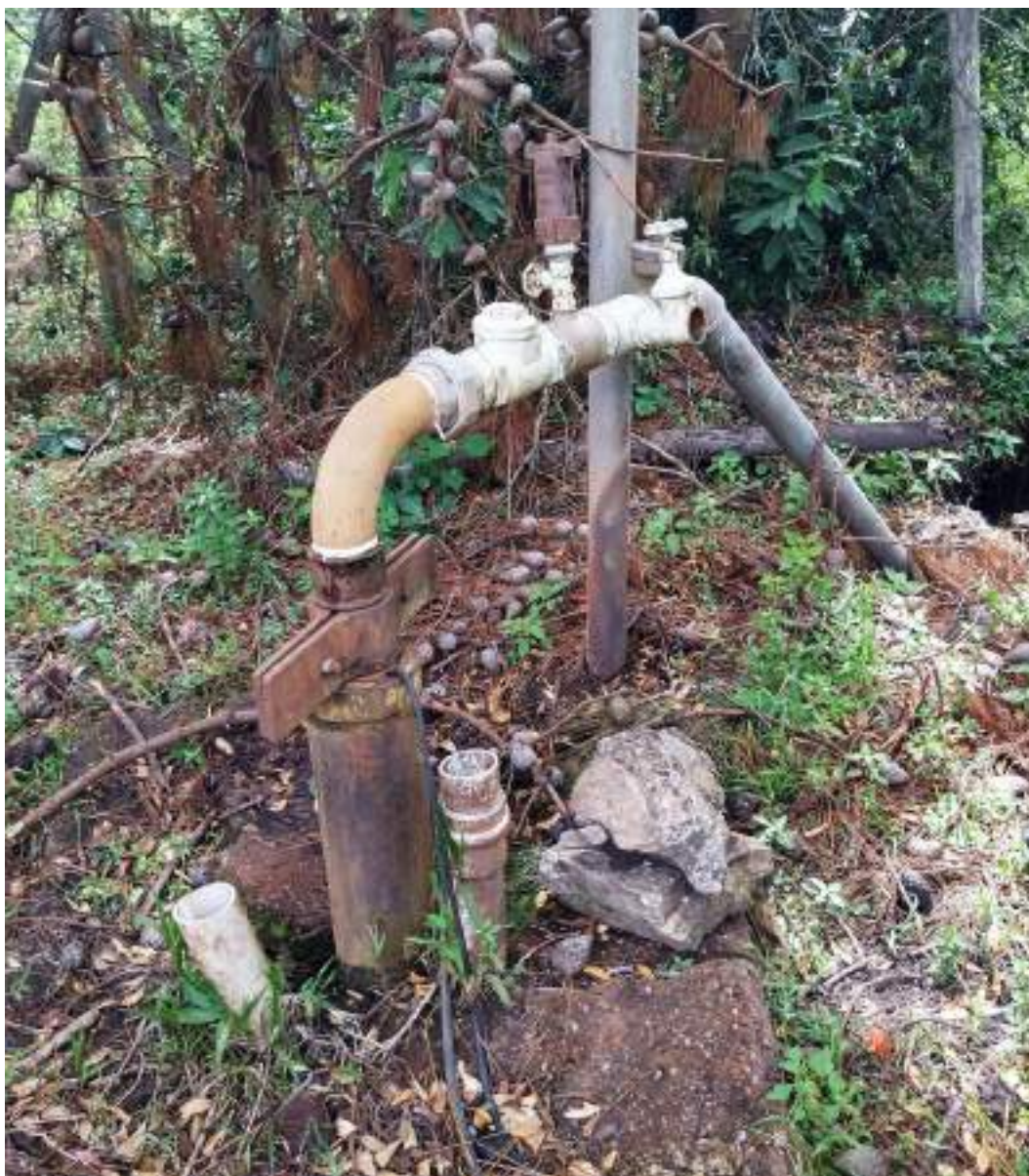
Figura 91 – Poço E01 em São João da Chapada. Fonte: Profill Engenharia e Ambiente, 2020.
