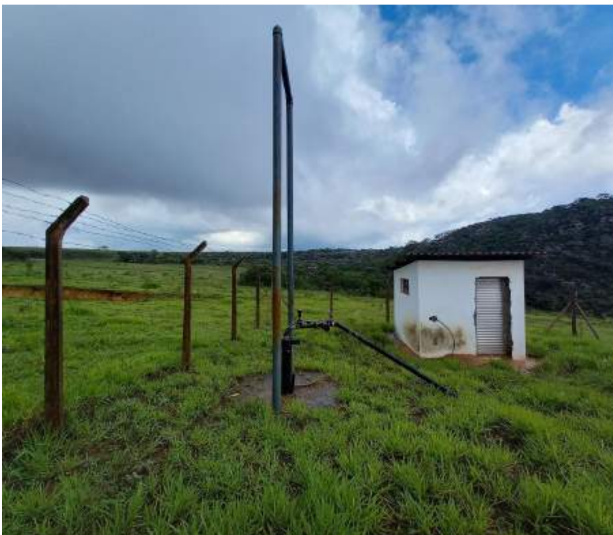
Figura 88 – Poço C01 em Morrinhos. Fonte: Profill Engenharia e Ambiente, 2020.
