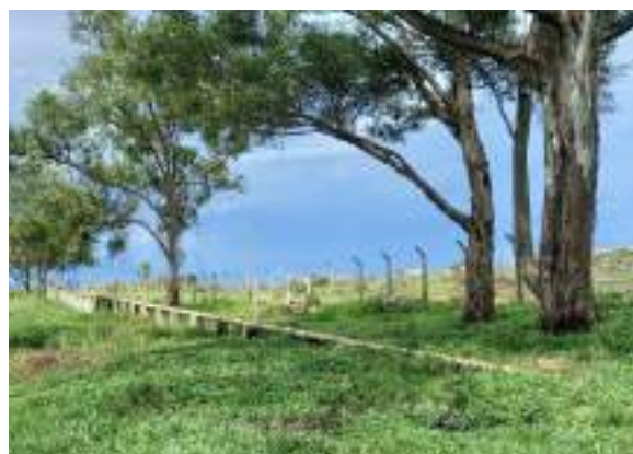
Figura 185 – Gotejamento da ETE de São João da Chapada. Fonte: Profill Engenharia e Ambiente, 2020.
