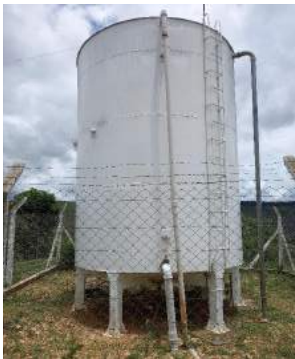
Figura 122 – Reservatório apoiado de Senador Mourão. Fonte: Profill Engenharia e Ambiente, 2020.
