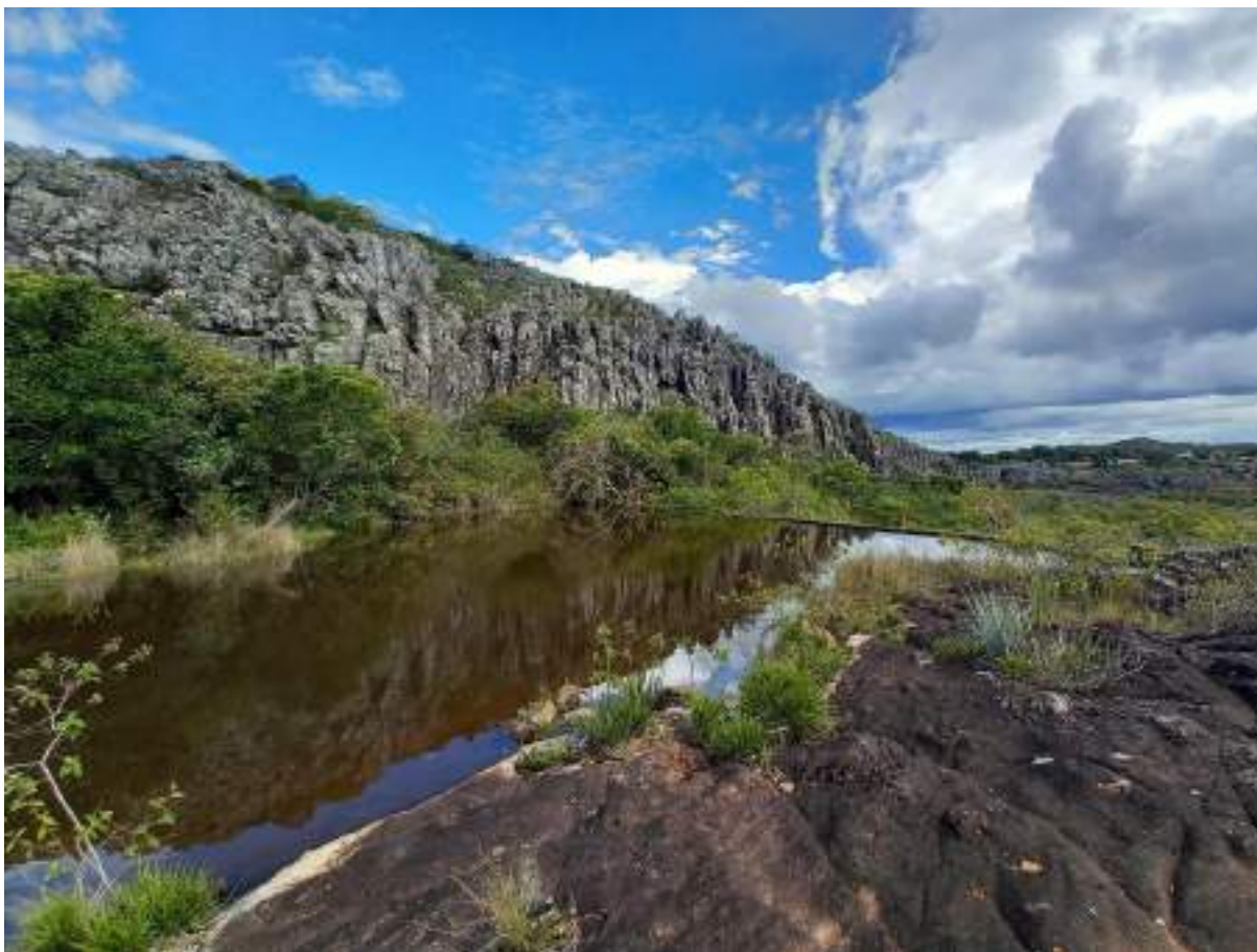
Figura 95 – Captação superficial de Extração. Fonte: Profill Engenharia e Ambiente, 2020.
