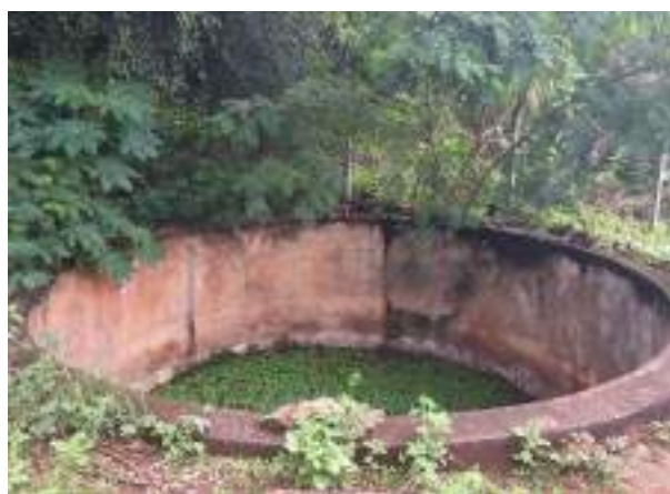
Figura 206 – Leito de secagem da ETE de Desembargador Otoni. Fonte: Profill Engenharia e Ambiente, 2020.
