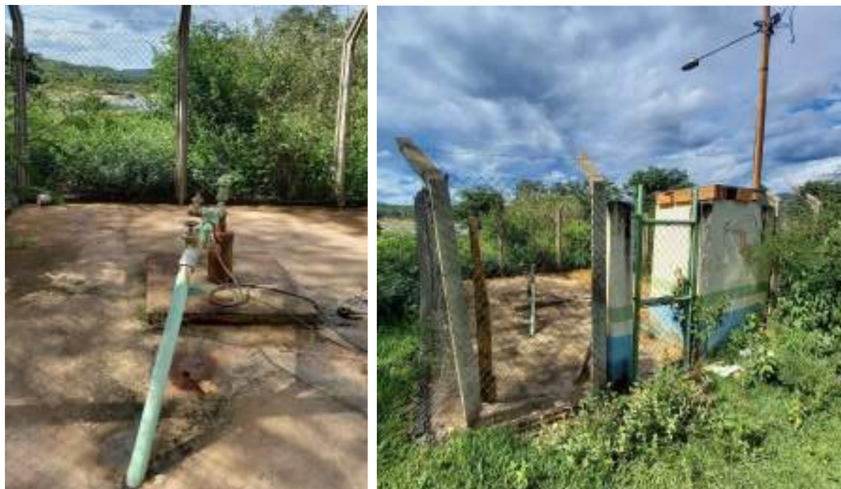
Figura 107 – Poço C02 de Maria Nunes. Fonte: Profill Engenharia e Ambiente, 2020.
