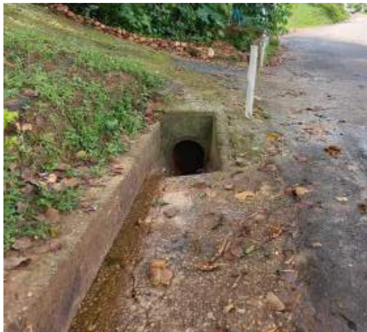
Figura 268 – Microdrenagem no distrito de Senador Mourão. Fonte: Profill Engenharia e Ambiente, 2020.
