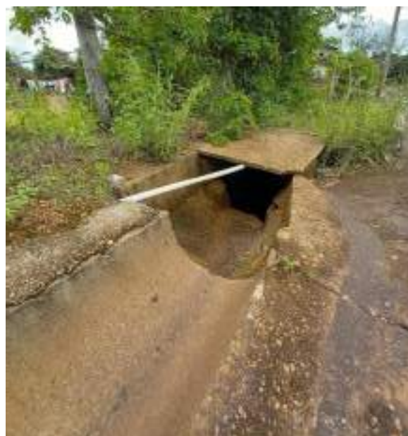
Figura 267 – Microdrenagem no distrito de Guinda.
