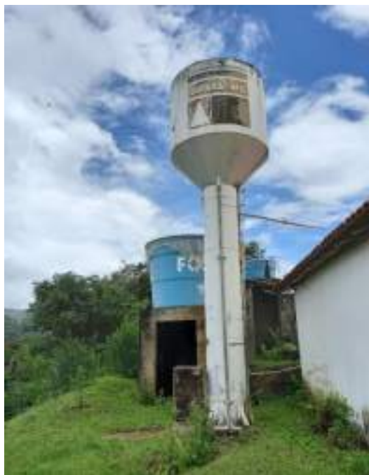
Figura 133 - Reservatório na comunidade Boa Vista.
