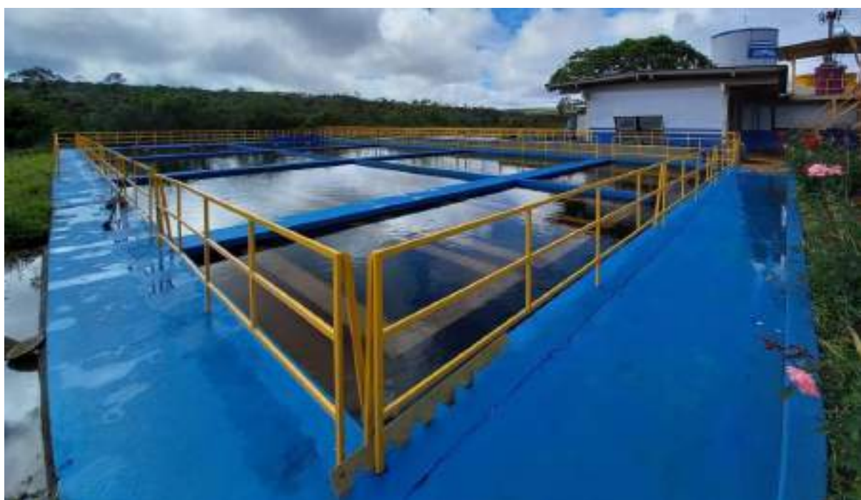
Figura 58 – ETA desativada da sede municipal Fonte: Profill Engenharia e Ambiente, 2020.
