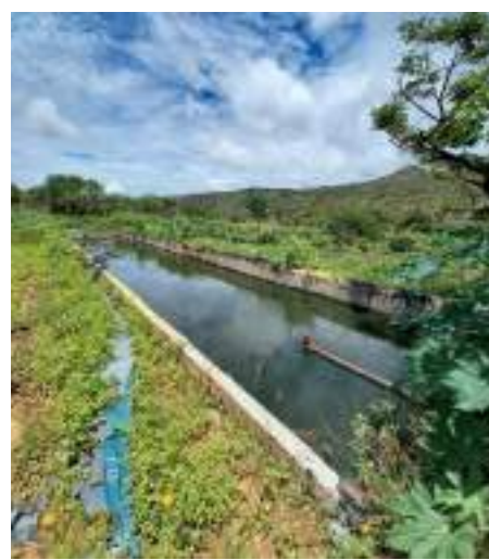
Figura 200 – Lagoa de maturação ETE de Senador Mourão. Fonte: Profill Engenharia e Ambiente, 2020.
