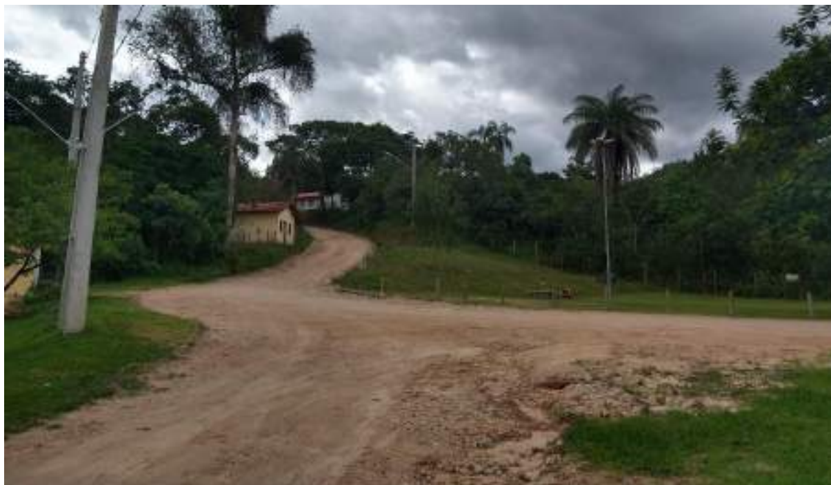
Figura 34 – Via de terra na comunidade rural Vau.
