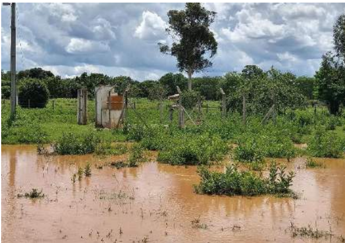
Figura 129 – Poço C01 de Planalto de Minas. Fonte: Profill Engenharia e Ambiente, 2020.
