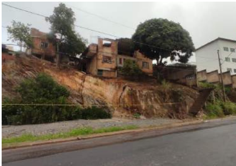
Figura 279 – Moradias com risco de deslizamento em Diamantina. Fonte: G1 Minas, 2020.
