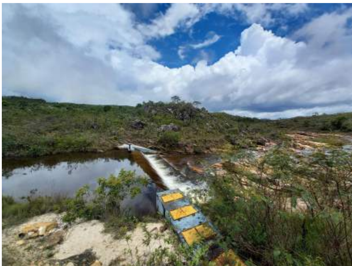
Figura 53 – Captação superficial Ribeirão do Guinda. Fonte: Profill Engenharia e Ambiente, 2020.
