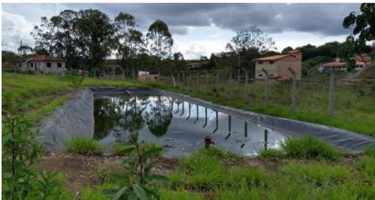
Figura 179 – Lagoa de maturação da ETE de Guinda. Fonte: Profill Engenharia e Ambiente, 2020.
