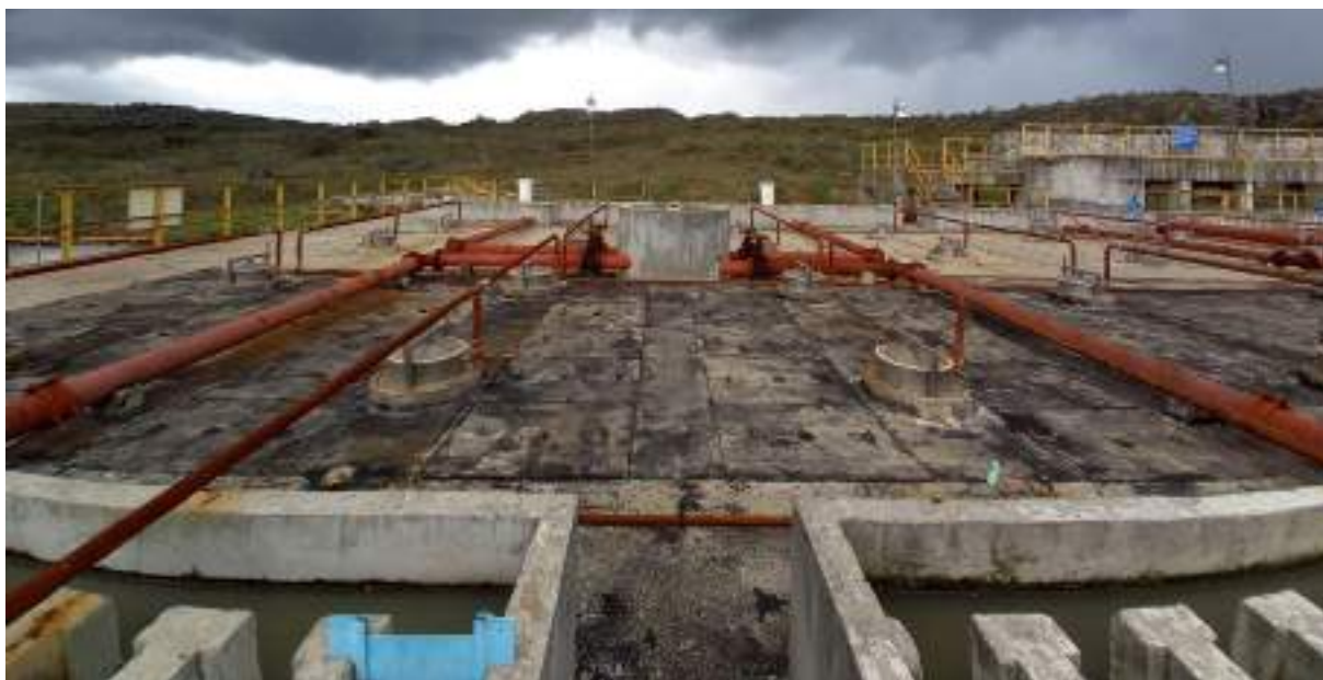
Figura 165 – Reatores UASB da ETE da sede municipal. Fonte: Profill Engenharia e Ambiente, 2020.
