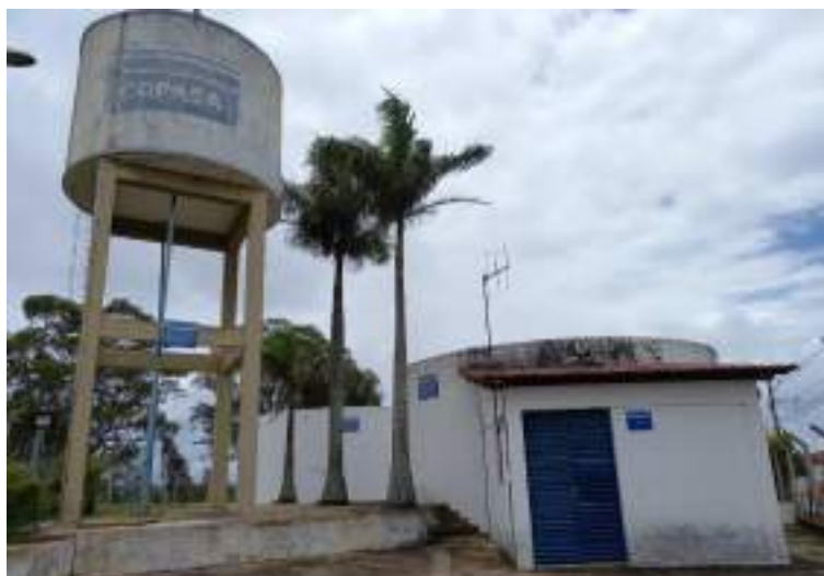
Figura 64 – Reservatórios R03, R04 e R05 e EEAT 05 – Bela Vista da sede municipal.
