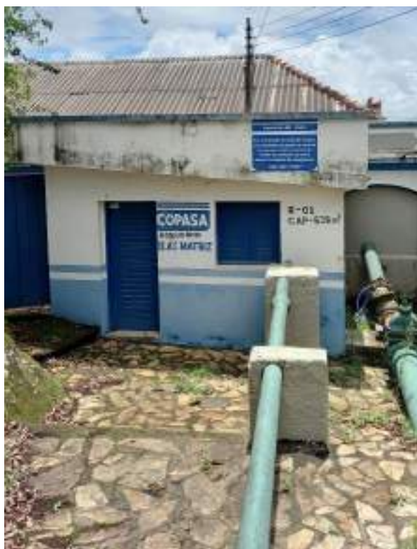
Figura 62 – Reservatório R01 - Matriz da sede municipal.
