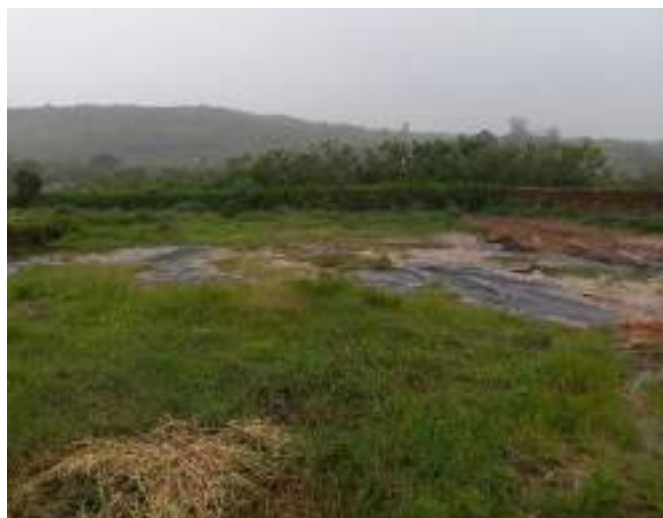
Figura 169 – Aterro sanitário da ETE da sede municipal.
