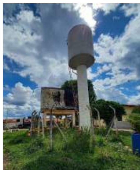
Figura 131 – Reservatório elevado de Planalto de Minas.
