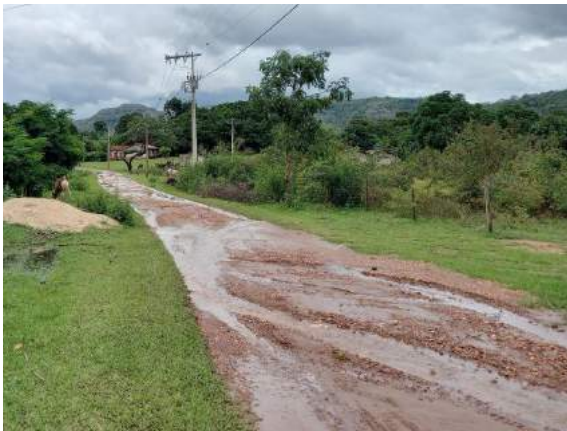
Figura 32 – Via de terra na comunidade rural Boa Vista. Fonte: Profill Engenharia e Ambiente, 2020.
