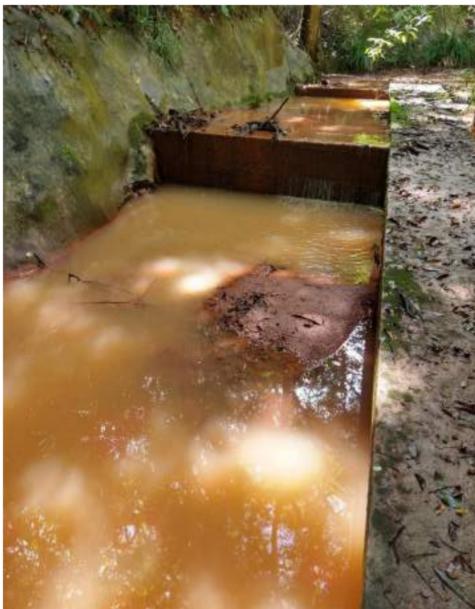
Figura 115 – Captação superficial de Senador Mourão. Fonte: Profill Engenharia e Ambiente, 2020.
