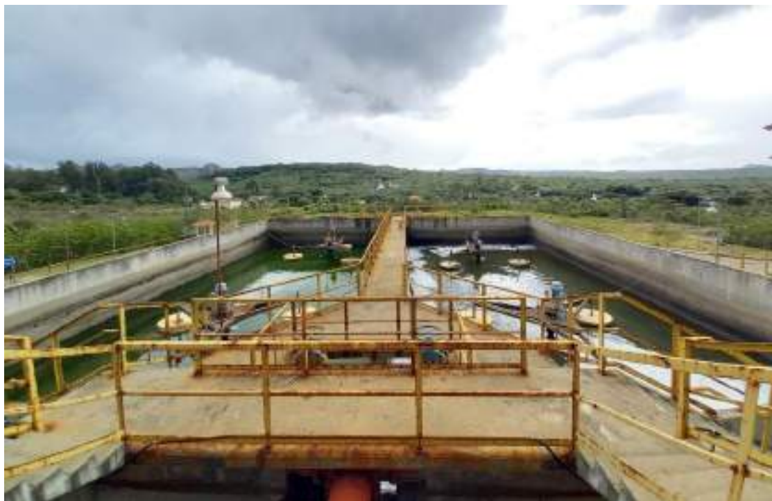
Figura 167 – Reatores de lodo ativado da ETE da sede municipal.
