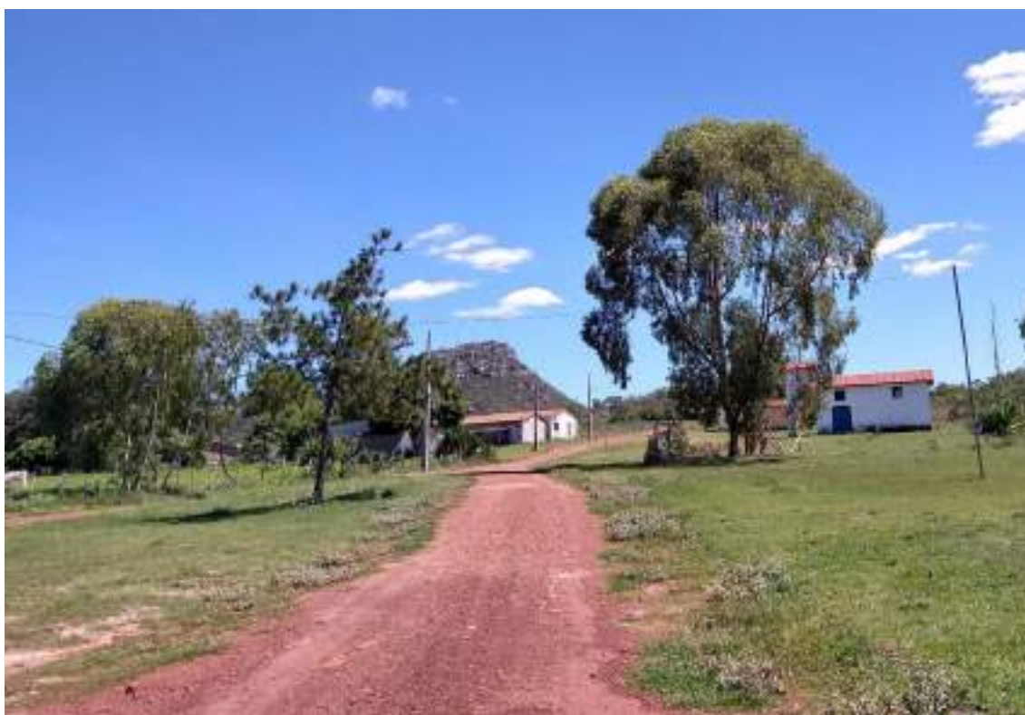
Figura 33 – Via de terra na comunidade rural Galheiros. Fonte: Profill Engenharia e Ambiente, 2020.
