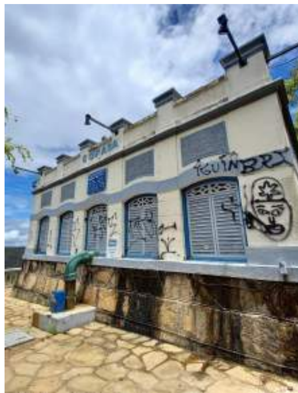
Figura 63 – Reservatório R02 - Grupiara da sede municipal.
