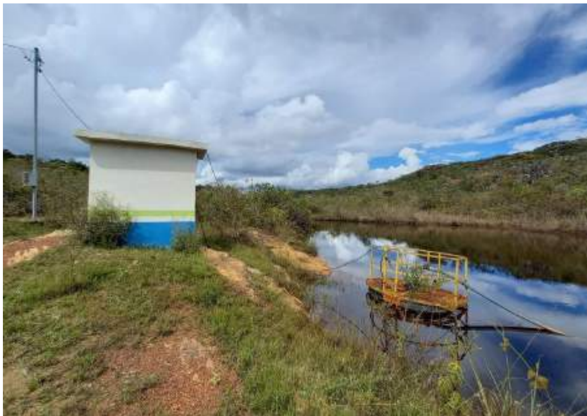
Figura 96 – Captação superficial reserva de Extração. Fonte: Profill Engenharia e Ambiente, 2020.
