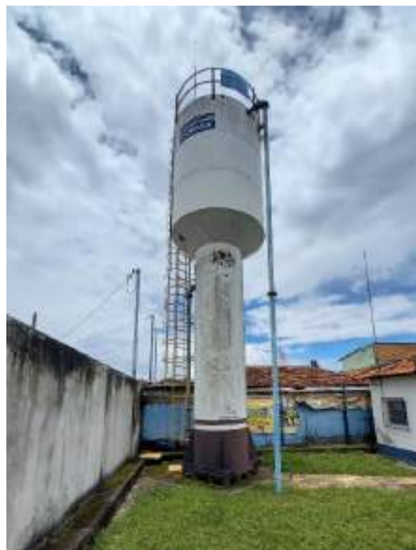
Figura 67 – Reservatório R08 – Casas Populares elevado da sede municipal.
