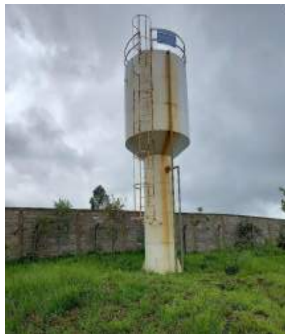
Figura 71 – Reservatório R11 – Vista da Serra da sede municipal. Fonte: Profill Engenharia e Ambiente, 2020.
