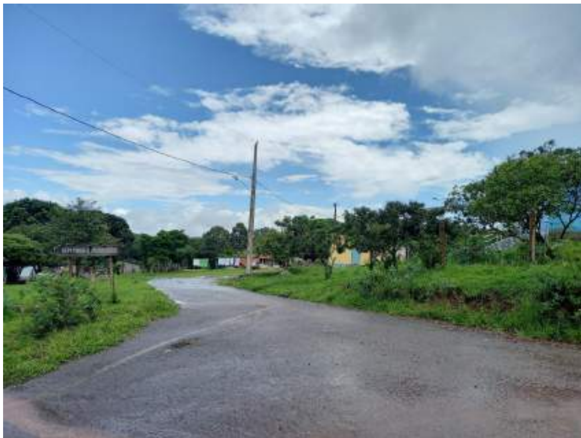
Figura 31 – Trecho asfaltado na comunidade Morrinhos. Fonte: Profill Engenharia e Ambiente, 2020.
