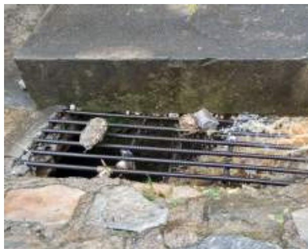
Figura 264 – Boca de lobo no centro de Diamantina.
