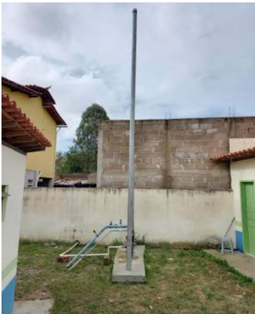
Figura 82 – Poço E01 em Guinda. Fonte: Profill Engenharia e Ambiente, 2020.
