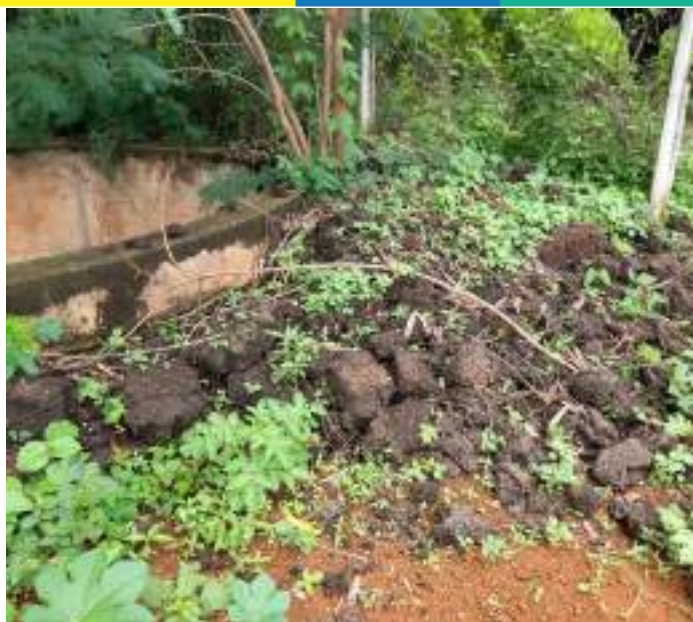
Figura 218 – Disposição inadequada do lodo seco na ETE de Desembargador Otoni.
