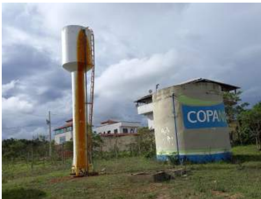
Figura 83 – Reservatórios RAP 01 e REL 02 em Guinda. Fonte: Profill Engenharia e Ambiente, 2020.
