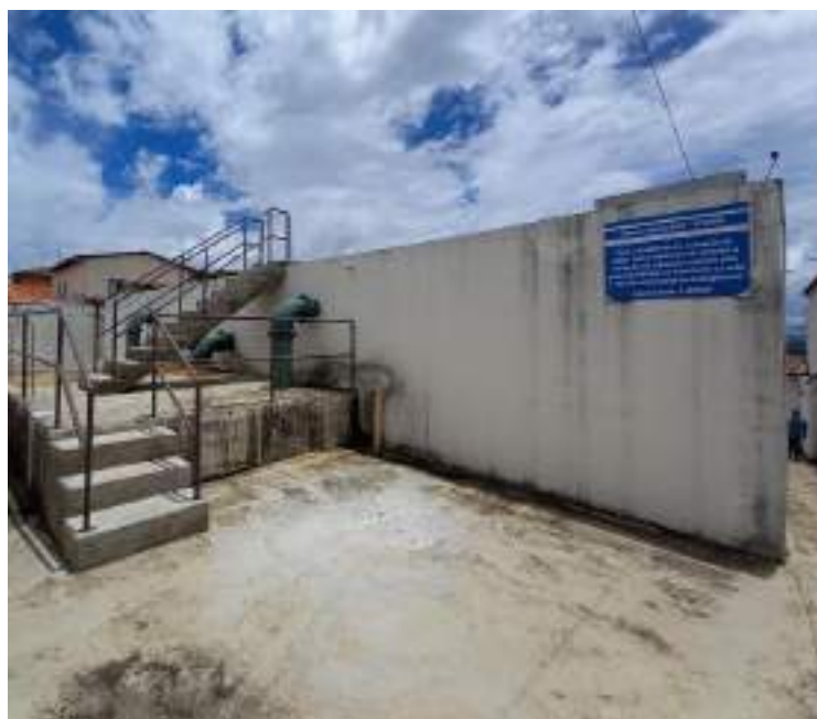
Figura 68 – Reservatório R09 – R1000 da sede municipal.
