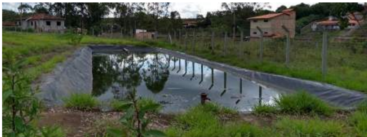
Figura 108 - Lagoa de maturação da ETE de Guinda.
