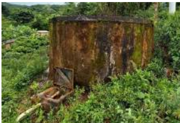
Figura 87 - Reservatórios na comunidade Pinheiro. Fonte: Profill Engenharia e Ambiente, 2020.
