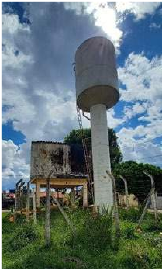
Figura 81 - Reservatório elevado de Planalto de Minas.
