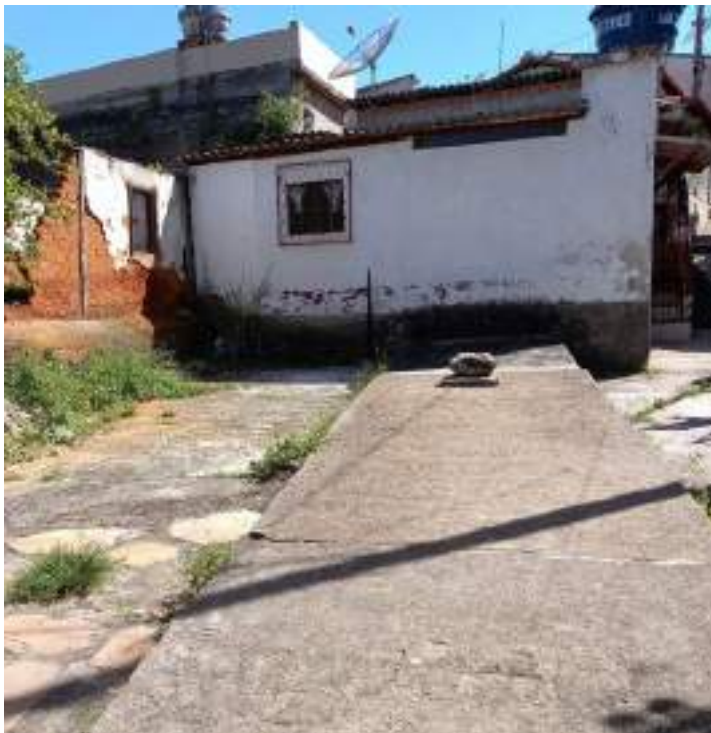
Figura 174 - Casa construída em cima de galeria pluvial.
