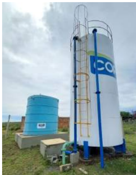
Figura 59 - Reservatório RAP 01 em São João da Chapada.
