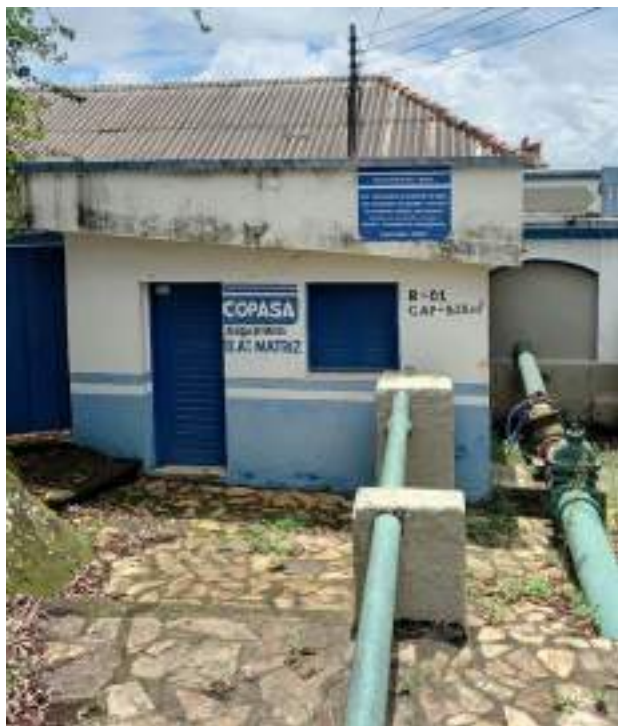
Figura 32 - Reservatório R01 - Matriz.
