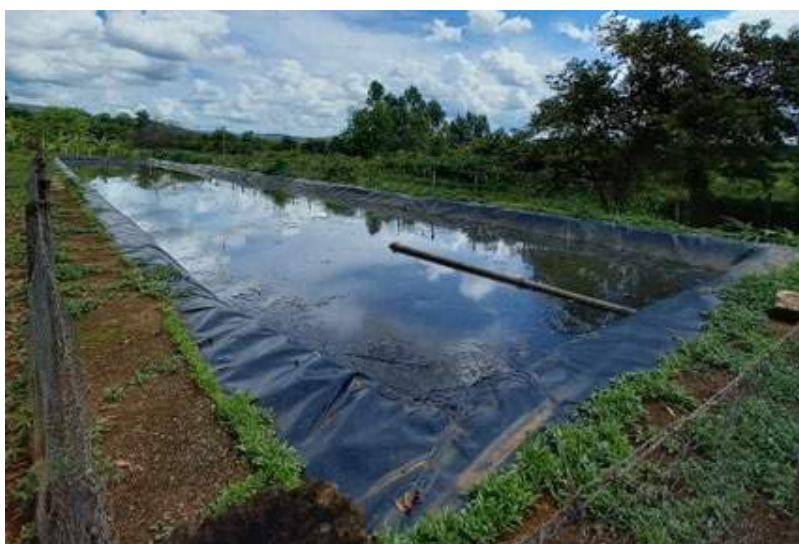
Figura 140 - Lagoa de maturação da ETE de Planalto de Minas.
