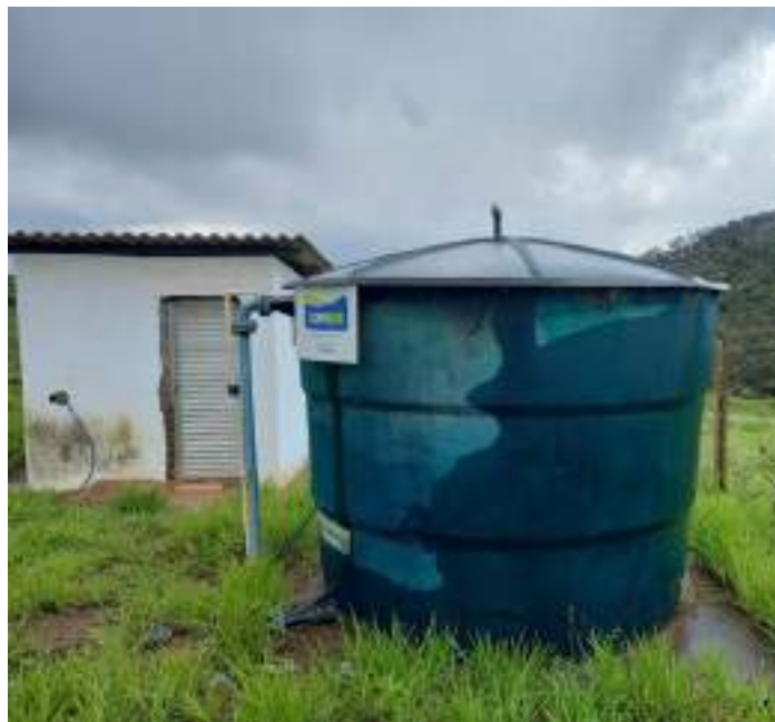
Figura 55 - Reservatório RAP 01 em Morrinhos. Fonte: Profill Engenharia e Ambiente, 2020.
