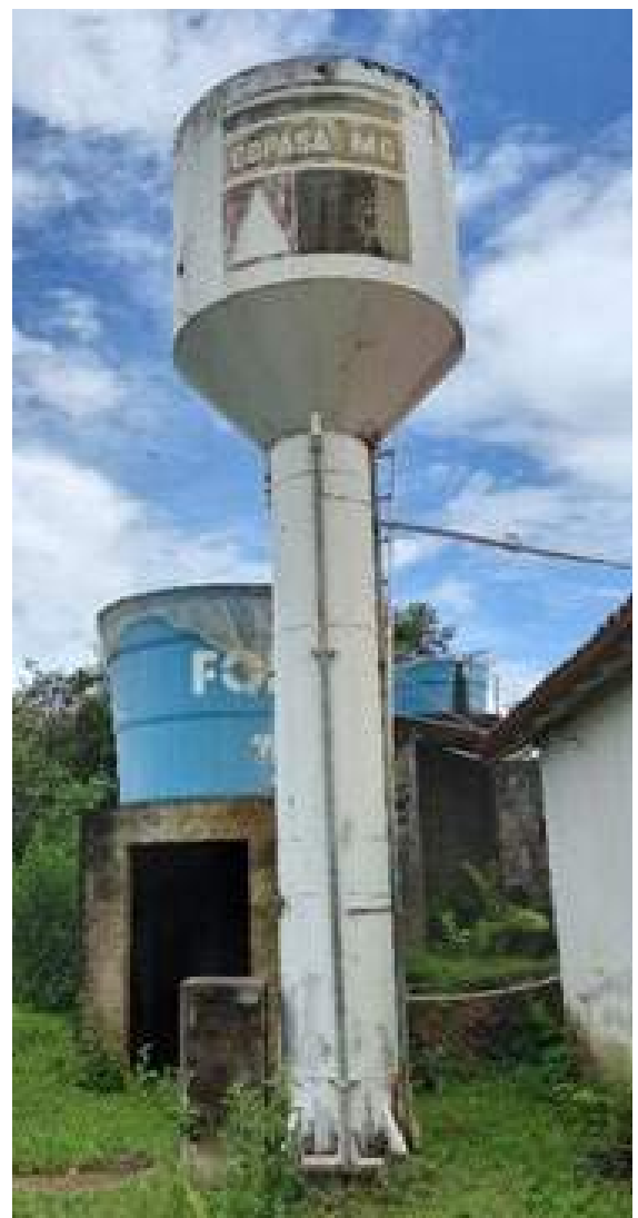
Figura 86 - Reservatório na comunidade Boa Vista. Fonte: Profill Engenharia e Ambiente, 2020.
