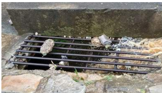
Figura 166 - Boca de lobo no centro de Diamantina.
