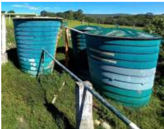
Figura 102 - Filtro e reatores da ETE de Conselheiro Mata. Fonte: Profill Engenharia e Ambiente, 2020.
