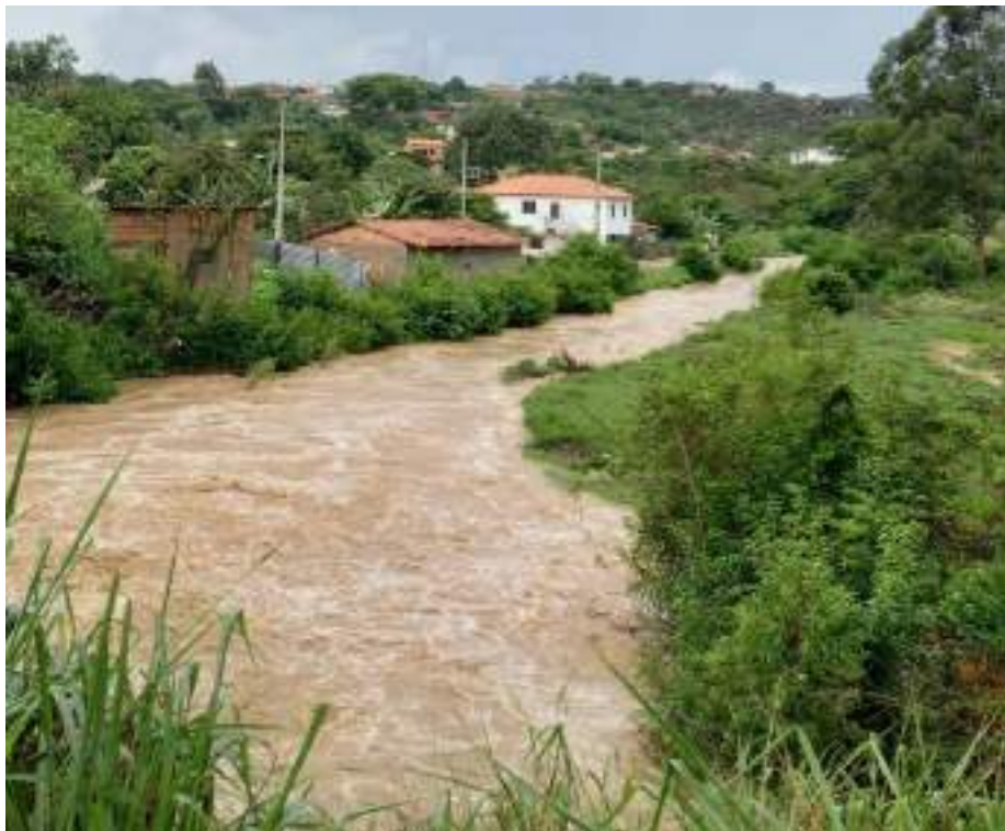
Figura 17 - Moradias com risco de inundação em Diamantina.
