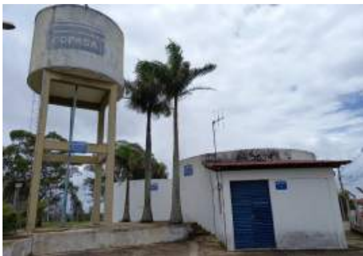
Figura 34 - Reservatórios R03, R04 e R05 e EEAT 05 - Bela Vista.
