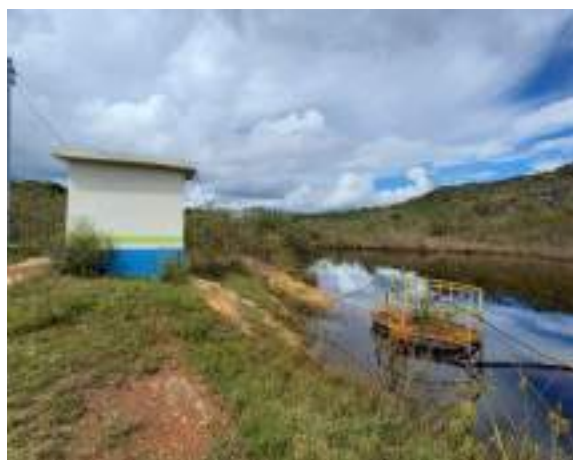
Figura 61 - Captação superficial reserva de Extração.
