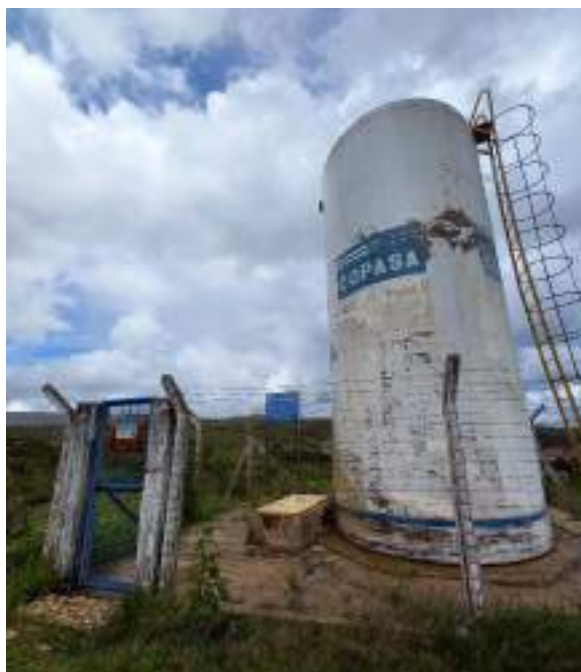
Figura 40 - Reservatório R10 - Cidade Nova.
