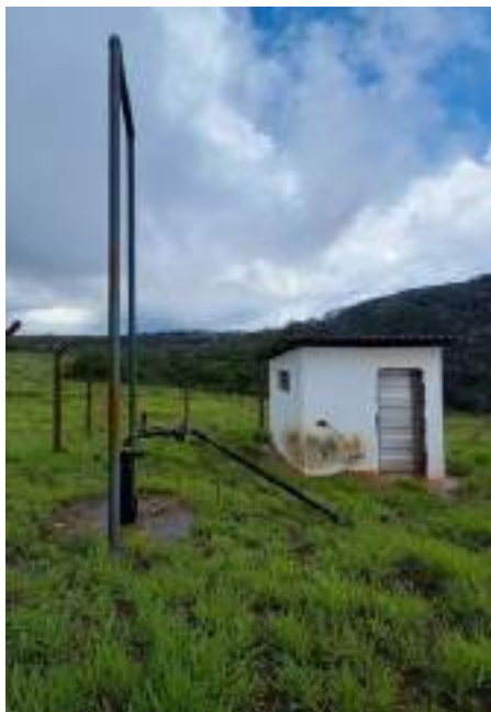
Figura 54 - Poço C01 em Morrinhos. Fonte: Profill Engenharia e Ambiente, 2020.
