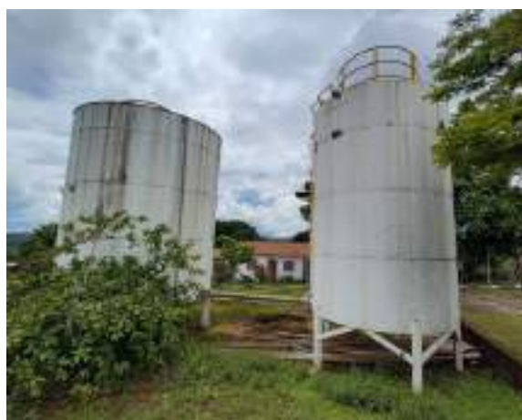
Figura 72 - Reservatórios RAP01 e RAP 02 de Inhaí. Fonte: Profill Engenharia e Ambiente, 2020.
