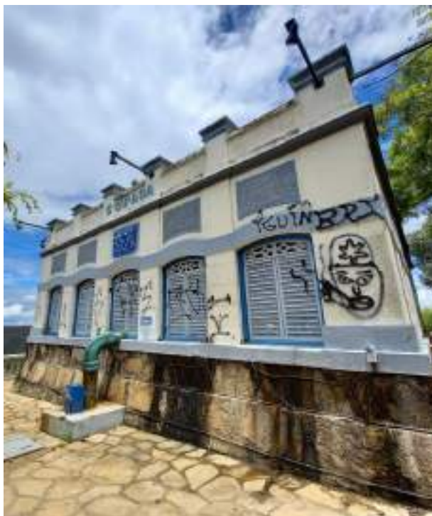
Figura 33 - Reservatório R02 - Grupiara.
