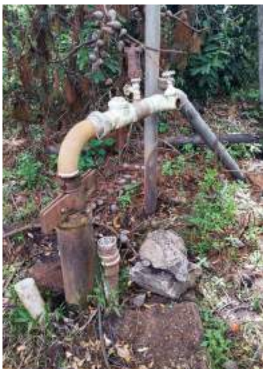
Figura 58 - Poço E01 em São João da Chapada.
