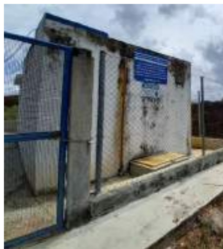
Figura 35 - Reservatório R06 Jardim da Serra.
