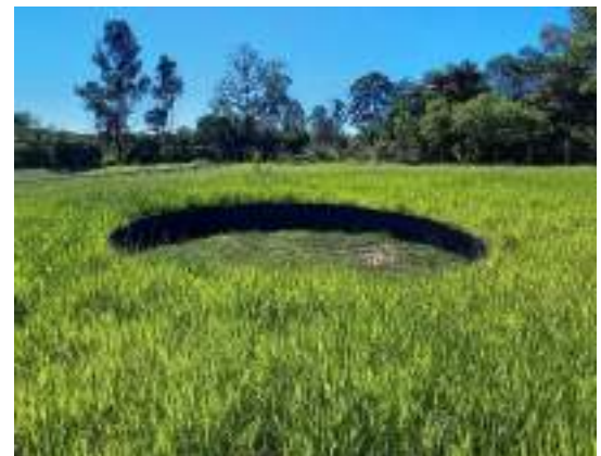
Figura 103 - Leito de secagem da ETE de Conselheiro Mata. Fonte: Profill Engenharia e Ambiente, 2020.
