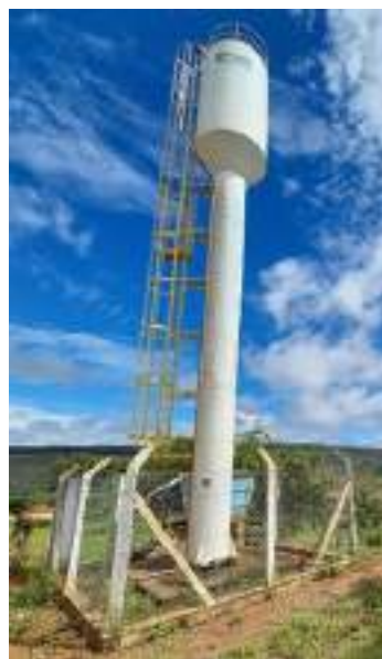
Figura 75 - Reservatório elevado de Senador Mourão.
