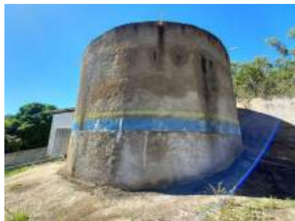
Figura 47 - Reservatório RAP 01 em Conselheiro Mata.
