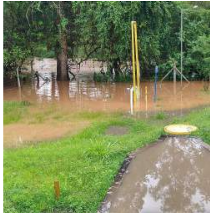
Figura 43 - Área do Poço C05 inundada.
