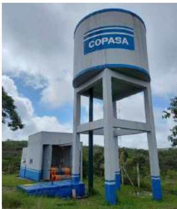
Figura 29 - Reservatório de água para operação da ETA e armazenamento do cloro gasoso. Fonte: Profill Engenharia e Ambiente, 2020.
