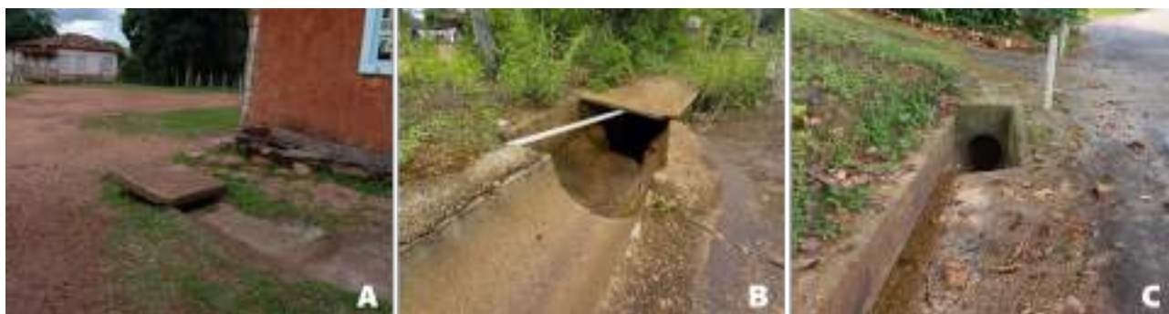
Figura 169 - Microdrenagem nos distritos de Extração (A), Guinda (B) e Senador Mourão (C).
