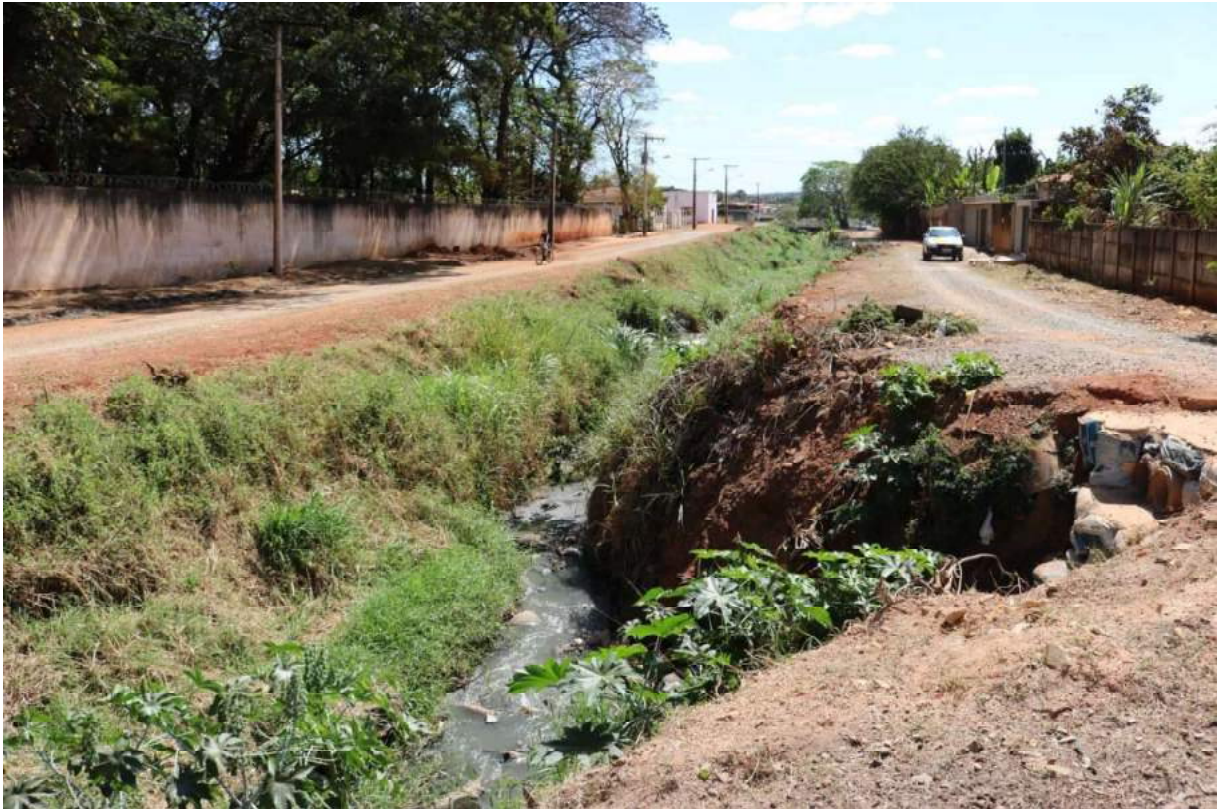
Figura 156 -Ponto de Lançamento de Esgoto Córrego do Beco
