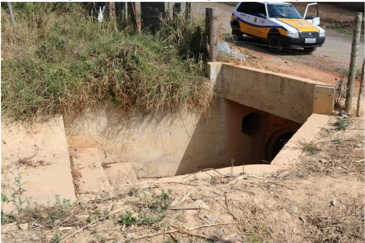
Figura 103 -Reconstrução da Drenagem Do Bairro Champ's
