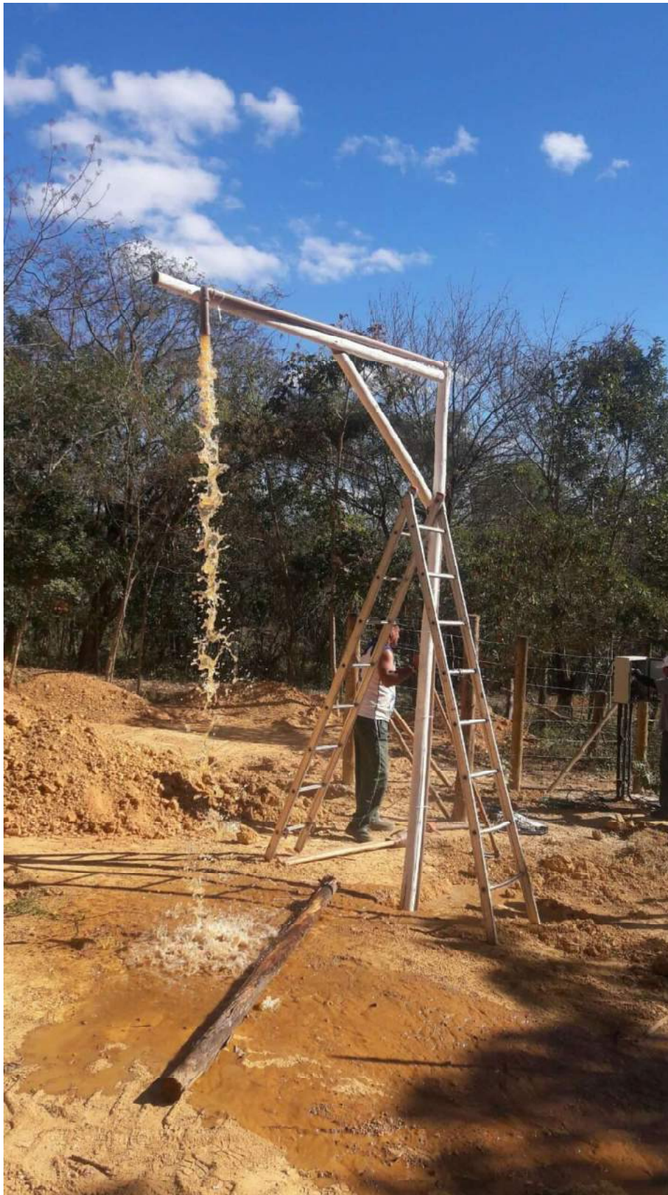
Figura 86 -Poço Artesiano Lajes
