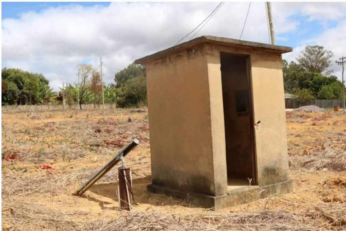
Figura 81- Poço Artesiano Embiruçu
