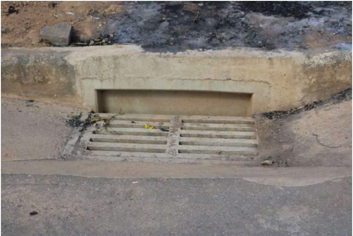
Figura 110 -Reconstrução da Drenagem Do Bairro Champ's
