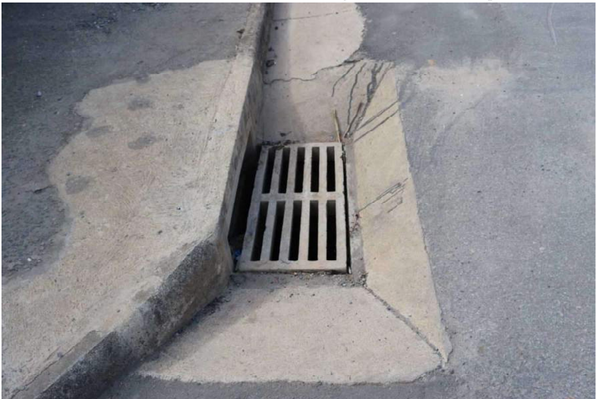
Figura 109 -Reconstrução da Drenagem Do Bairro Champ's
