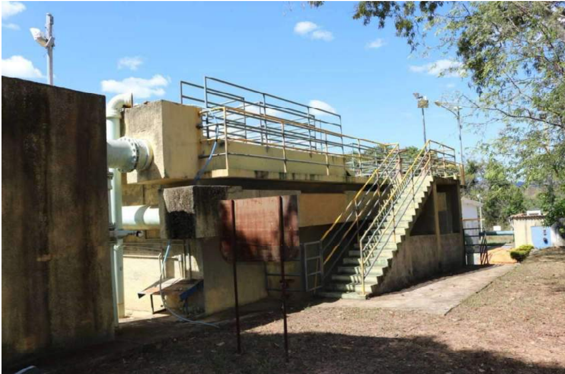
Figura 37-Estação de Tratamento de Água
