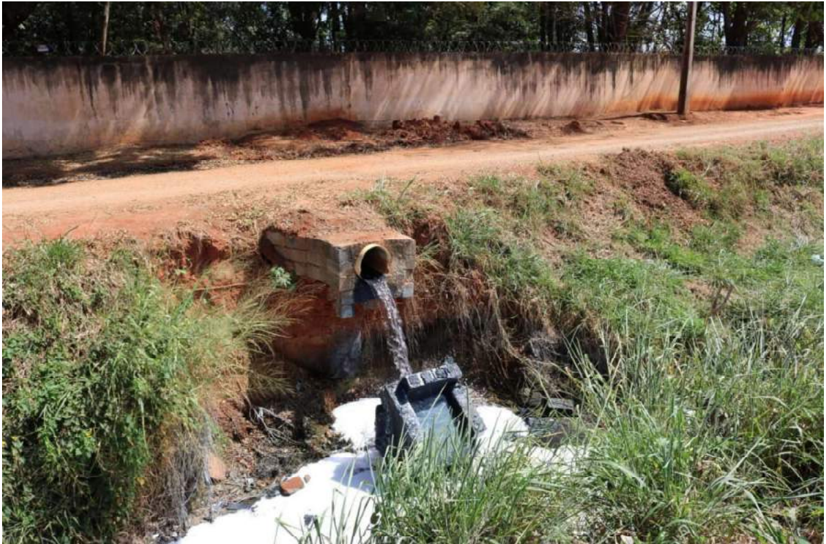
Figura 154 -Ponto de Lançamento de Esgoto Córrego do Beco
