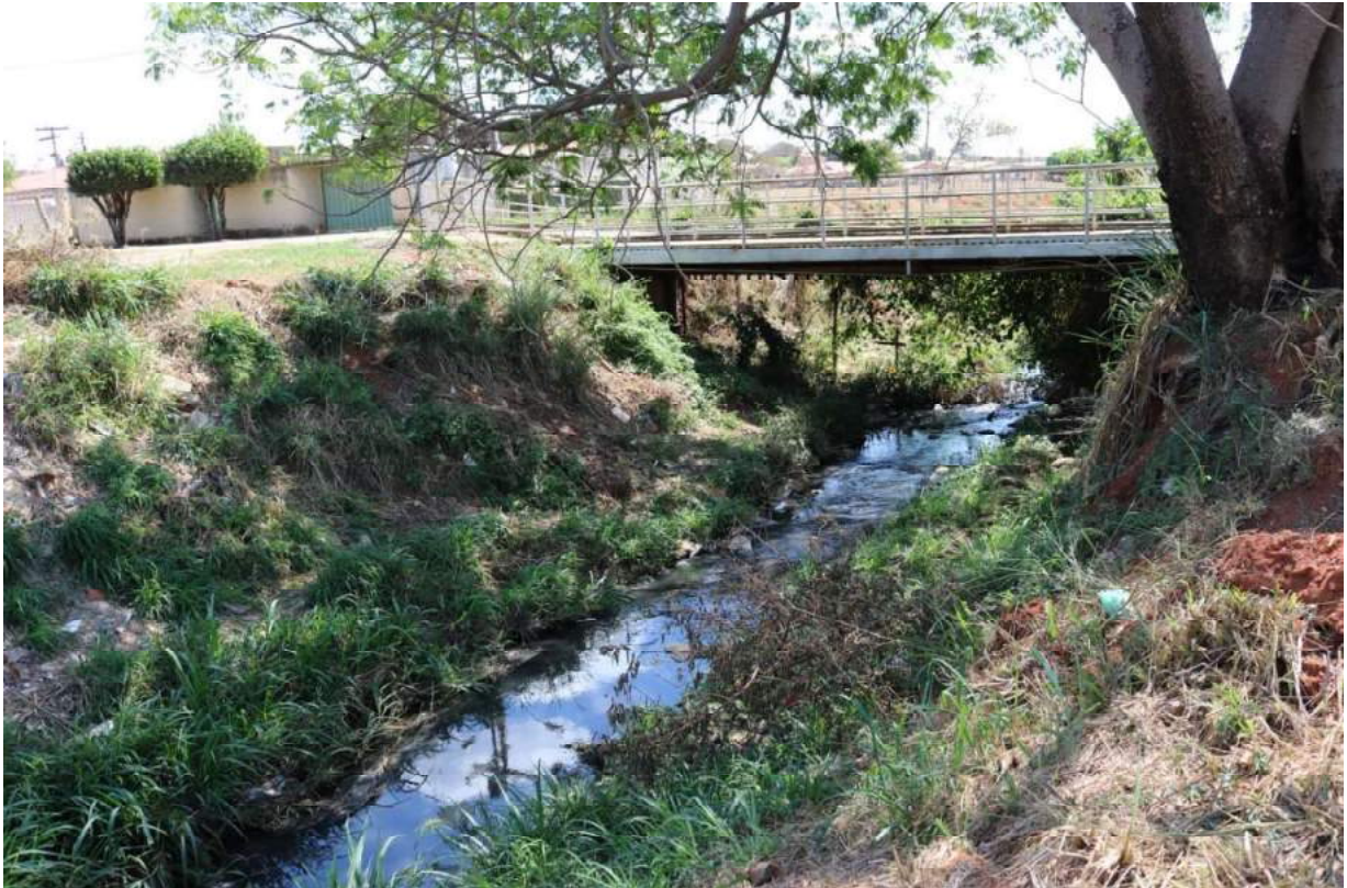
Figura 152 -Ponto de Lançamento de Esgoto Córrego do Beco
