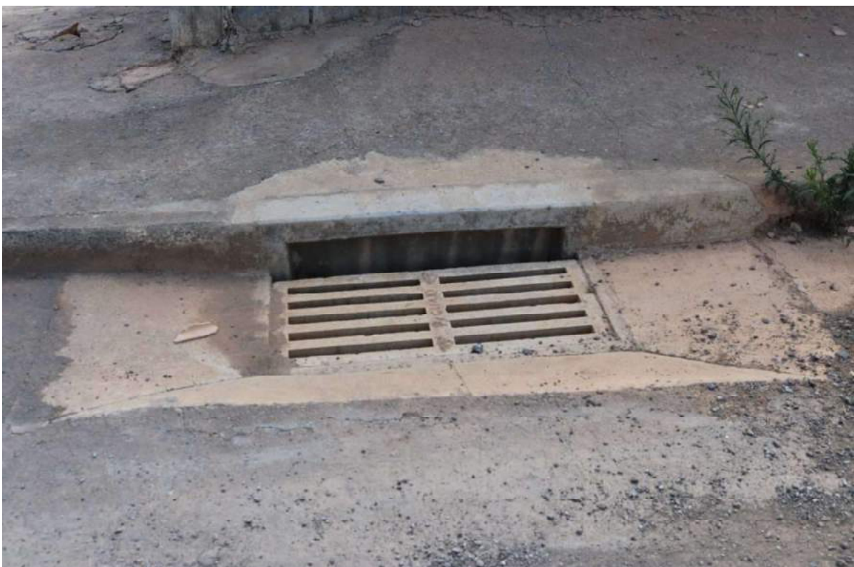
Figura 105 -Reconstrução da Drenagem Do Bairro Champ's
