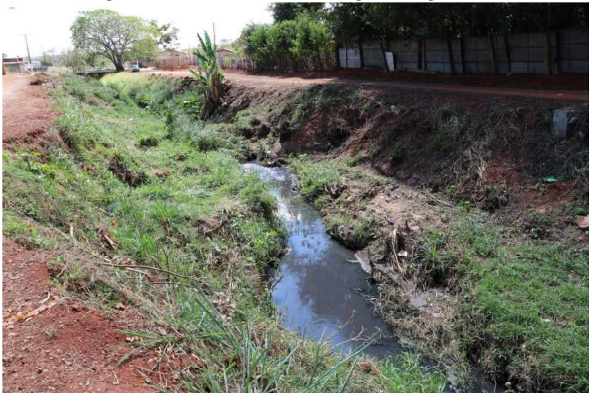
Figura 149-Ponto de Lançamento de Esgoto Córrego do Beco
