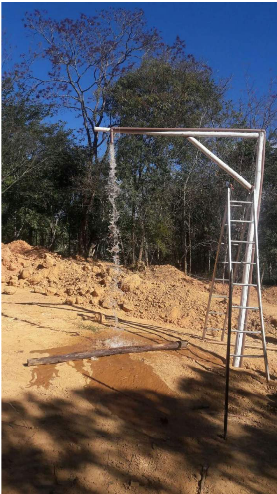
Figura 85 2-Poço Artesiano Lajes
