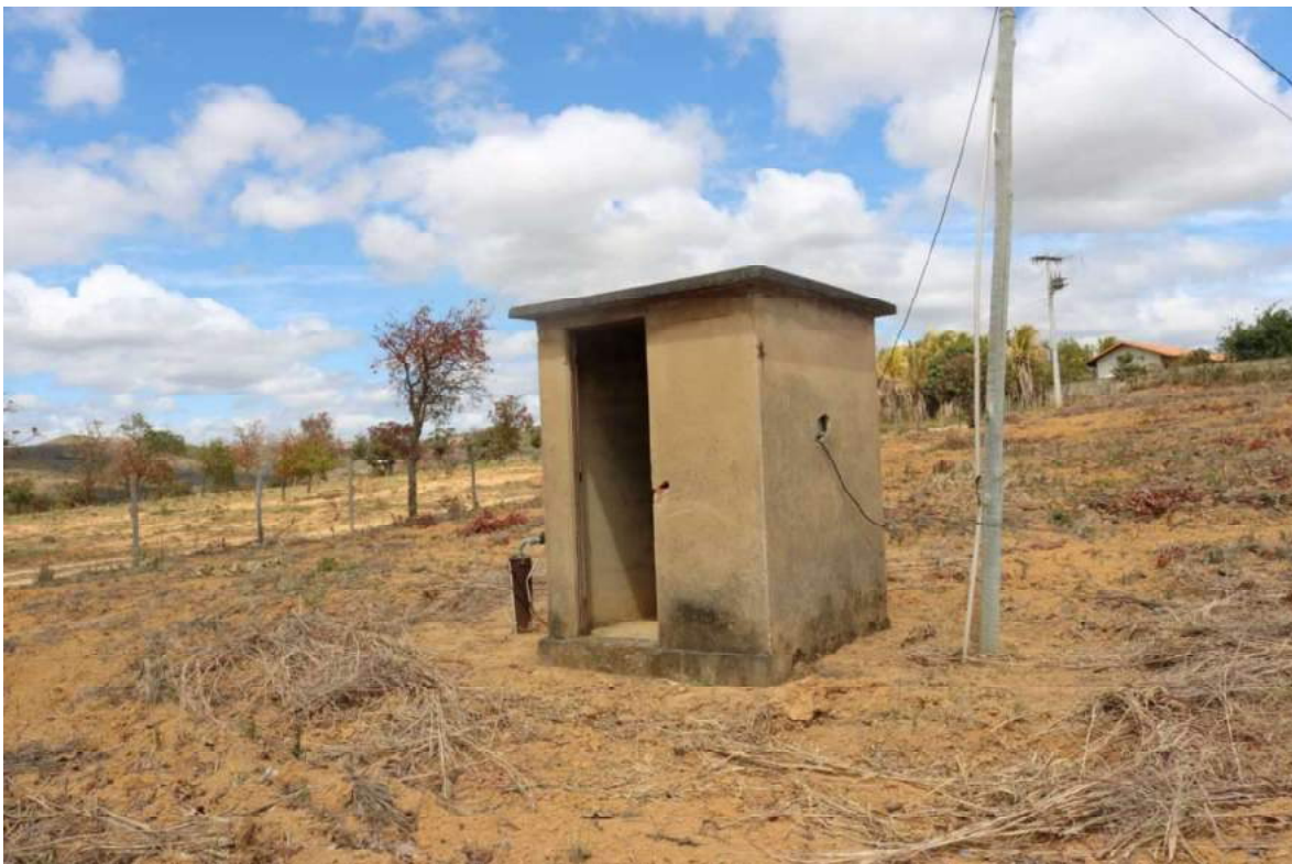
Figura 83 -Poço Artesiano Embiruçu
