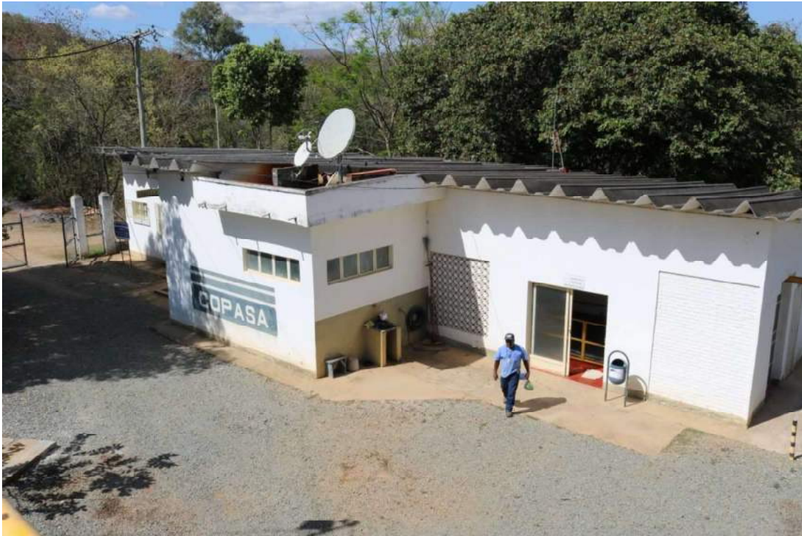
Figura 41-Estação de Tratamento de Água
