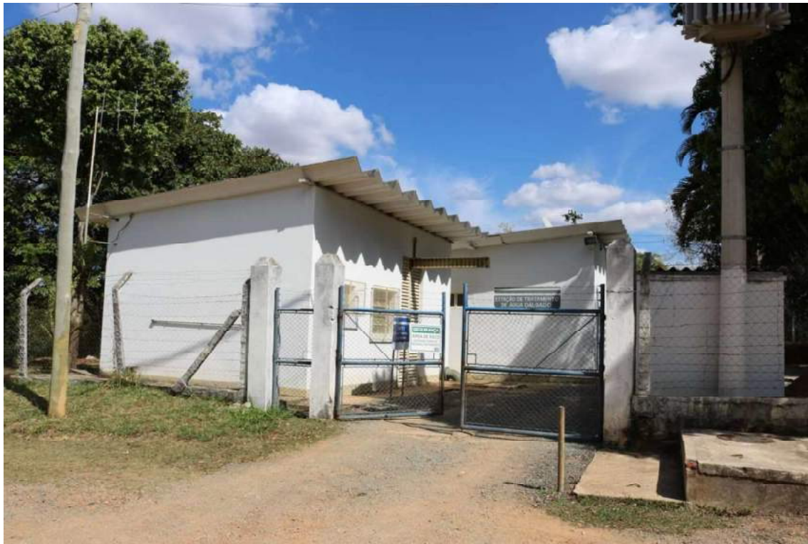
Figura 35-Estação de Tratamento de Água
