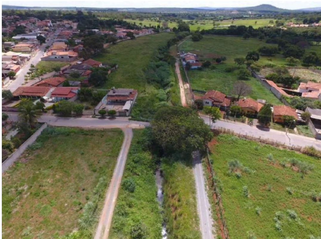
Figura 141 -Ponto de Lançamento de Esgoto Córrego do Beco
