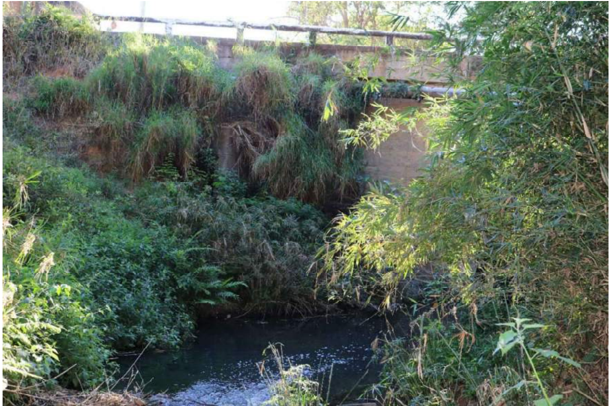
Figura 136 -Ponto de Lançamento de Esgoto Córrego Cedro
