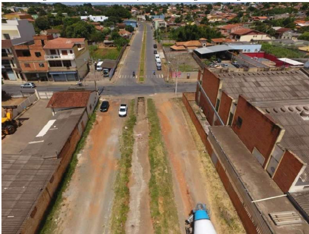
Figura 138 -Ponto de Lançamento de Esgoto Córrego do Beco
