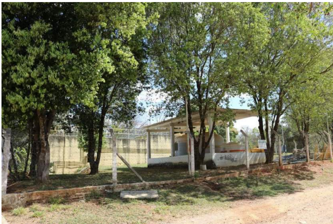
Figura 40-Estação de Tratamento de Água
