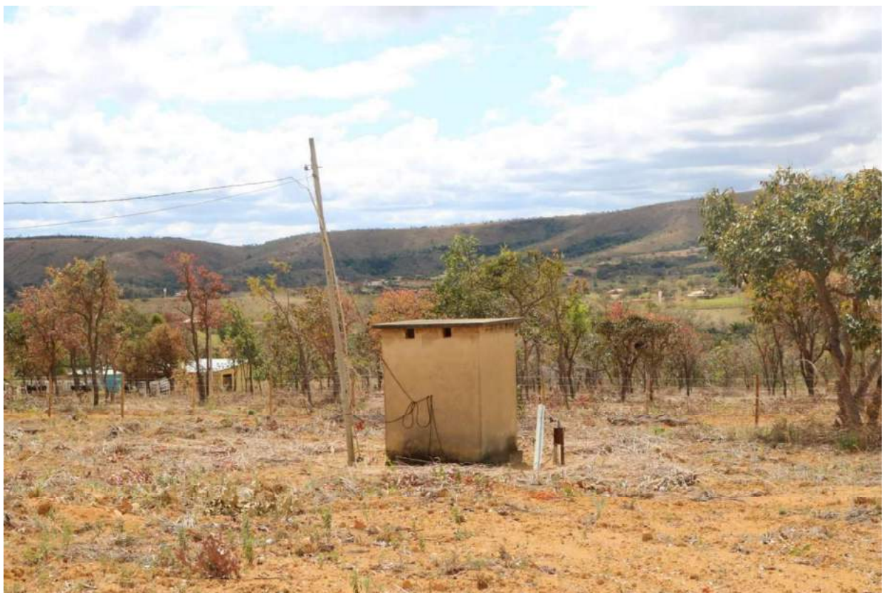
Figura 79-Poço Artesiano Embiruçu
