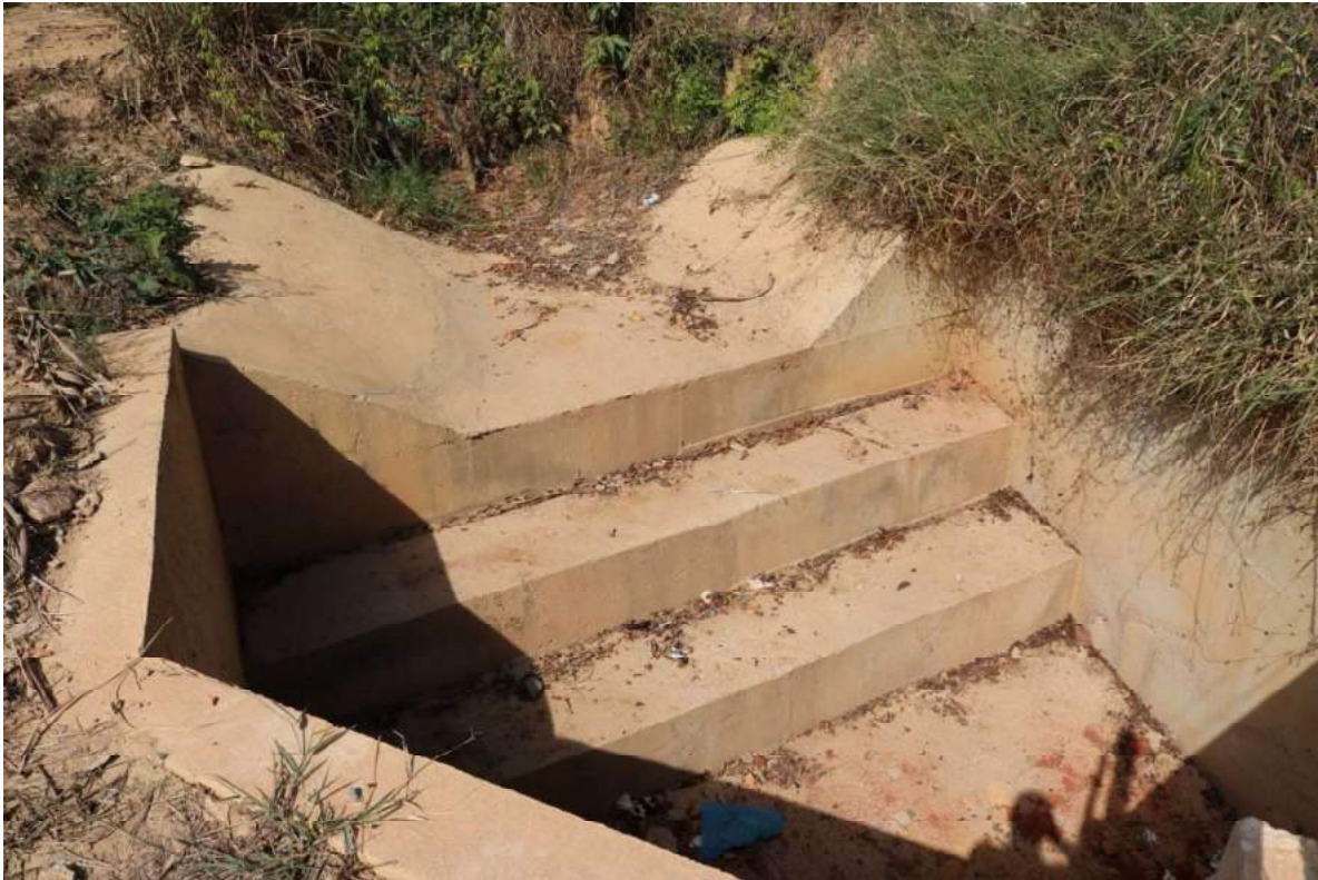
Figura 104 -Reconstrução da Drenagem Do Bairro Champ's
