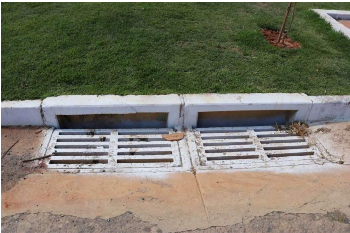
Figura 107 -Reconstrução da Drenagem Do Bairro Champ's
