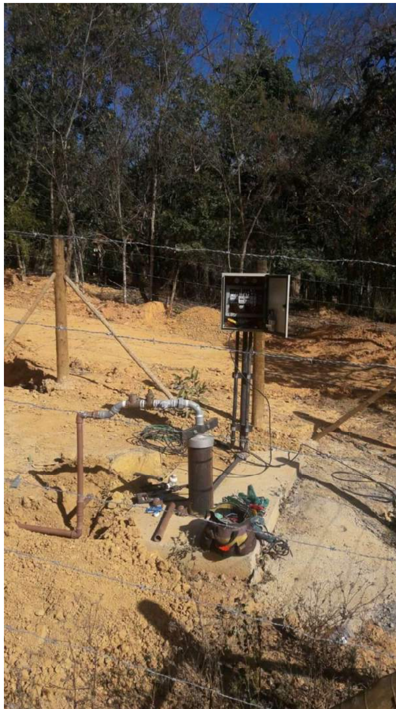
Figura 84 -Poço Artesiano Lajes
