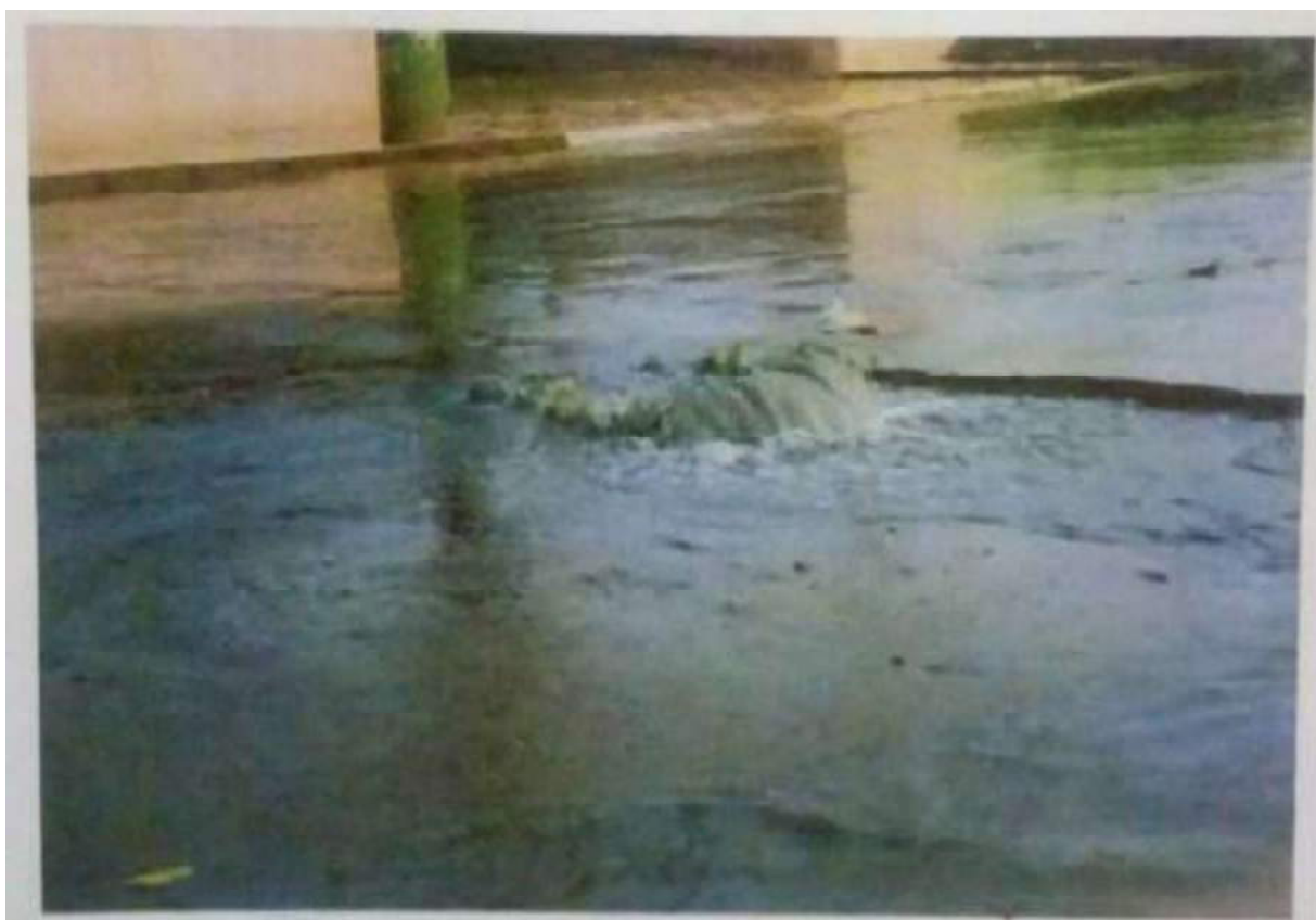
Figura 173 -Vista de Transbordamento causado por água pluvial em PV da rede de esgoto localizado na Rua Tiradentes esquina com Rua Vitor Rocha.
