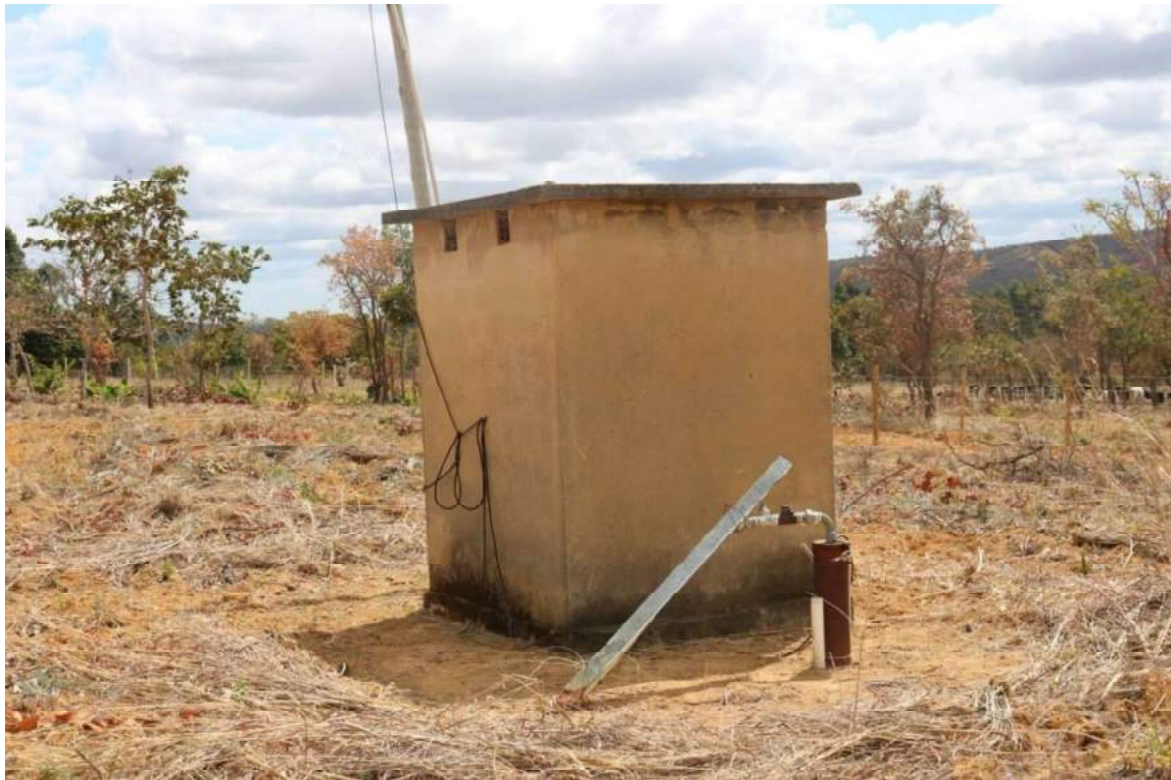
Figura 80- Poço Artesiano Embiruçu
