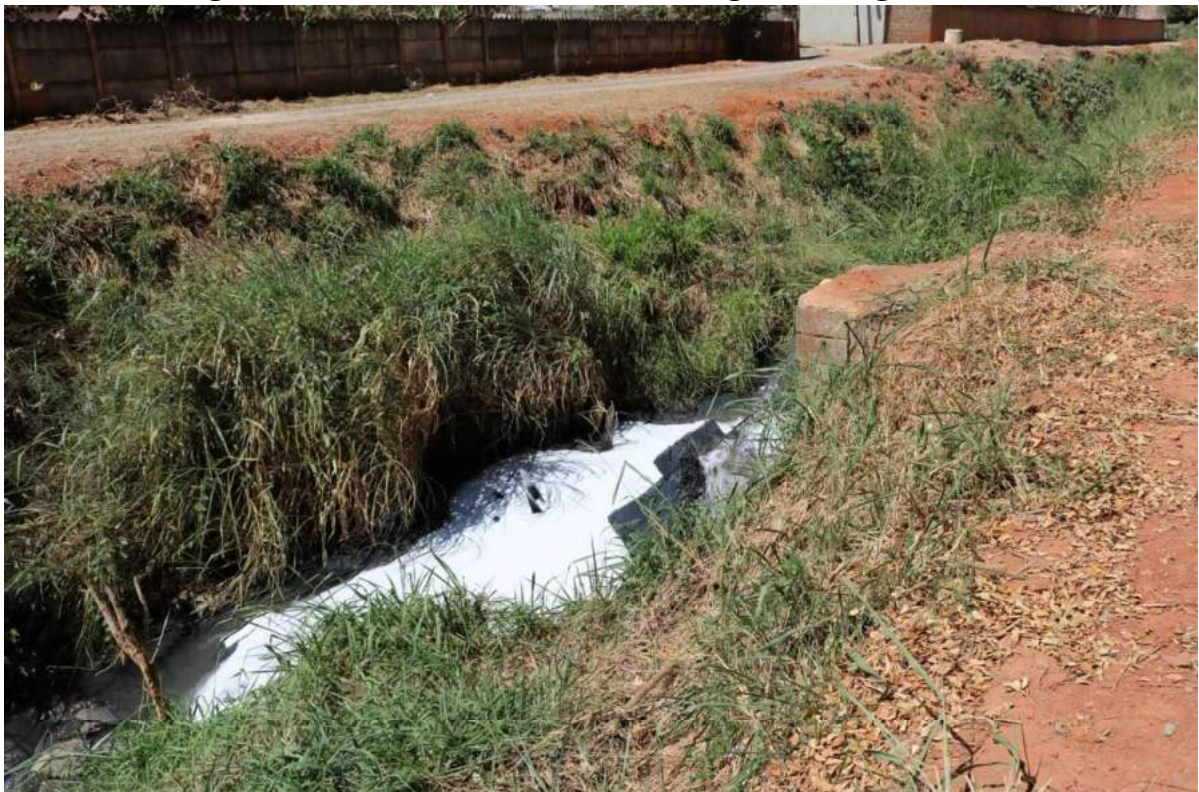
Figura 147 -Ponto de Lançamento de Esgoto Córrego do Beco
