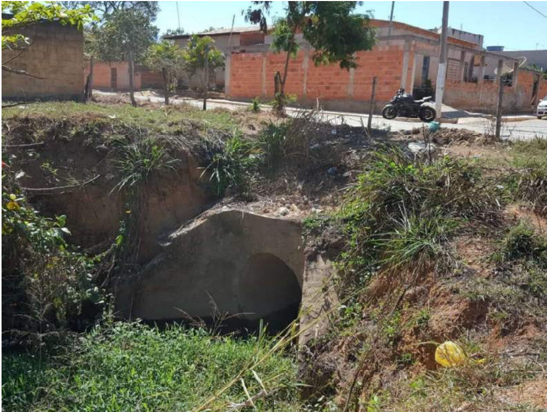
Figura 112 -Reconstrução da Drenagem Do Bairro Champ's
