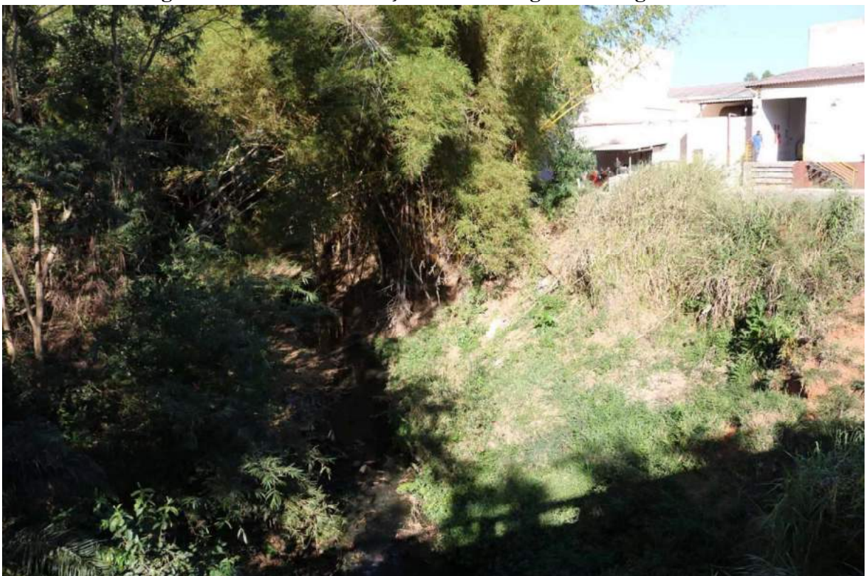
Figura 133 -Ponto de Lançamento de Esgoto Córrego Cedro
