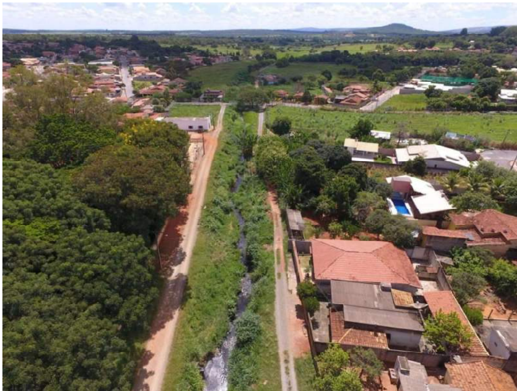
Figura 140 -Ponto de Lançamento de Esgoto Córrego do Beco
