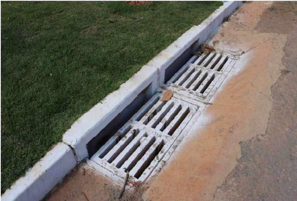
Figura 106 -Reconstrução da Drenagem Do Bairro Champ's
