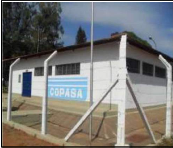
EAT 3 Estação Elevatória de Água Tratada Beco Matias
