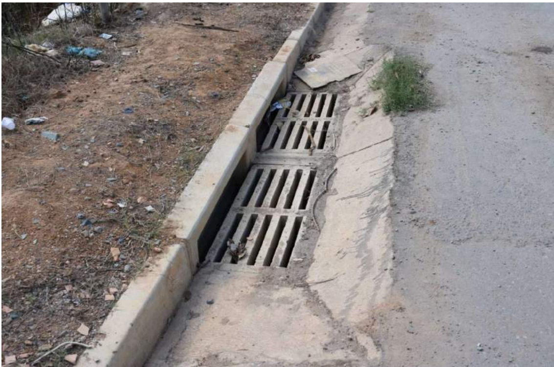
Figura 111-Reconstrução da Drenagem Do Bairro Champ's
