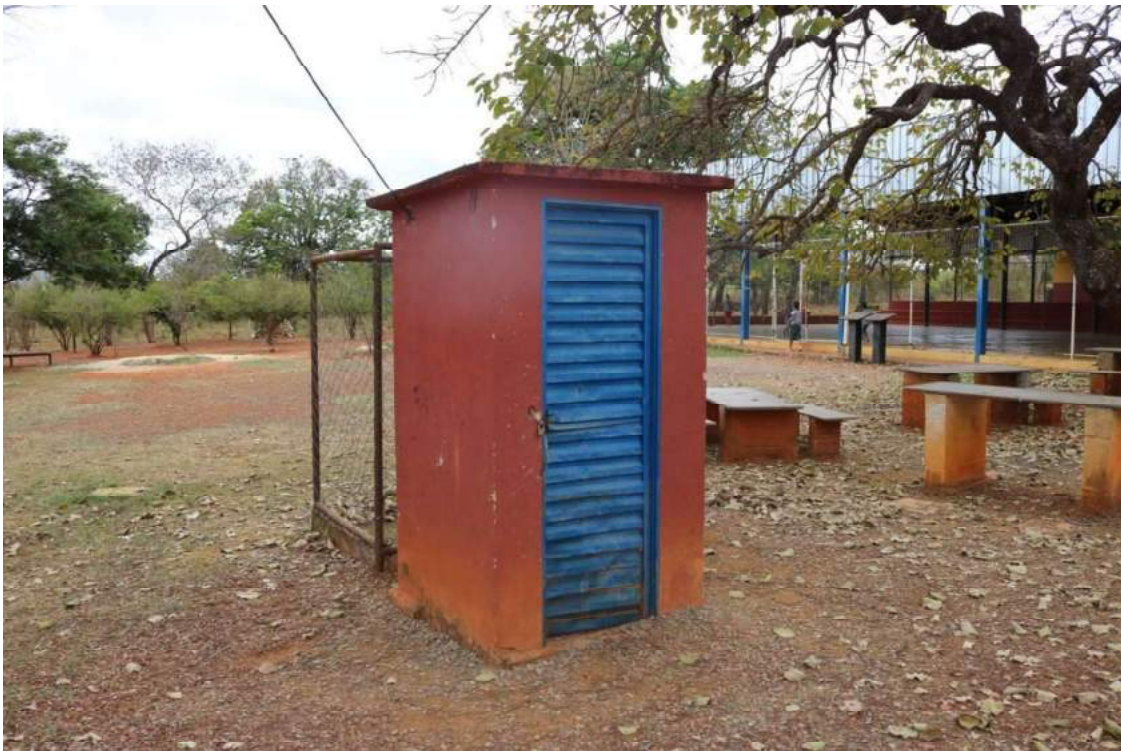
Figura 61-Poço Artesiano Picada
