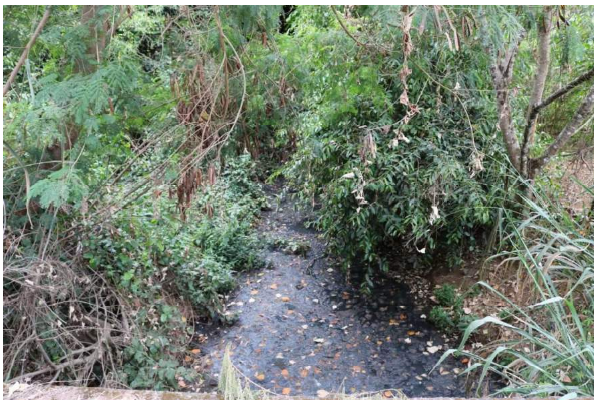
Figura 125 -Ponto de Lançamento de Esgoto Córrego Matias
