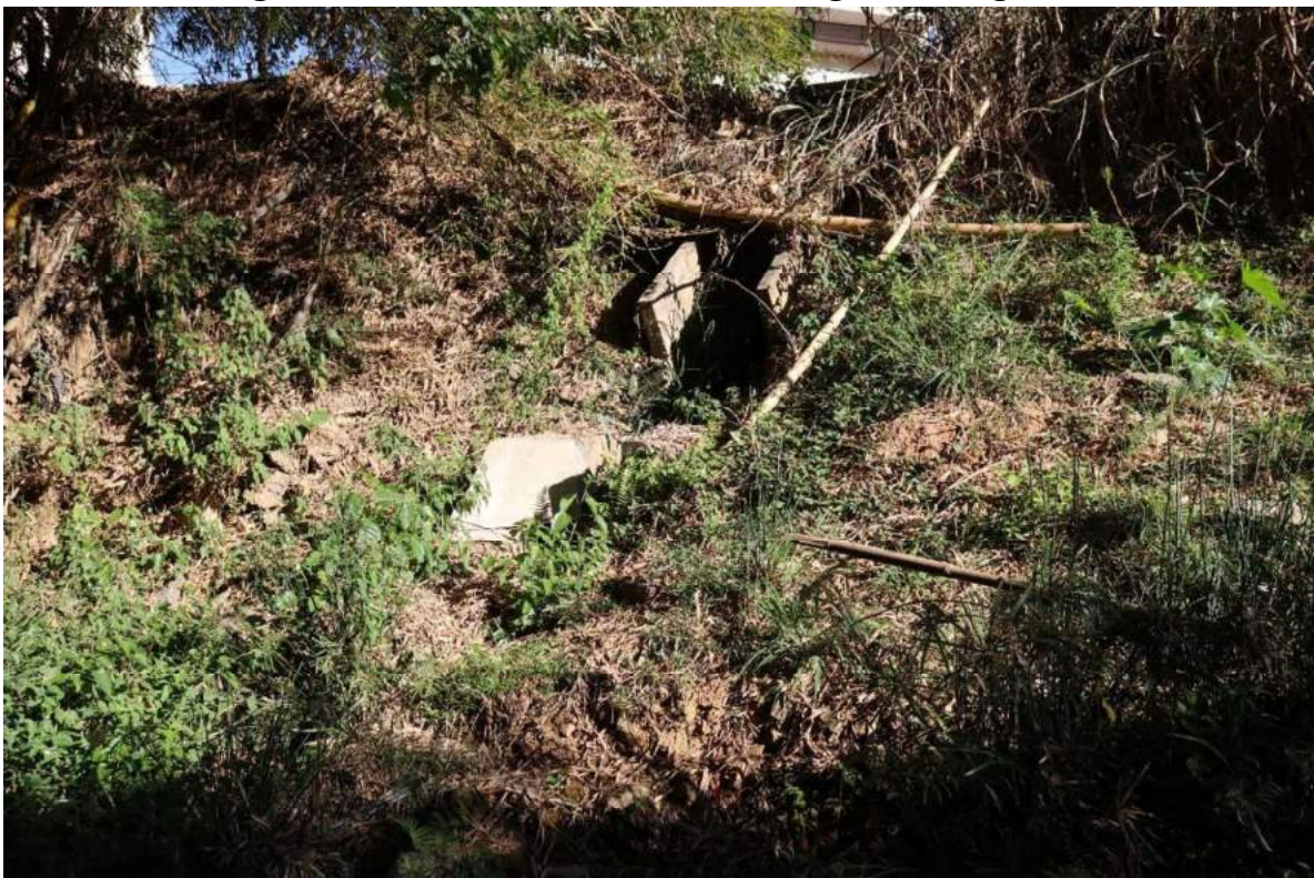
Figura 137 -Ponto de Lançamento de Esgoto Córrego Cedro
