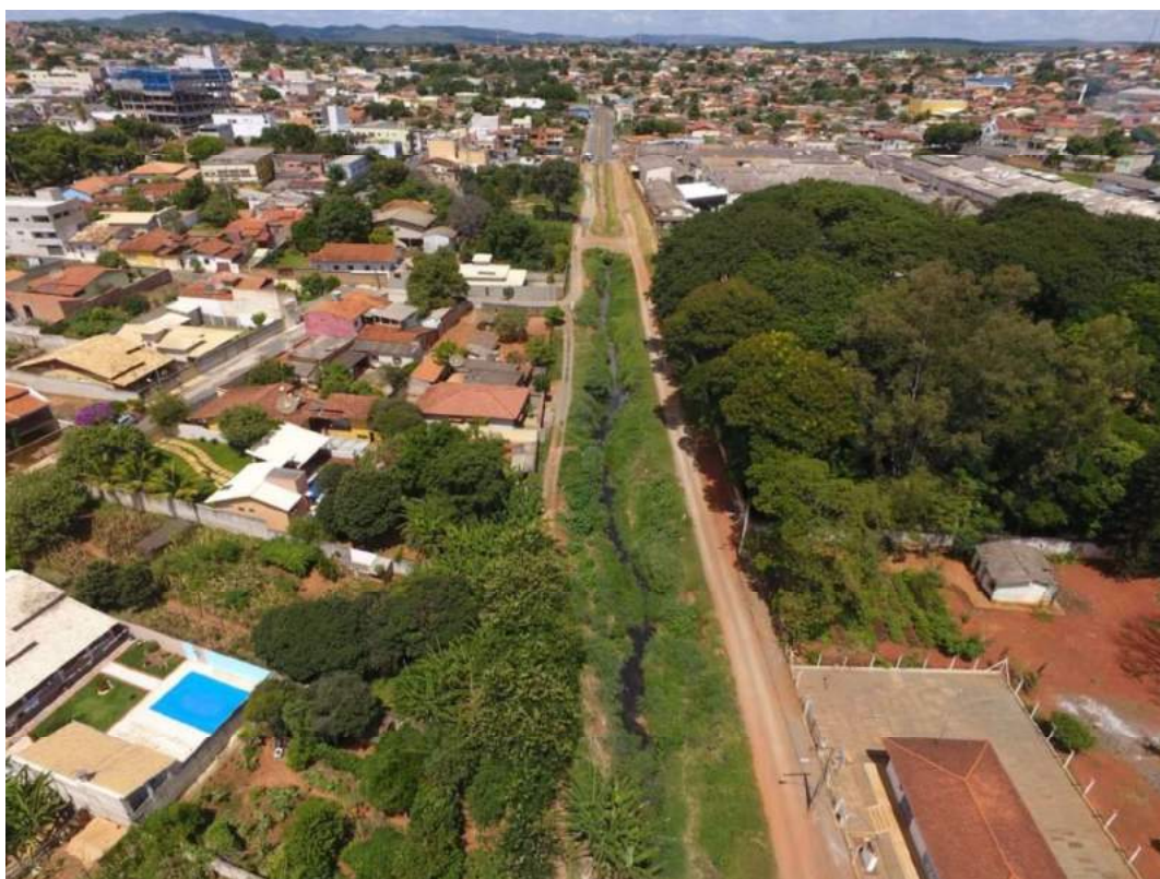
Figura 139 -Ponto de Lançamento de Esgoto Córrego do Beco
