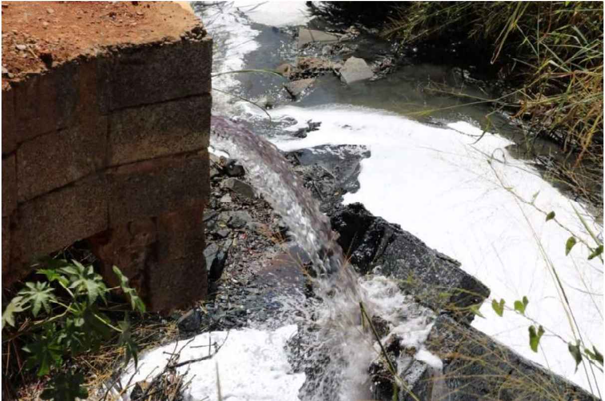
Figura 146-Ponto de Lançamento de Esgoto Córrego do Beco
