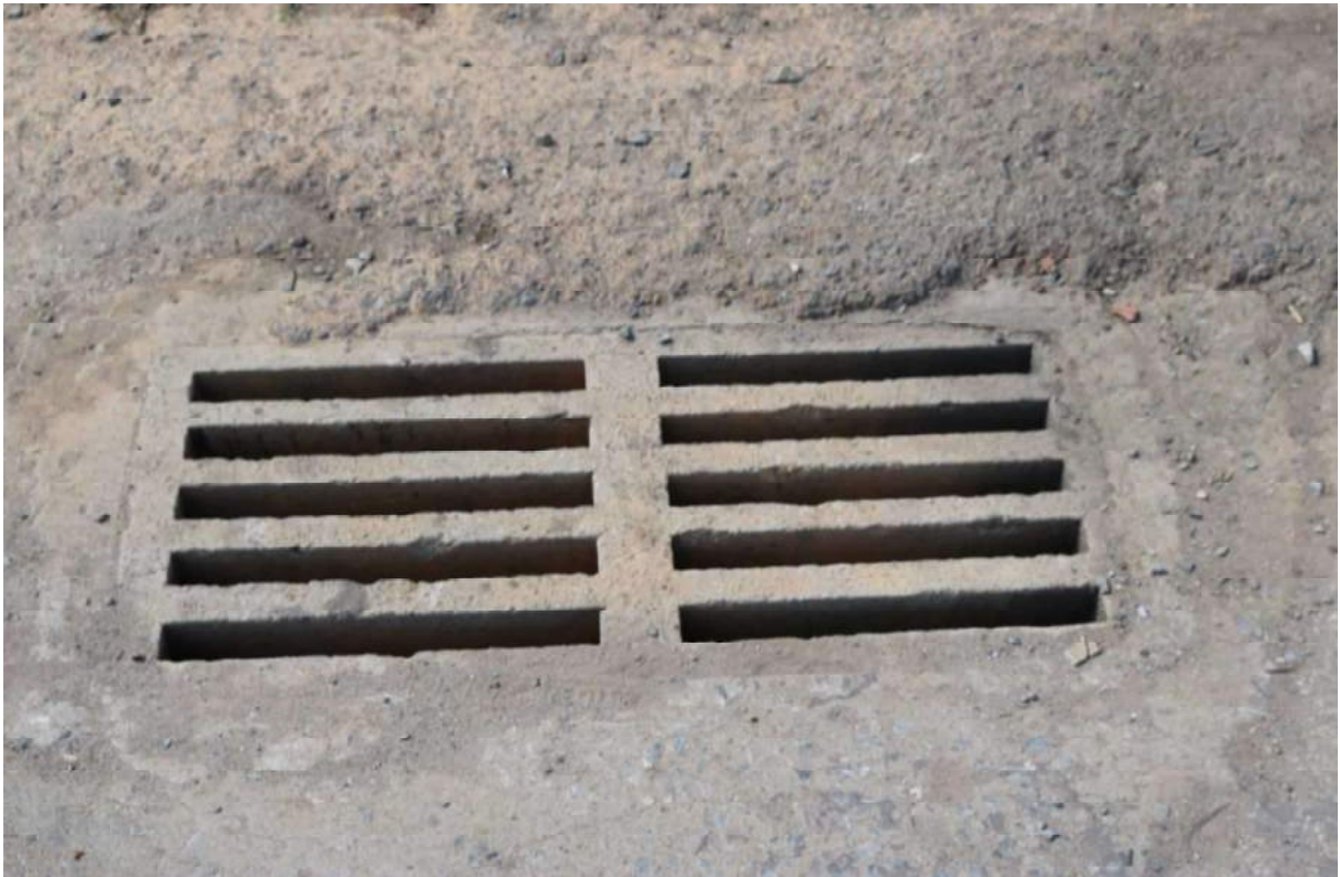
Figura 108 -Reconstrução da Drenagem Do Bairro Champ's
