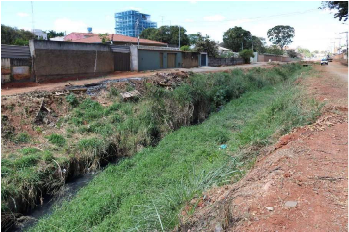
Figura 150 -Ponto de Lançamento de Esgoto Córrego do Beco
