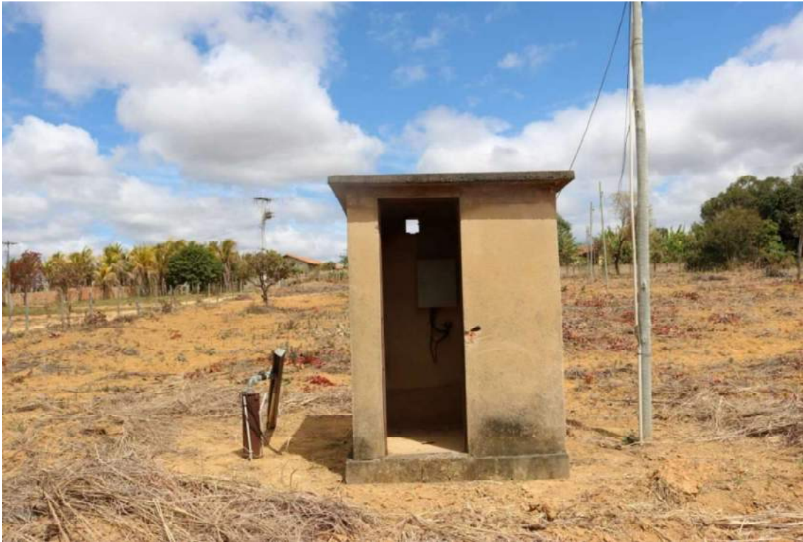
Figura 82 -Poço Artesiano Embiruçu
