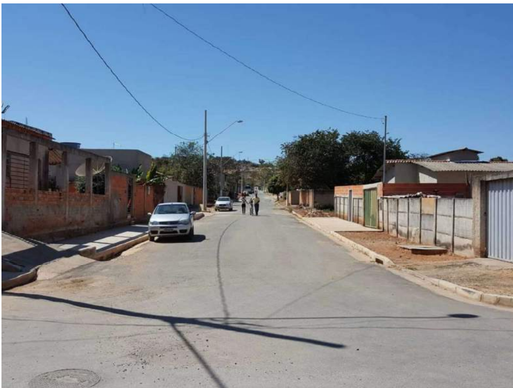
Figura 113 -Reconstrução da Drenagem Do Bairro Champ's-
