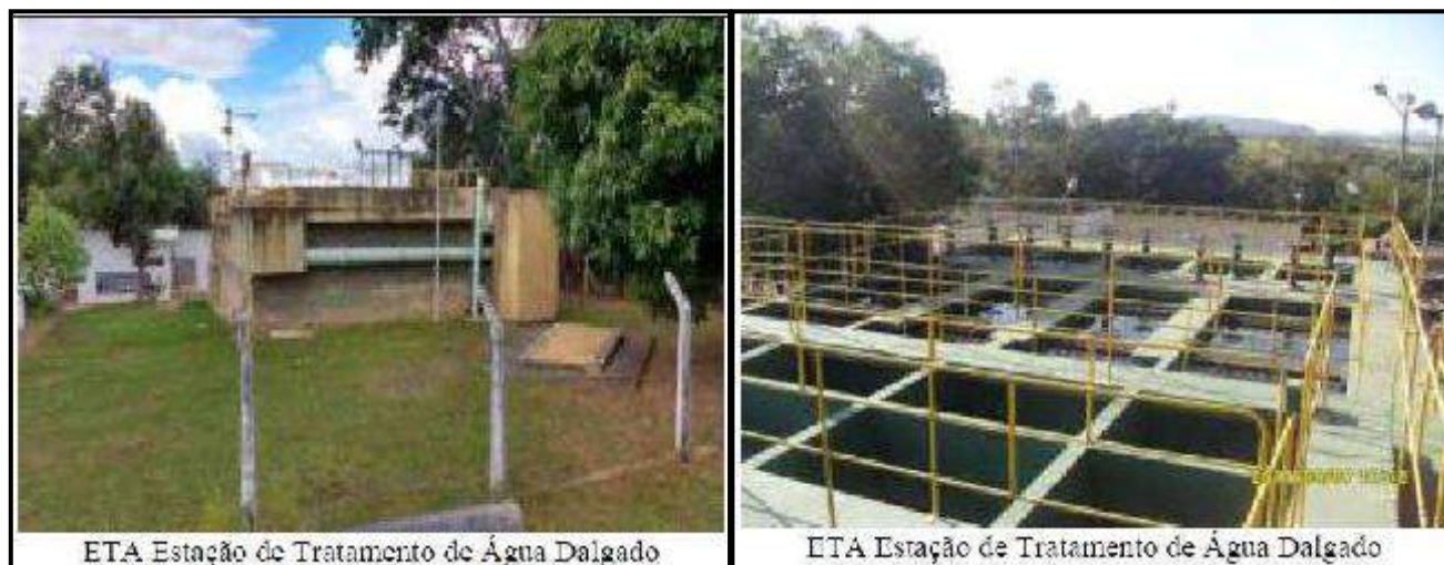
Figura 90-Estação de Tratamento de Água Dalgado
