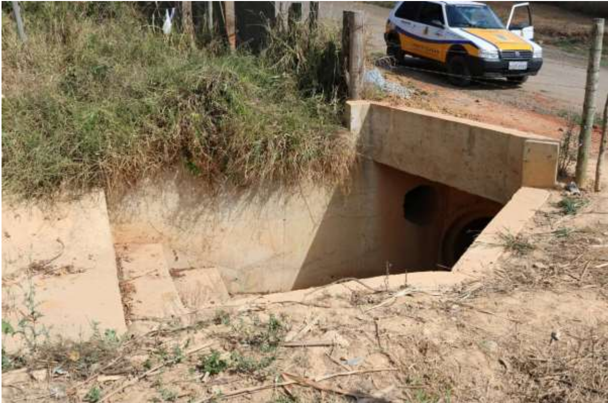
Figura 143-Reconstrução da Drenagem Do Bairro Champ's
