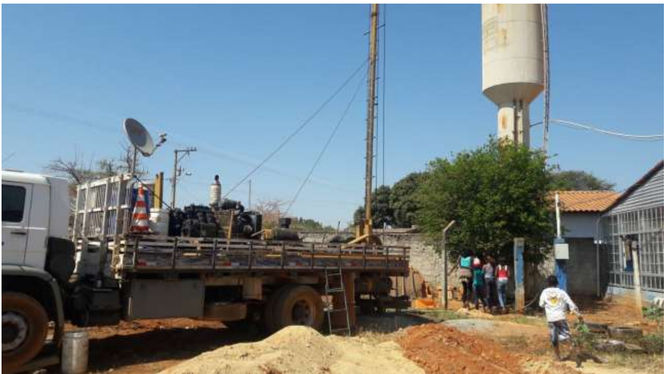
Figura 131-Poço Artesiano Pontinha
