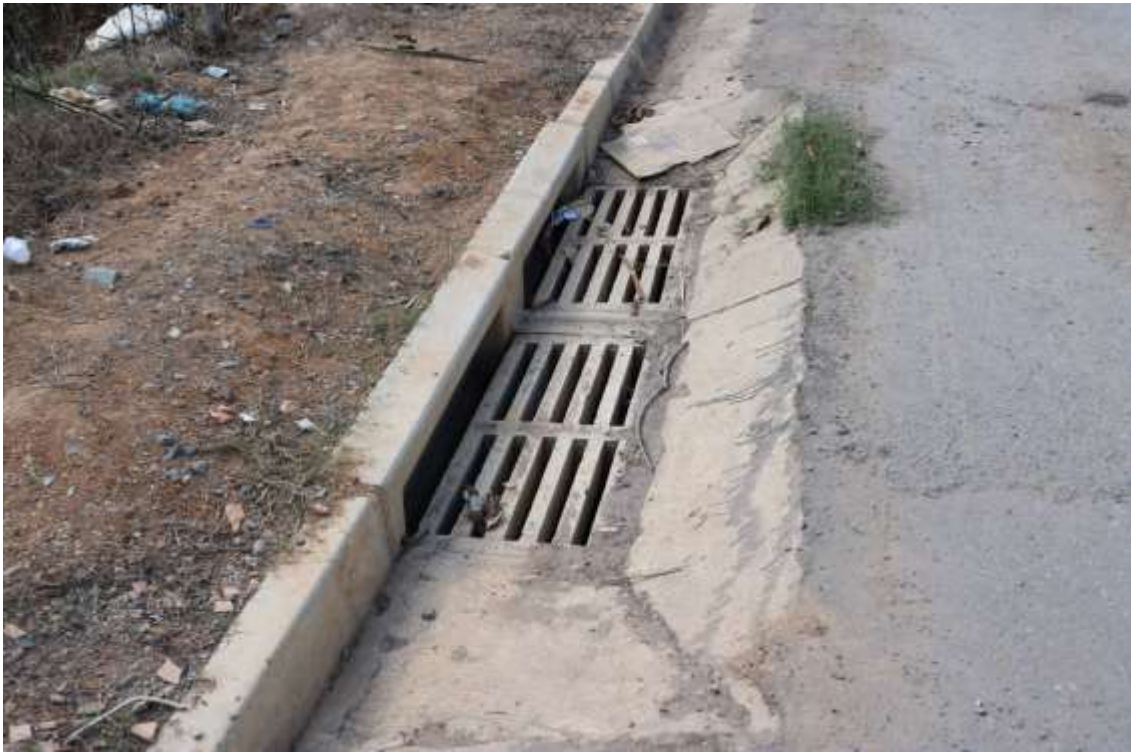
Figura 151-Reconstrução da Drenagem Do Bairro Champ's
