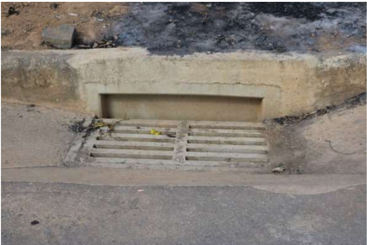
Figura 150-Reconstrução da Drenagem Do Bairro Champ's
