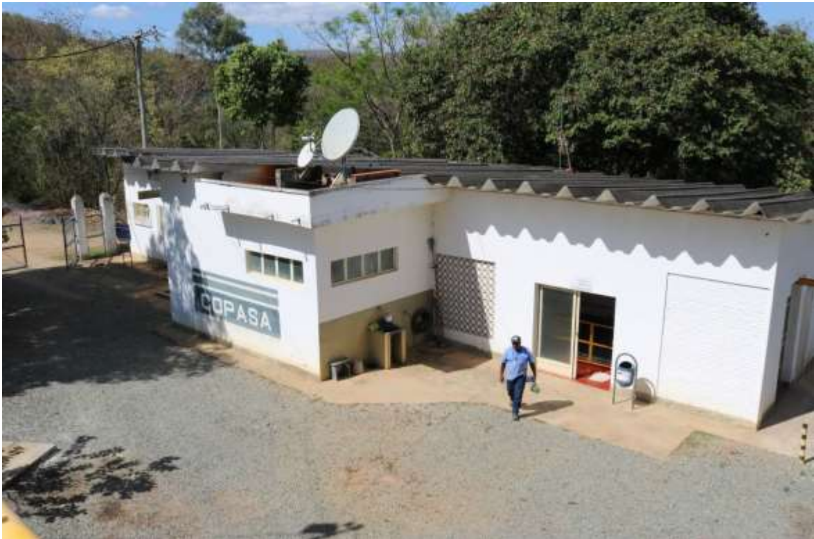
Figura 80-Estação de Tratamento de Água
