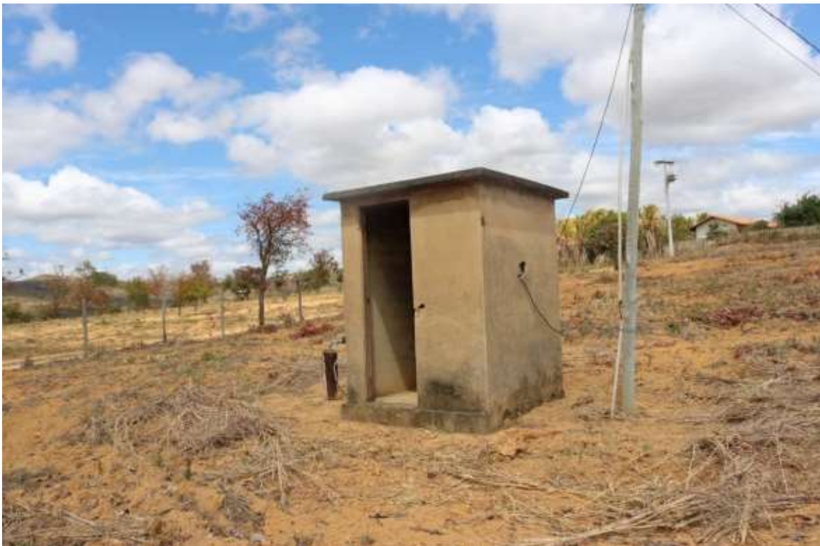
Figura 123-Poço Artesiano Embiruçu
