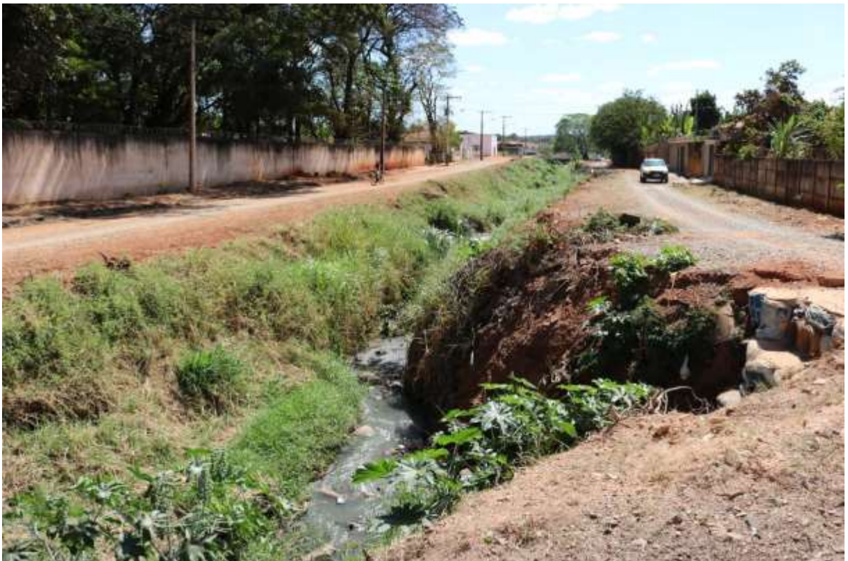
Figura 196-Ponto de Lançamento de Esgoto Córrego do Beco
