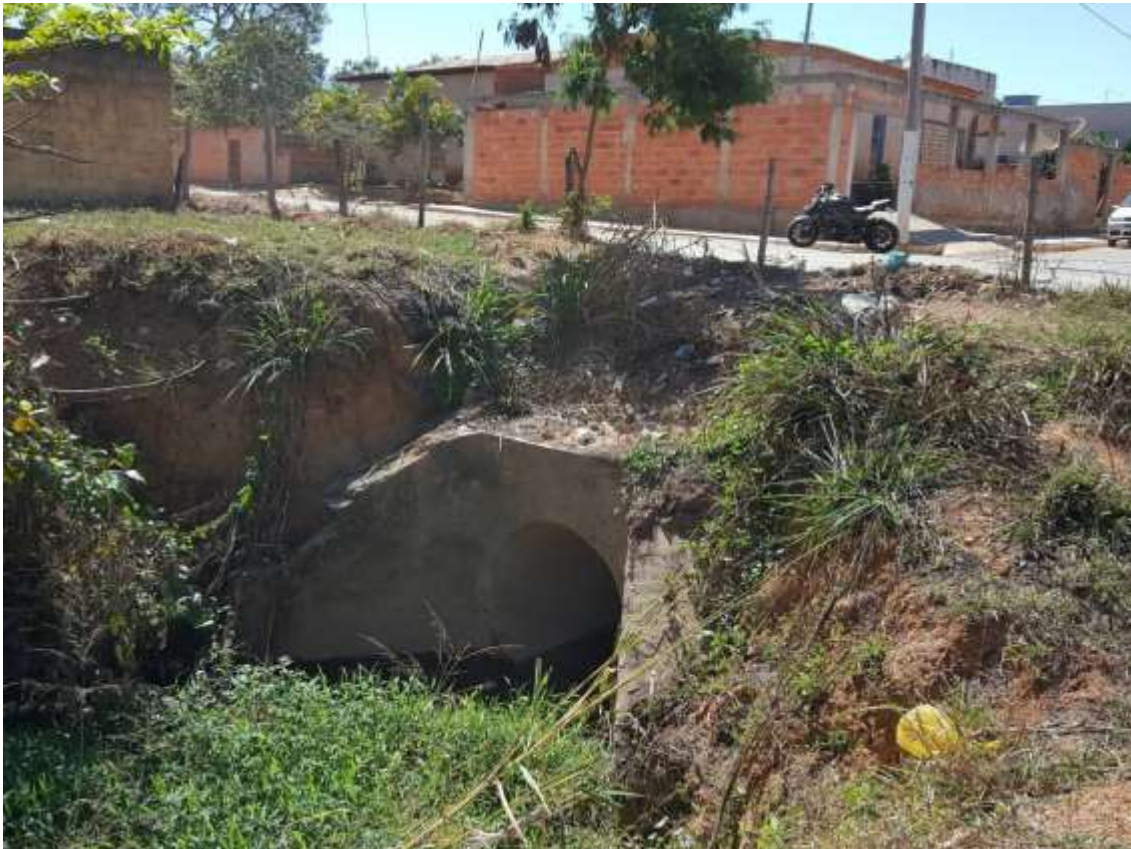
Figura 152-Reconstrução da Drenagem Do Bairro Champ's
