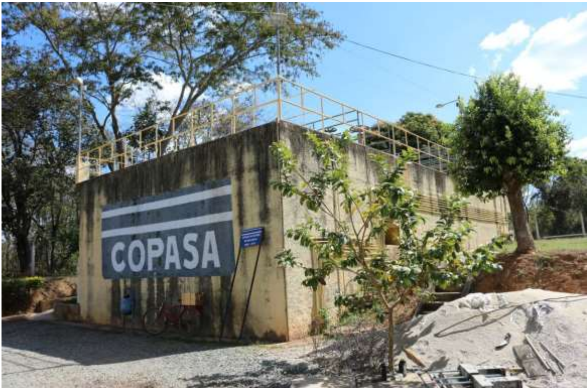
Figura 75-Estação de Tratamento de Água
