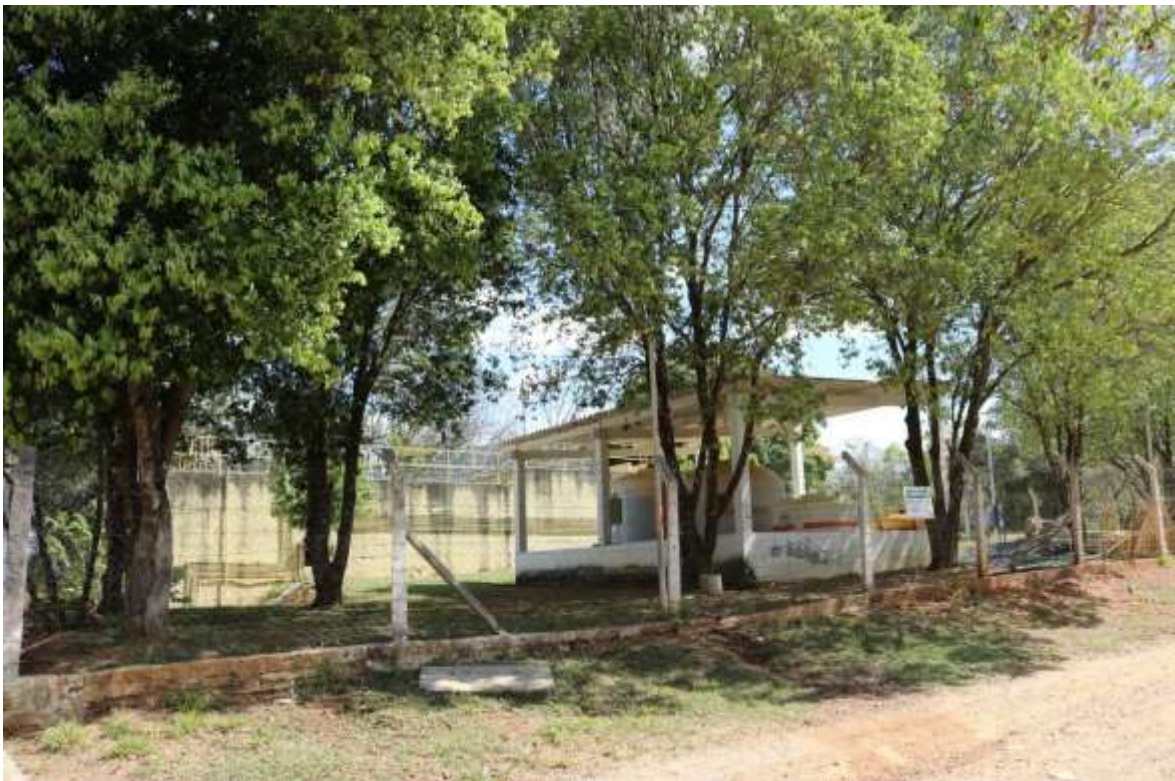
Figura 79-Estação de Tratamento de Água
