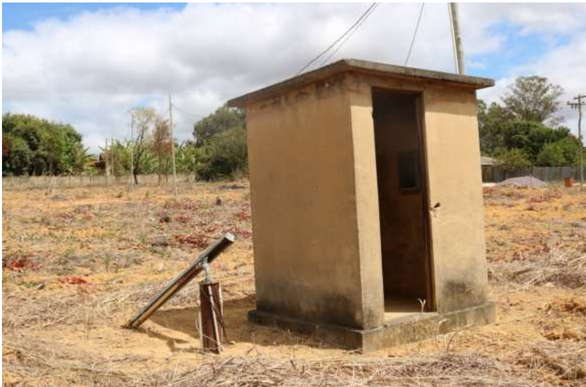
Figura 121-Poço Artesiano Embiruçu
