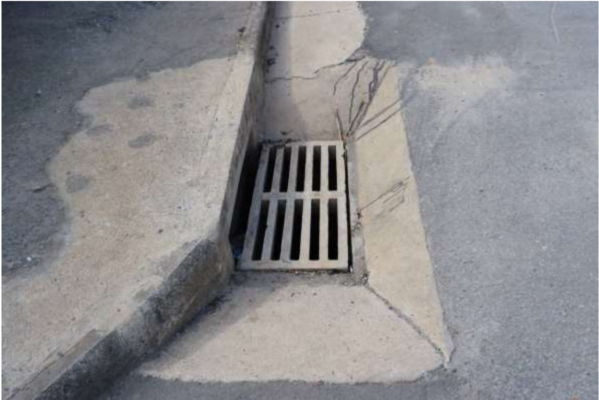
Figura 149-Reconstrução da Drenagem Do Bairro Champ's
