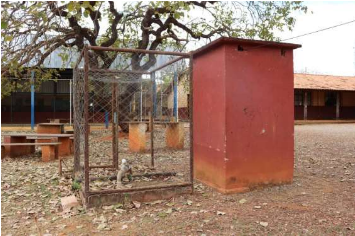
Figura 100-Poço Artesiano Picada
