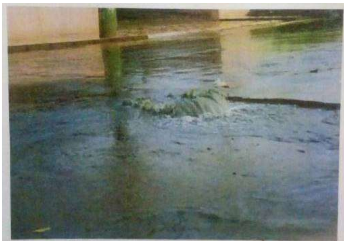
Figura 213-Vista de Transbordamento causado por água pluvial em PV da rede de esgoto localizado na Rua Tiradentes esquina com Rua Vitor Rocha.
