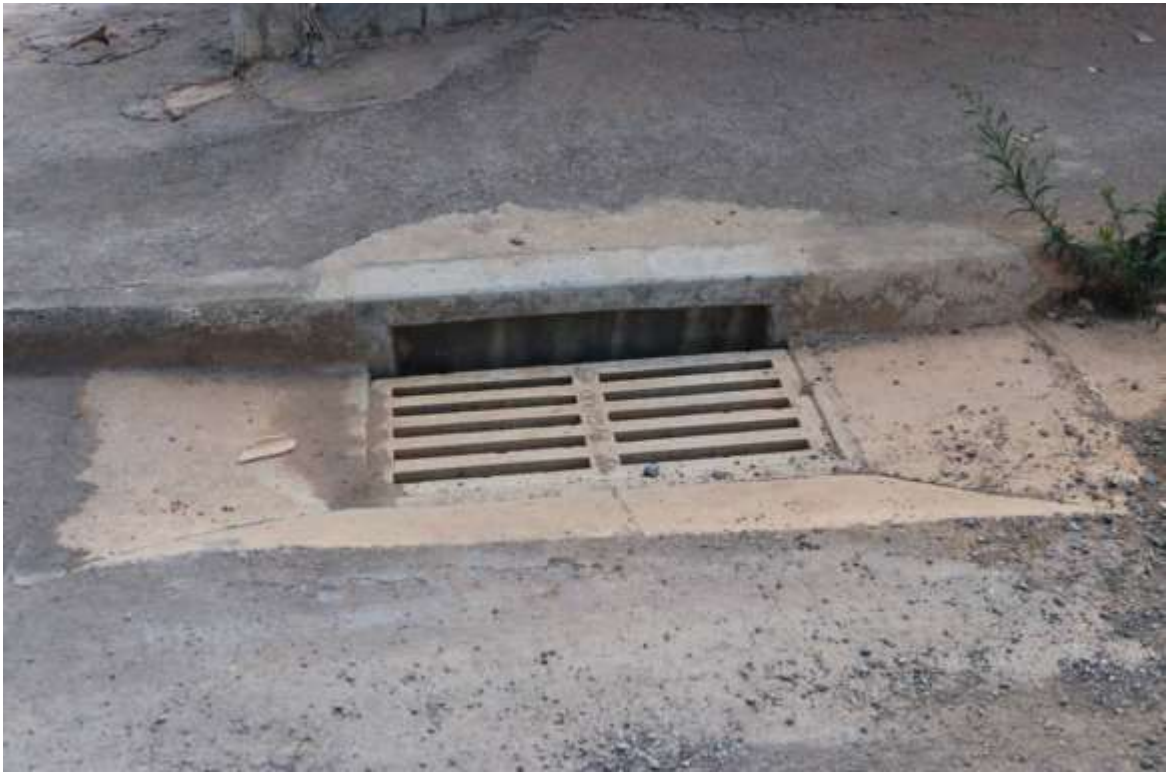
Figura 145-Reconstrução da Drenagem Do Bairro Champ's
