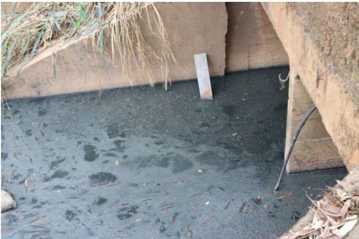
Figura 163-Ponto de Lançamento de Esgoto Córrego Matias
