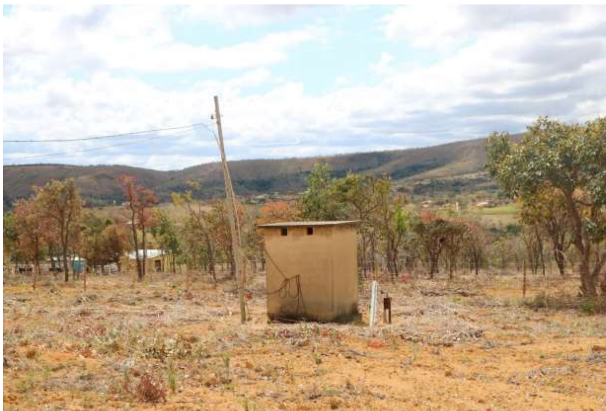
Figura 119-Poço Artesiano Embiruçu
