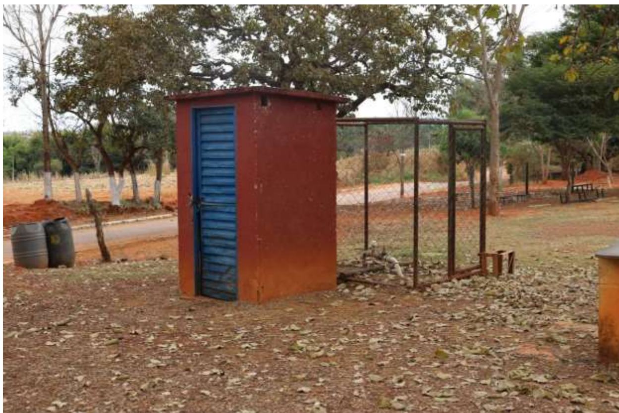
Figura 97-Poço Artesiano Picada
