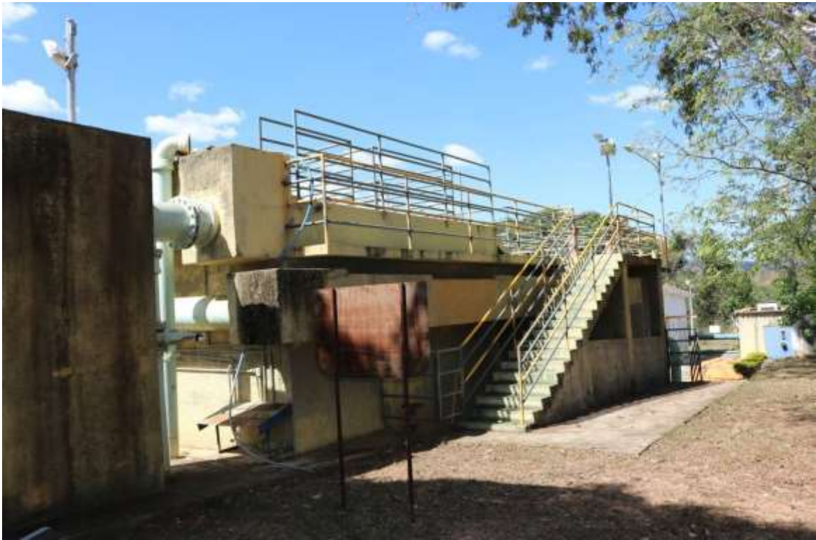
Figura 76-Estação de Tratamento de Água
