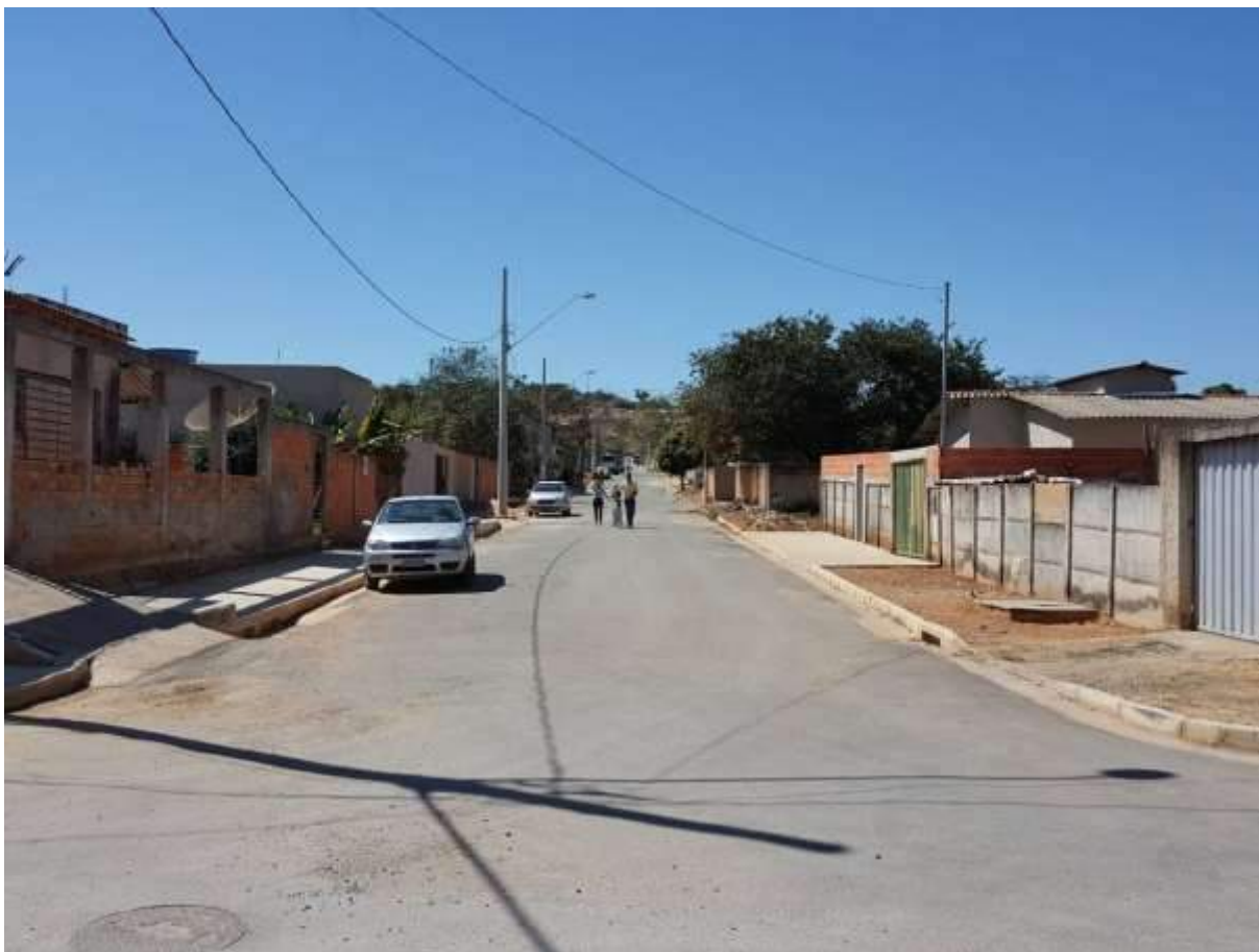
Figura 153-Reconstrução da Drenagem Do Bairro Champ's-
