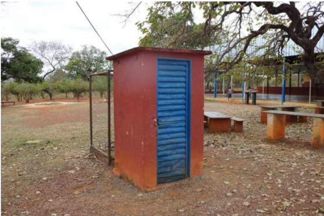
Figura 101-Poço Artesiano Picada
