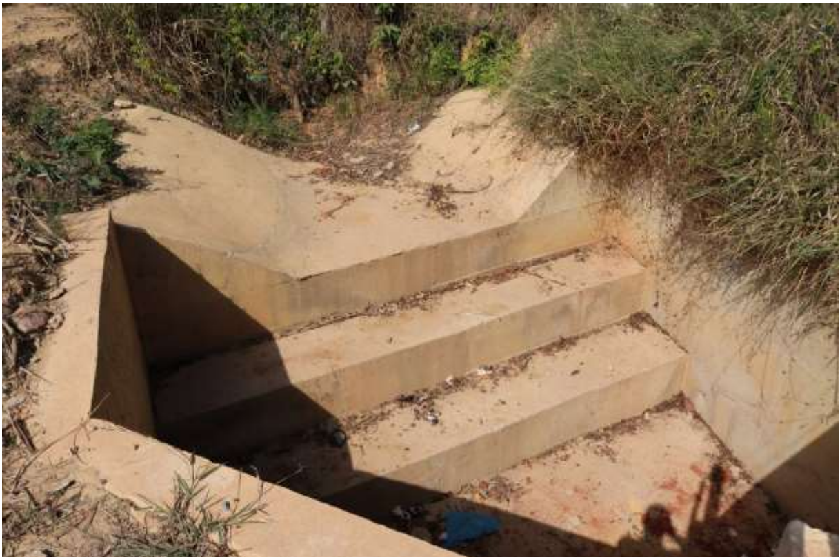
Figura 144-Reconstrução da Drenagem Do Bairro Champ's
