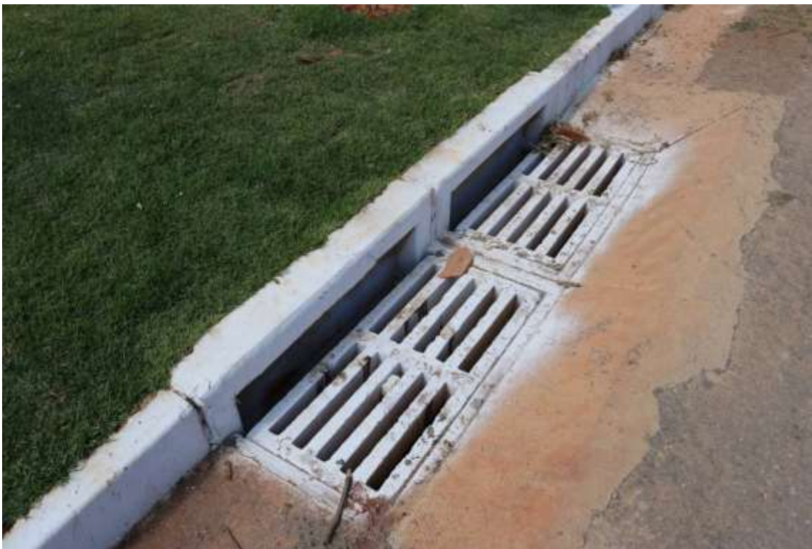
Figura 146-Reconstrução da Drenagem Do Bairro Champ's
