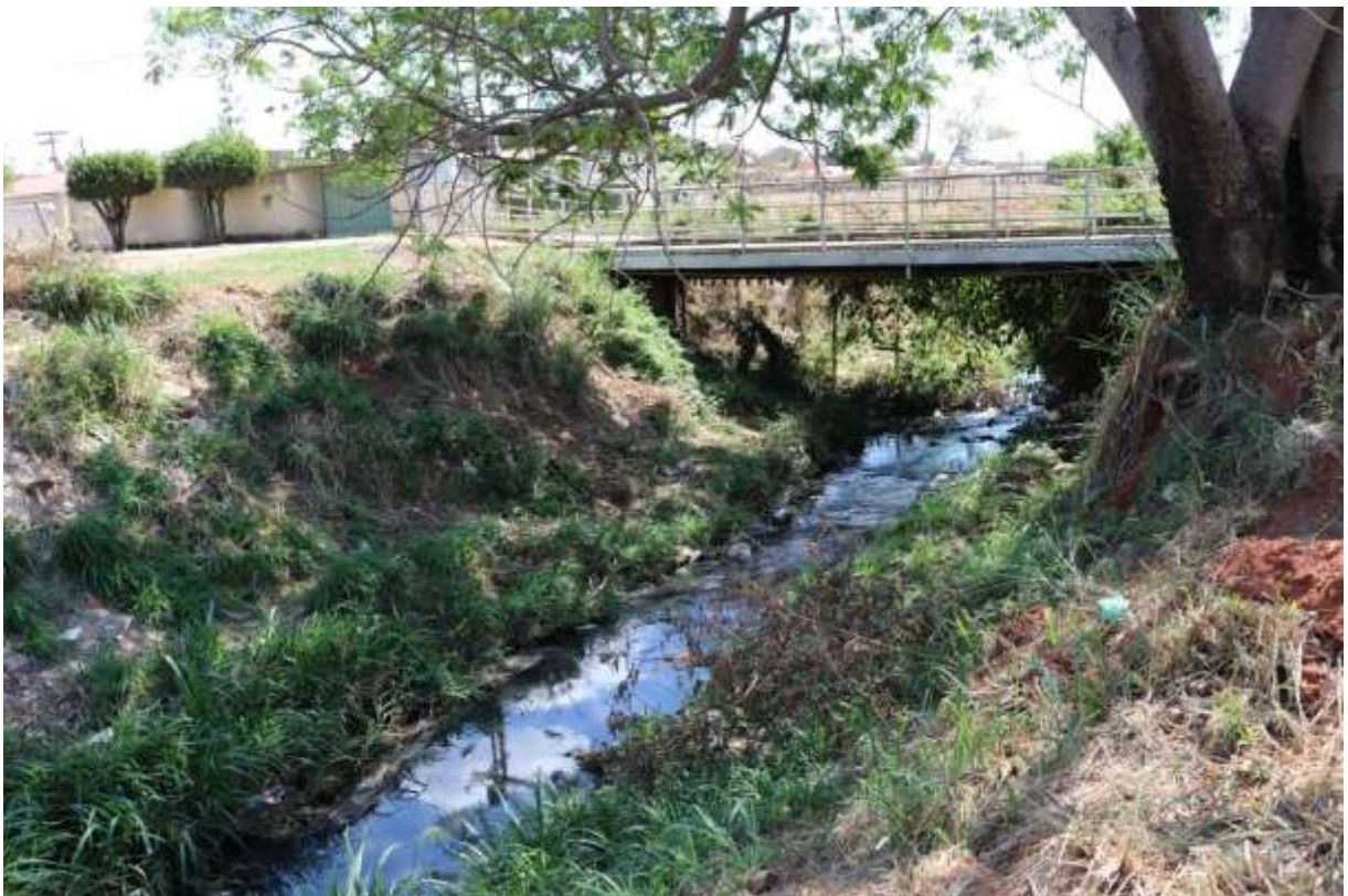
Figura 192-Ponto de Lançamento de Esgoto Córrego do Beco
