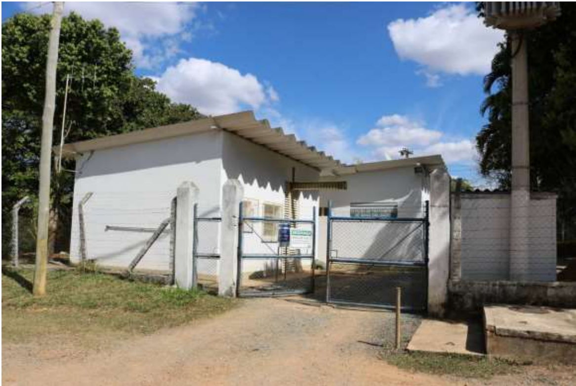
Figura 74-Estação de Tratamento de Água
