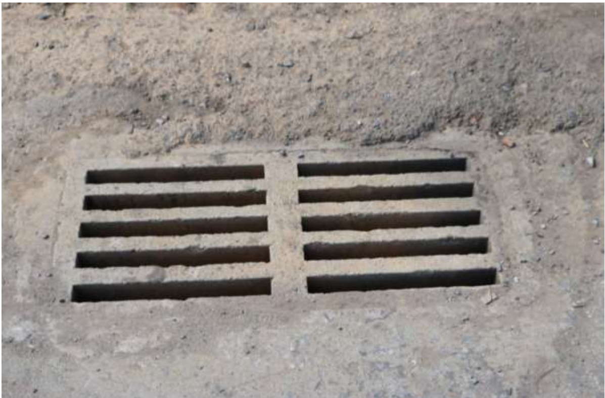
Figura 148-Reconstrução da Drenagem Do Bairro Champ's
