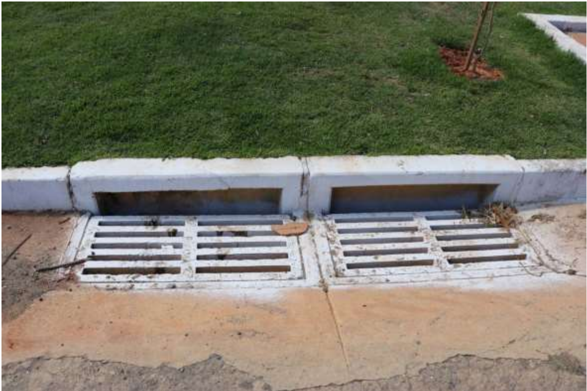
Figura 147-Reconstrução da Drenagem Do Bairro Champ's
