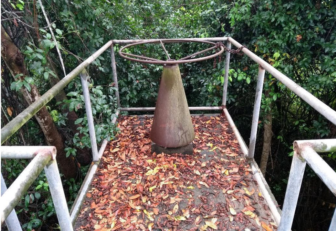
Figura 21 – Controle do sistema de comportas sob o Ribeirão Jequitibá
