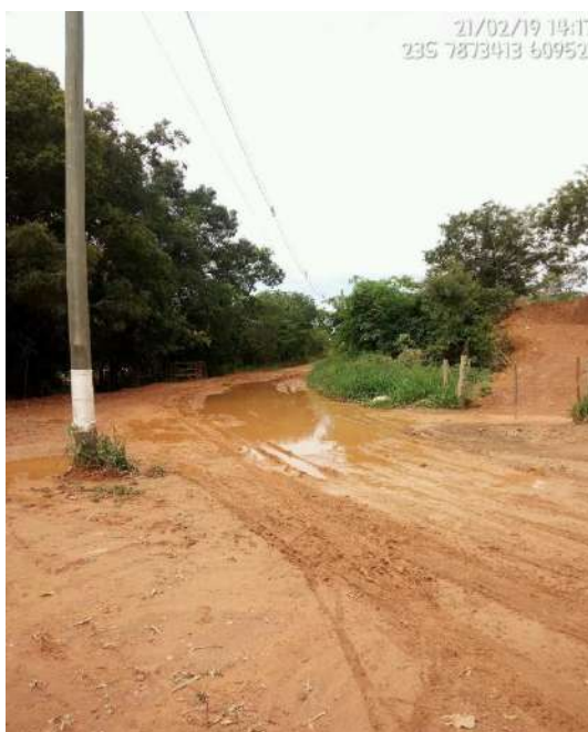
Figura 245 – Ponto de alagamento - Localidade de Quebra Perna
