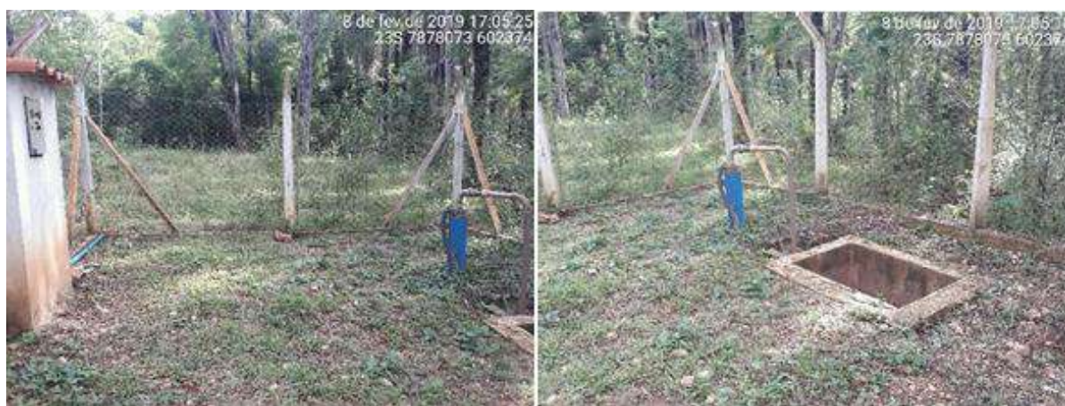
Figura 139 – Poço artesiano em Souza Fonte: Seletiva Consultoria e Projetos, 2019.
