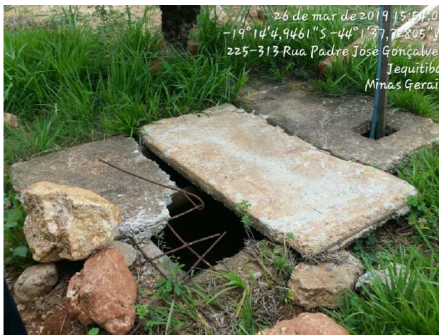
Figura 216 – Poço utilizado para o abastecimento de água da Lagoa Pedro Saturnino Fonte: Seletiva Consultoria e Projetos, 2019.
