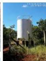
Reservatório em Coqueiros
