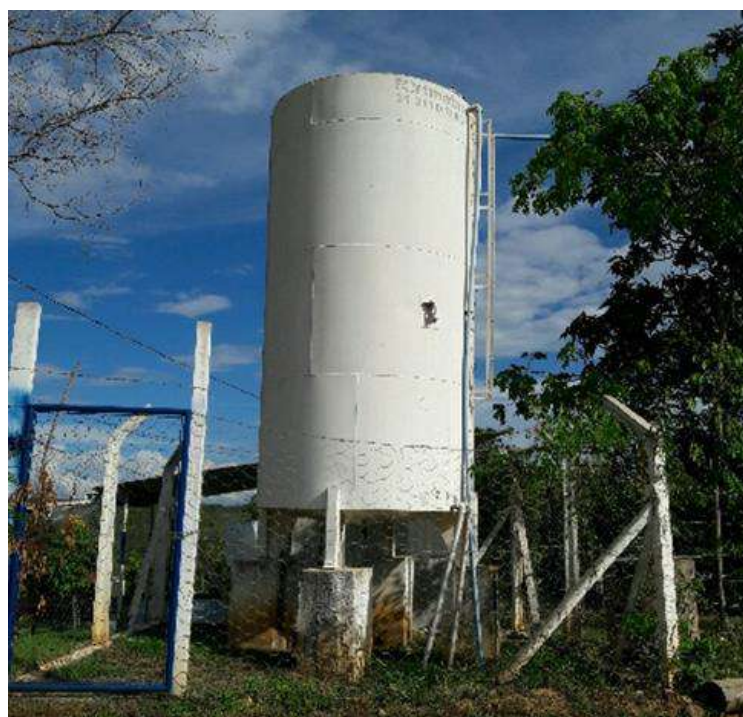
Figura 140 – Reservatório em Souza Fonte: Seletiva Consultoria e Projetos, 2019.
