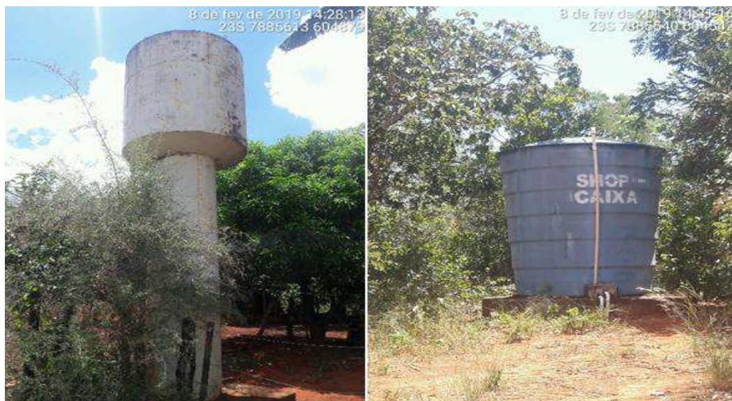
Figura 134 – Reservatórios em Bebedouro
