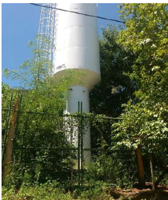
Figura 114 – Reservatório em Peróbas Fonte: Seletiva Consultoria e Projetos, 2019.
