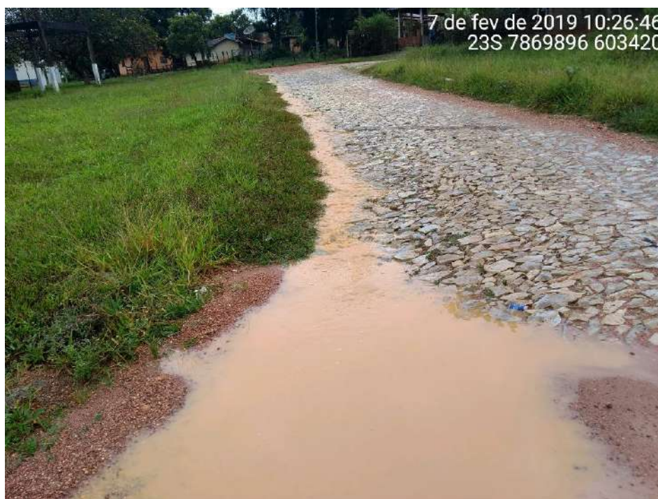
Figura 230 – Pavimento do tipo poliédrico - Comunidade de Lagoa Santo Antônio
