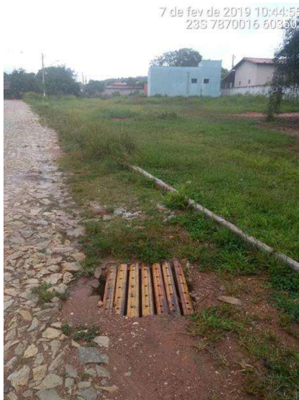
Figura 205 – Boca de lobo obstruída na comunidade de Lagoa Santo Antônio Fonte: Seletiva Consultoria e Projetos, 2019.
