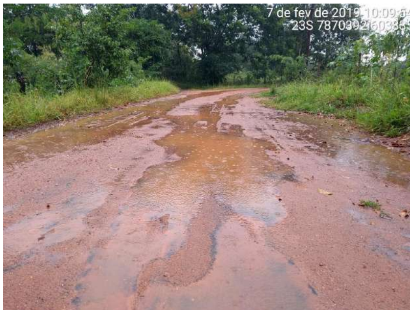
Figura 244 – Ponto de alagamento na Rua S. de Carvalho - Comunidade de Lagoa Santo Antônio
