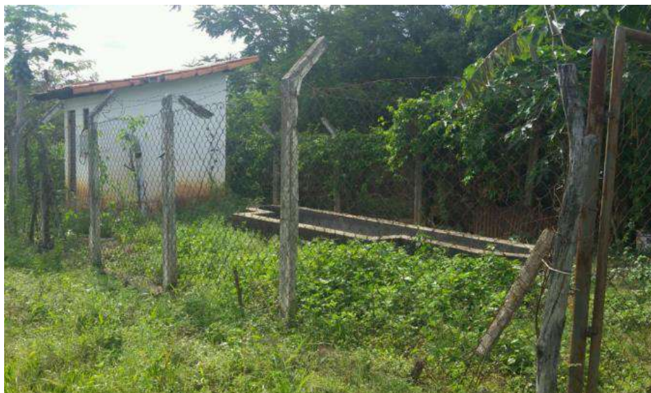
Figura 150 – Estação Elevatória de Esgoto de Jequitibá Fonte: Seletiva Consultoria e Projetos, 2019.
