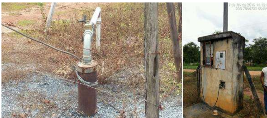
Figura 118 – Poço e padrão de energia em Dr. Campolina Fonte: Seletiva Consultoria e Projetos, 2019.
