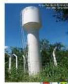
Reservatório do SAA a ser implantado em Bau
