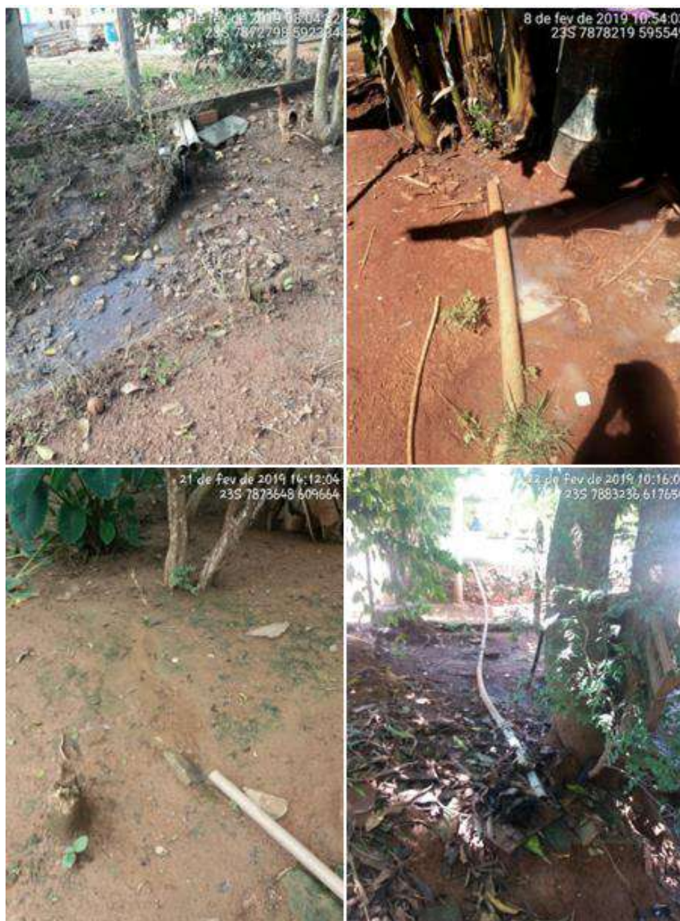
Figura 166 – Lançamento de água cinza Fonte: Seletiva Consultoria e Projetos, 2019.
