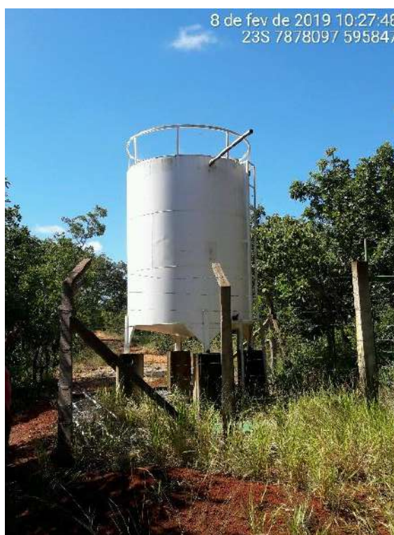
Figura 126 – Reservatório em Coqueiros
