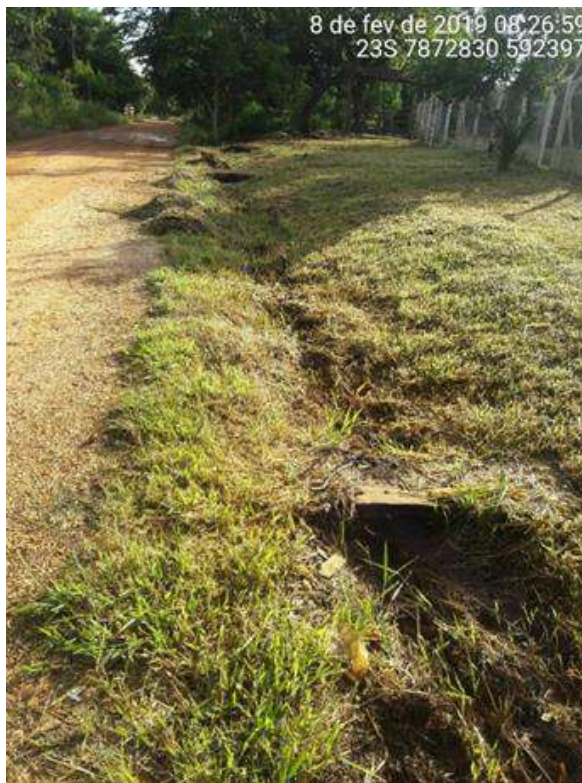
Figura 225 – Canal de escoamento superficial de água pluvial – Comunidade de Vargem Bonita
