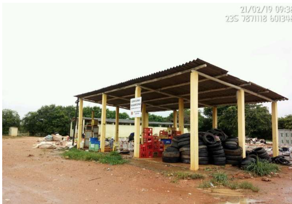
Figura 195 – Galpão para triagem dos RSD na UTC de Jequitibá e armazenamento temporário de alguns resíduos, como pneus, pilhas e lâmpadas
