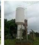
Reservatório em Campo Alegre
