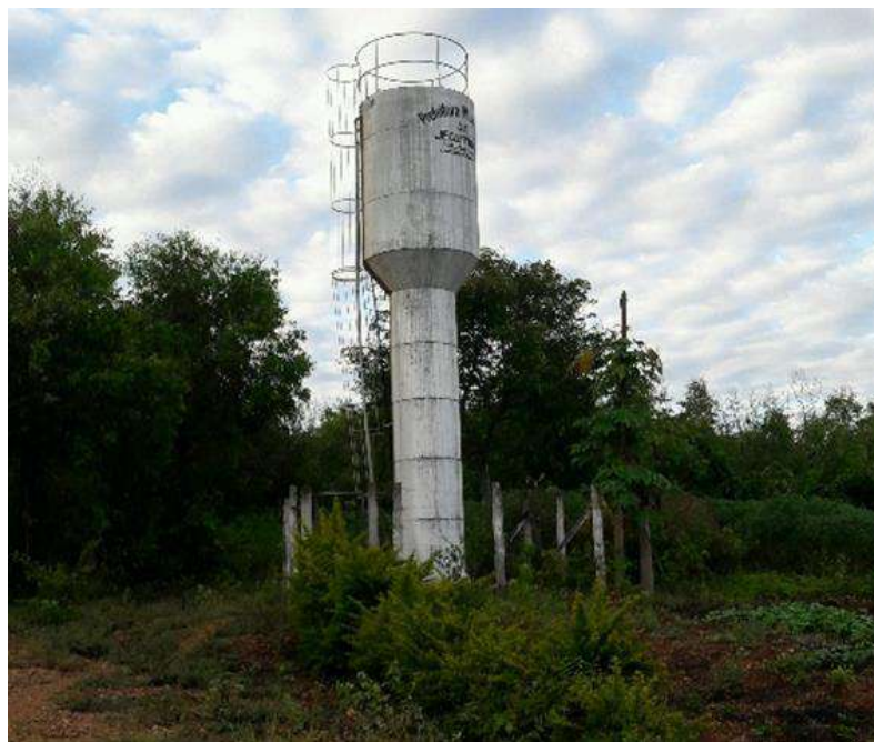
Figura 124 – Reservatório em Brejinho
