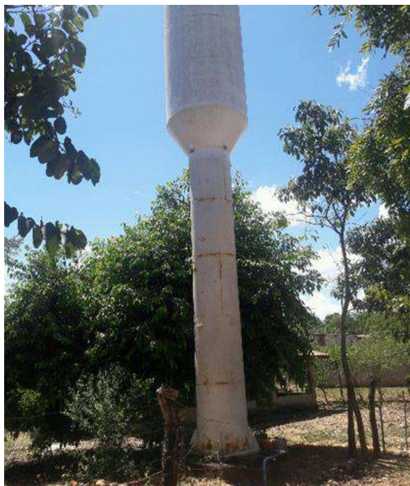
Figura 136 – Reservatório em Vera Cruz Fonte: Seletiva Consultoria e Projetos, 2019.
