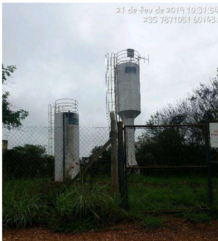
Figura 102 – Reservatórios 2 e 3 Fonte: Seletiva Consultoria e Projetos, 2019.
