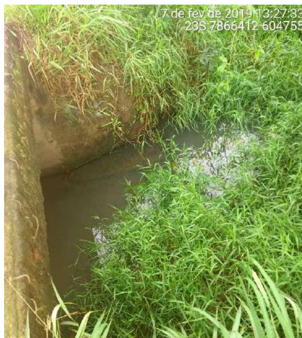
Figura 218 – Travessia das águas pluviais na comunidade de Poços
