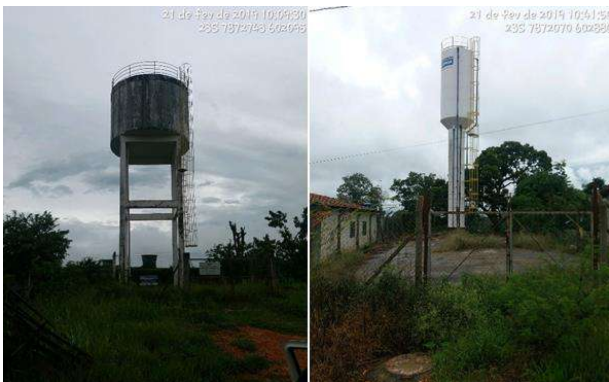
Figura 101 – Reservatórios 1 (à direita) e 4 (à esquerda)
