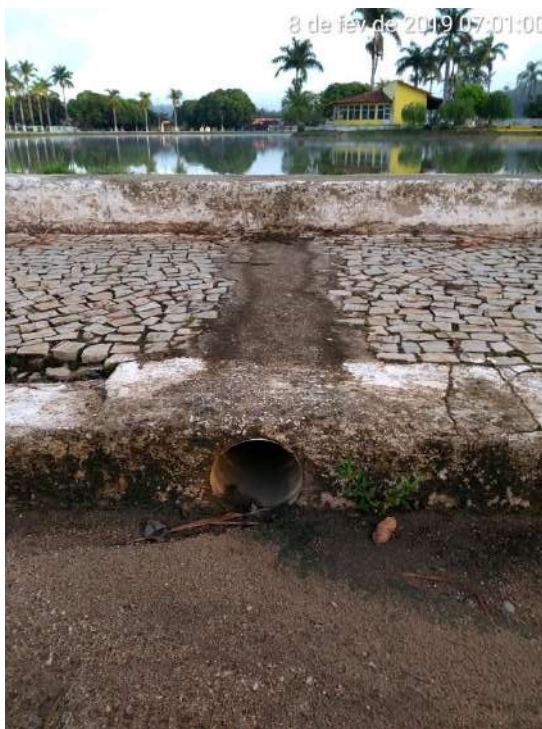
Figura 208 – Conduto de PCV realizando a drenagem da Rua Padre José Gonçalves
