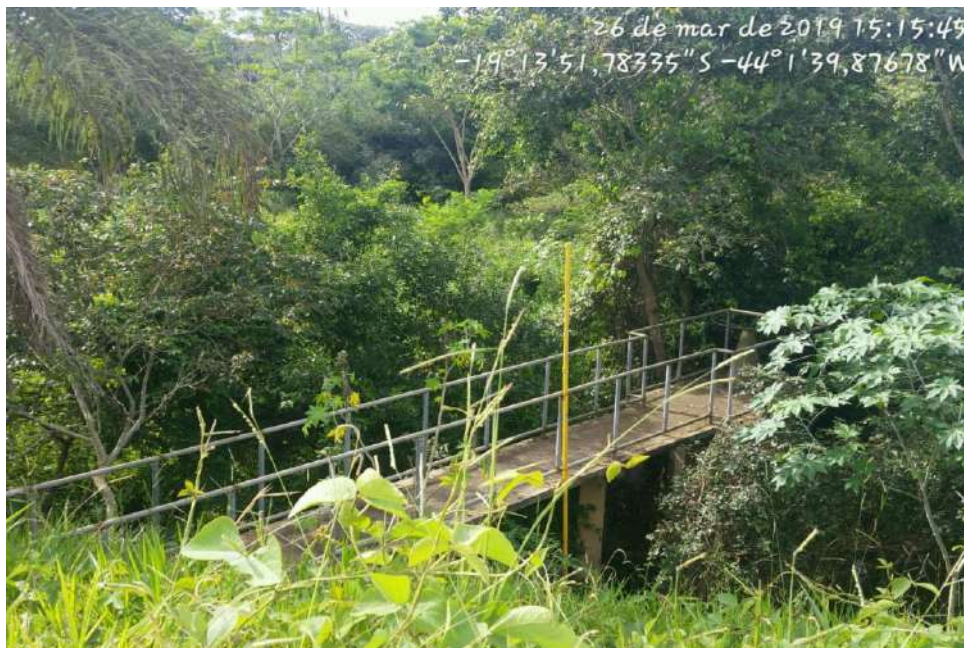
Figura 221 – Estrutura do sistema de comportas sob o Ribeirão Jequitibá Fonte: Seletiva Consultoria e Projetos, 2019.
