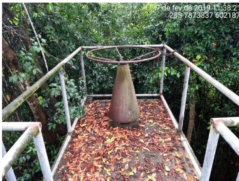
Figura 224 – Controle do sistema de comportas sob o Ribeirão Jequitibá Fonte: Seletiva Consultoria e Projetos, 2019.
