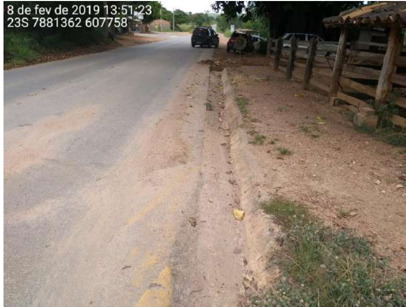
Figura 210 – Canal de escoamento superficial de água pluvial – Comunidade Onça
