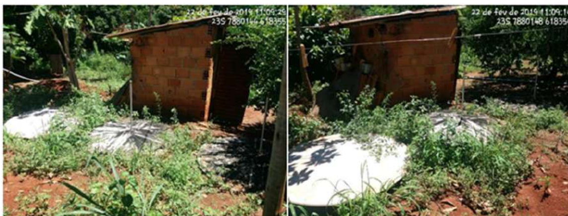
Figura 169 – Fossa séptica biodigestora em Peróbas Fonte: Seletiva Consultoria e Projetos, 2019.
