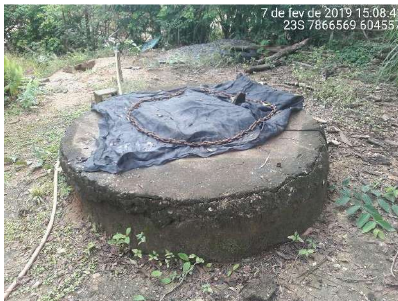
Figura 141 – Cisterna em residência na localidade de Poções Fonte: Seletiva Consultoria e Projetos, 2019.
