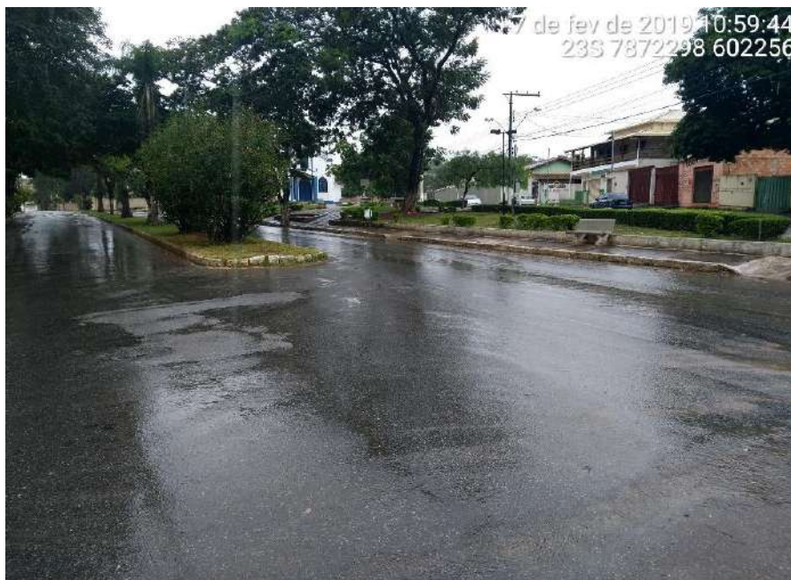
Figura 229 – Pavimentação do tipo asfáltica na Rua José Dias dos Anjos - Sede Fonte: Seletiva Consultoria e Projetos, 2019
