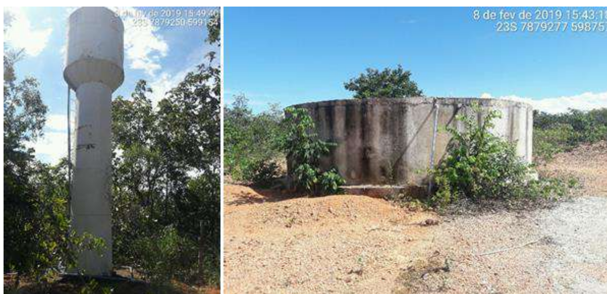
Figura 138 – Reservatório em Pindaíbas
