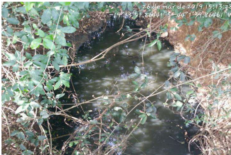
Figura 152 – Local de lançamento do esgoto da ETE
