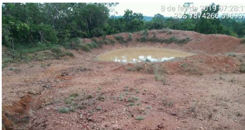
Figura 226 – Barragem - Comunidade de Brejinho Fonte: Seletiva Consultoria e Projetos, 2019.
