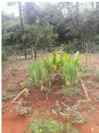
Figura 9: Tanque do Tipo Evapotranspiradora na Comunidade de Poções Fonte: Seletiva Consultoria e Projetos, 2019
