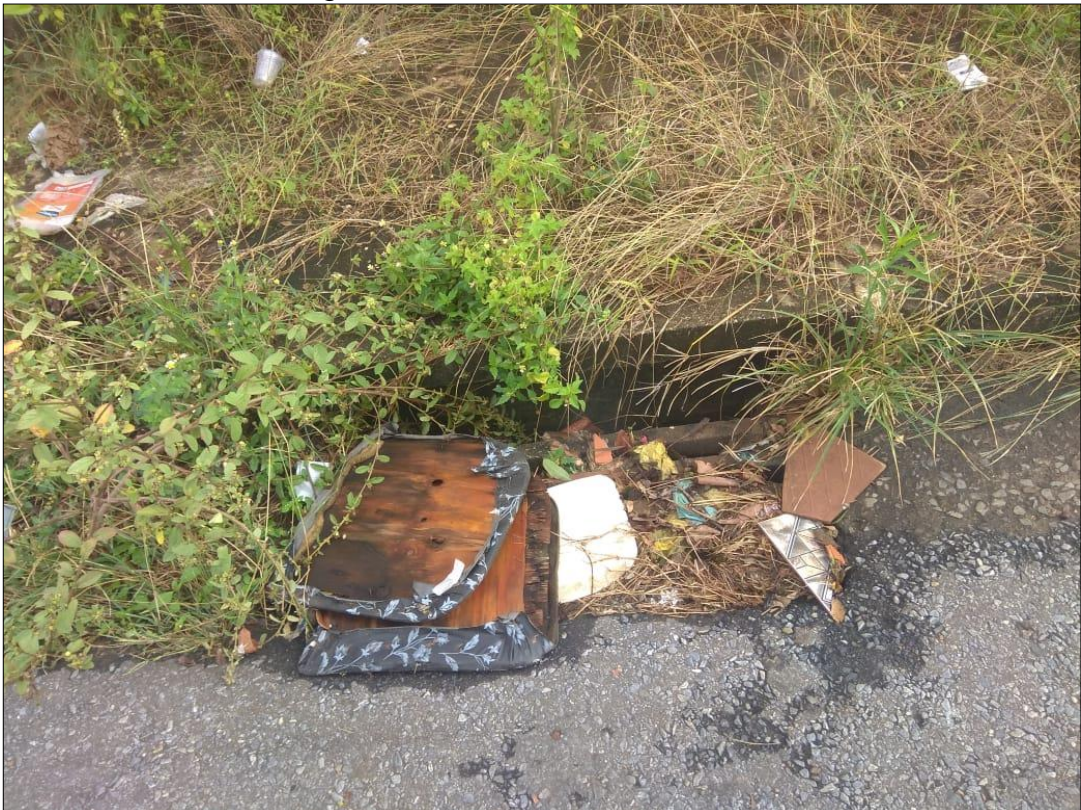
Figura 24– Boca-de-lobo obstruída
