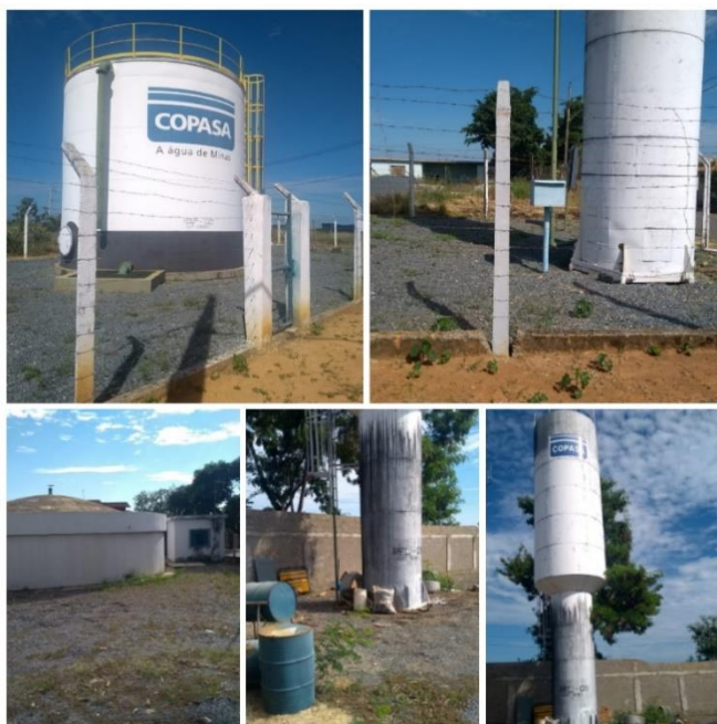
Figura 07 – Reservatórios do Sistema de Abastecimento de Água
