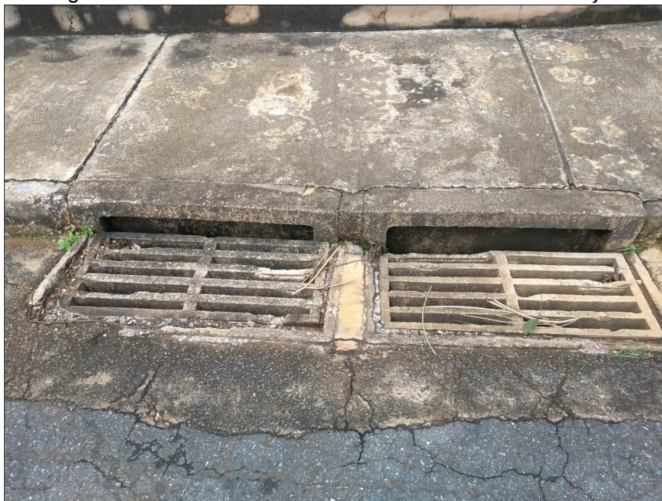
Figura 26 – Boca-de-lobo em bom estado de conservação
