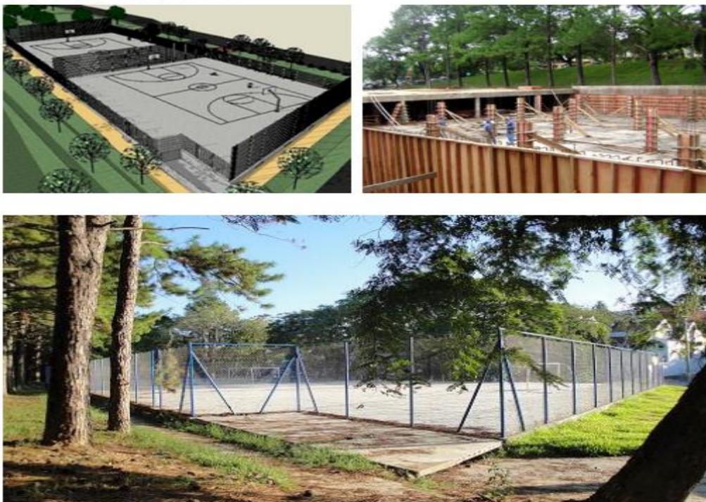
Figura 38: Reservatório de detenção fechado, construído em Porto Alegre - RS
