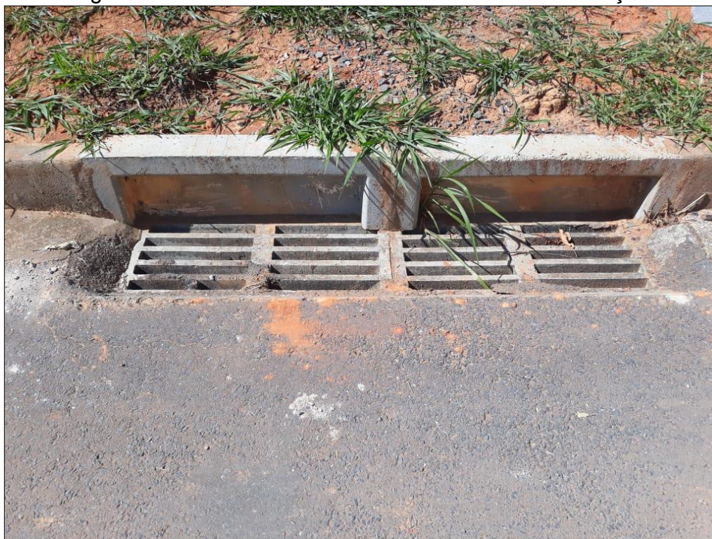
Figura 25 – Boca-de-lobo em bom estado de conservação
