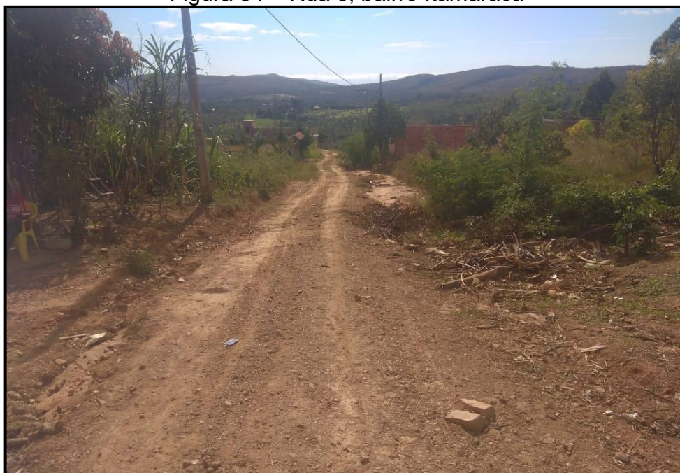
Figura 34 – Rua 6, bairro Itamaracá
