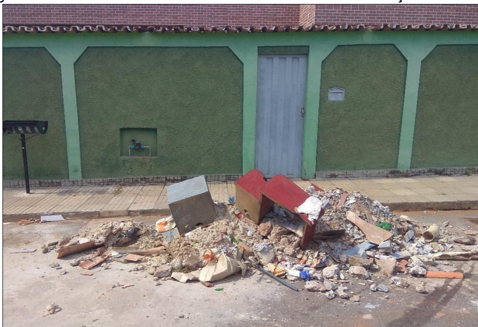
Figura 67 – Acúmulo de resíduos volumosos e de construção civil na rua
