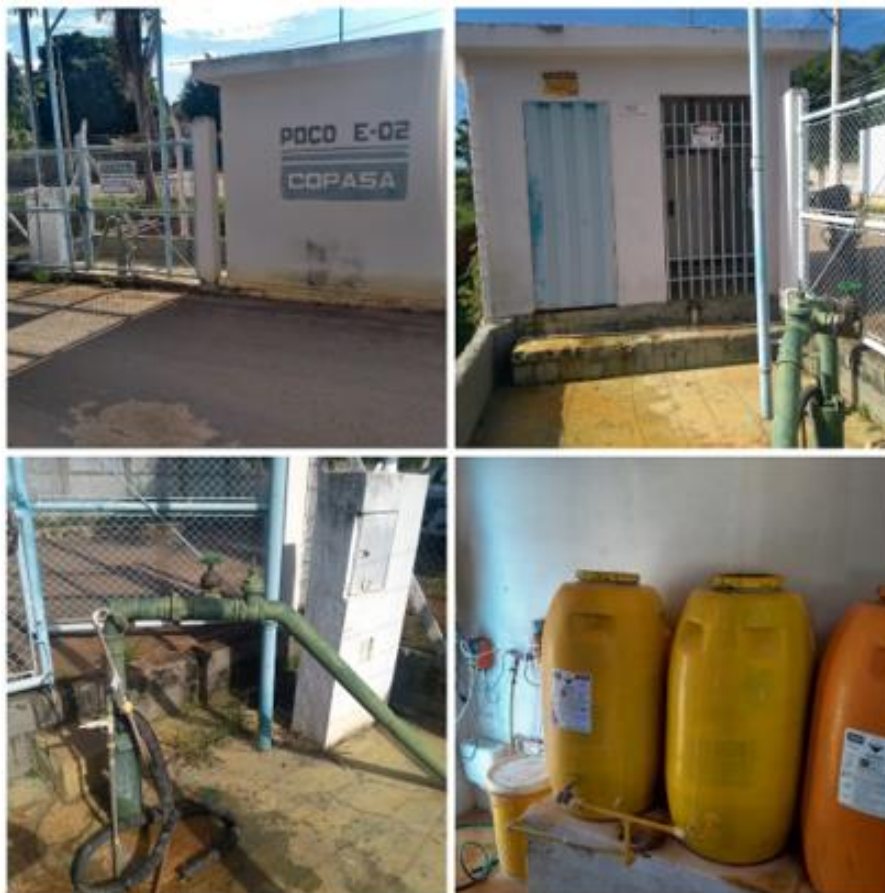
Figura 34 – Poço E-02 e respectiva casa de química
