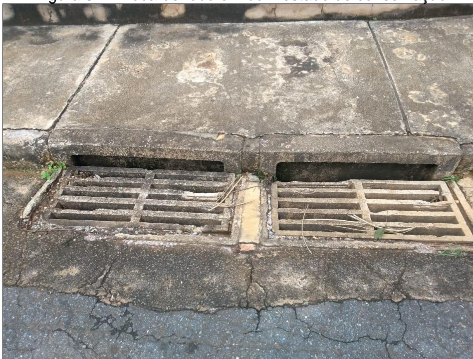
Figura 84 – Boca-de-lobo em bom estado de conservação
