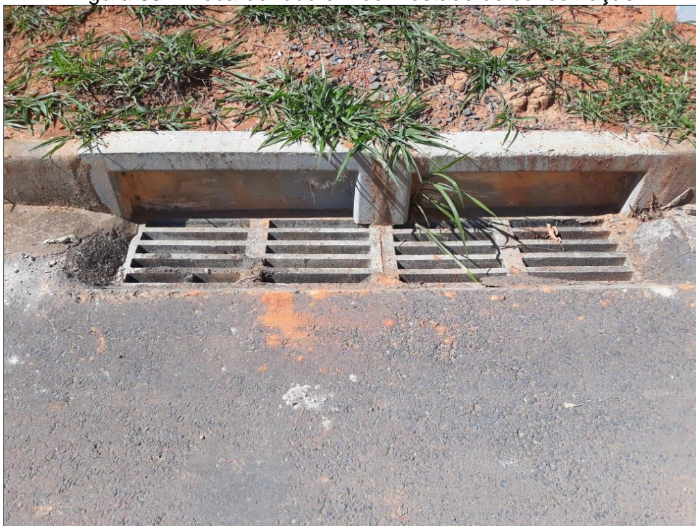
Figura 83 – Boca-de-lobo em bom estado de conservação
