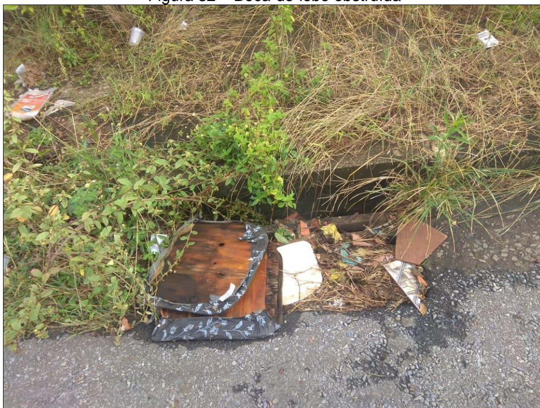
Figura 82 – Boca-de-lobo obstruída
