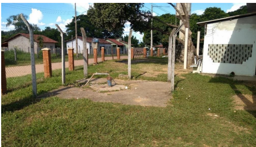
Figura 9.47 – Poço Tubular 8 - Santa Maria
