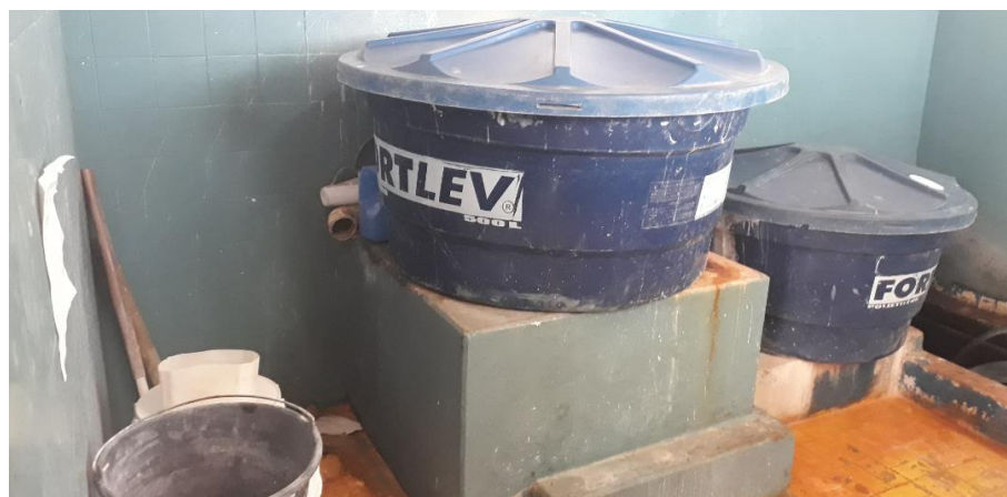
Figura 9.27 – Tanque de cloro – ETA
