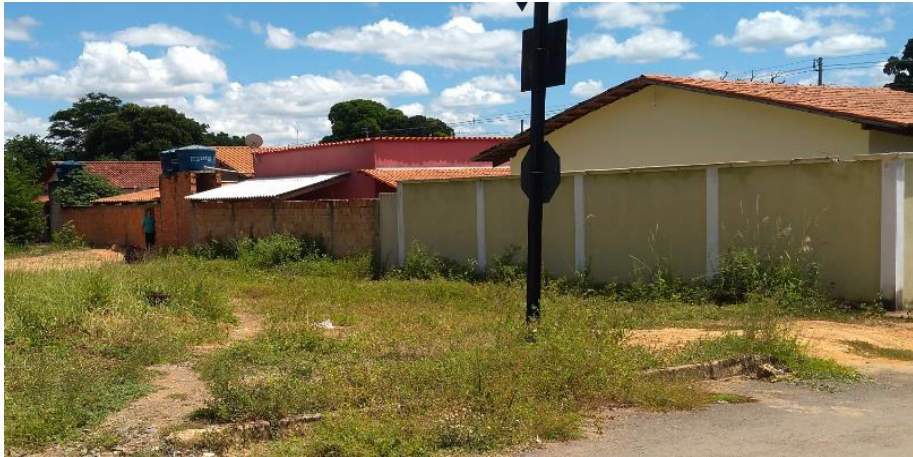
Figura 12.12 – Local de alagamento - Ponto 10 (Sede)
