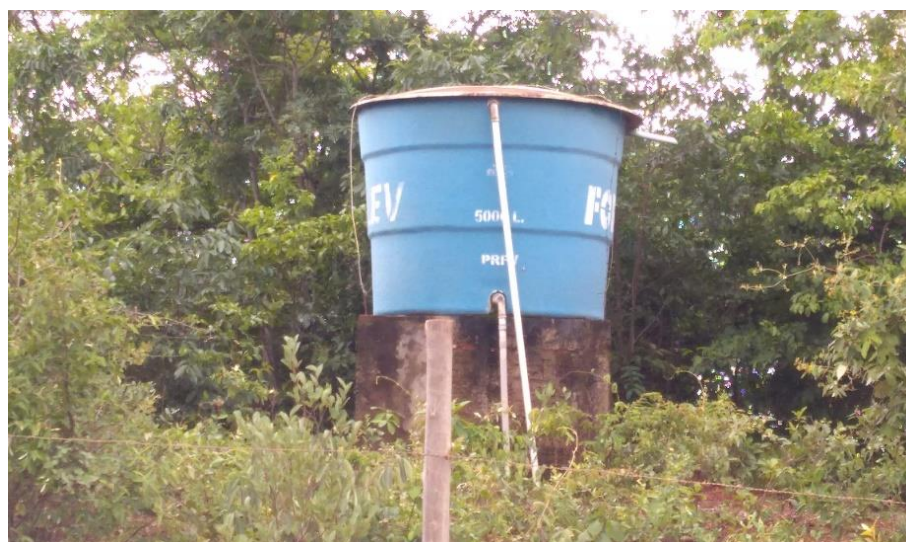
Figura 9.72 – Reservatório 9 - Santa Maria
