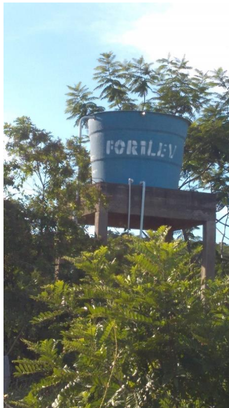
Figura 9.68 – Reservatório 5 - Santa Maria
