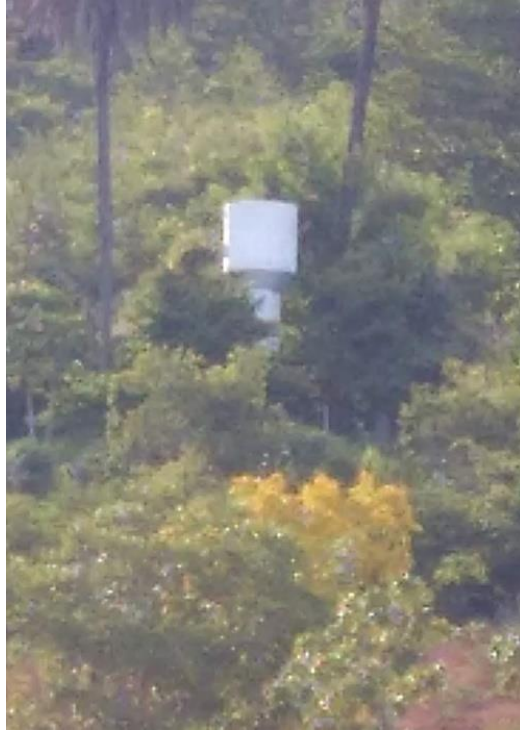
Figura 9.67 – Reservatório 4 - Santa Maria
