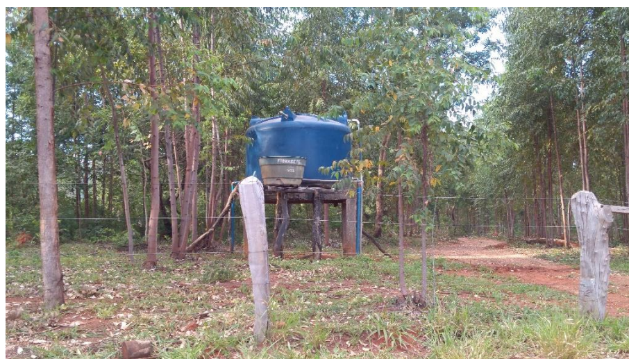
Figura 9.66 – Reservatório 3 - Santa Maria
