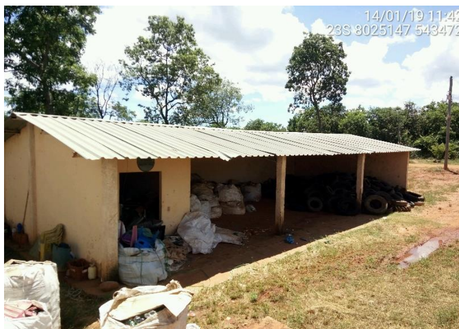
Figura 11.23 – Abrigo para resíduos da logística reversa (produtos eletroeletrônicos e pneus inservíveis) na área da UTC do município de Lassance
