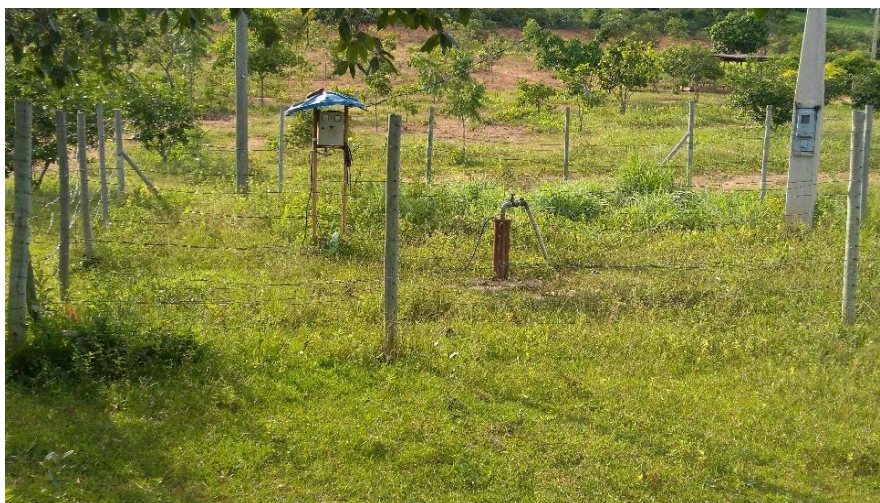
Figura 9.44 – Poço Tubular 5 - Santa Maria
