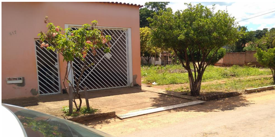
Figura 12.13 – Local de Alagamento - Ponto 11 (Sede)
