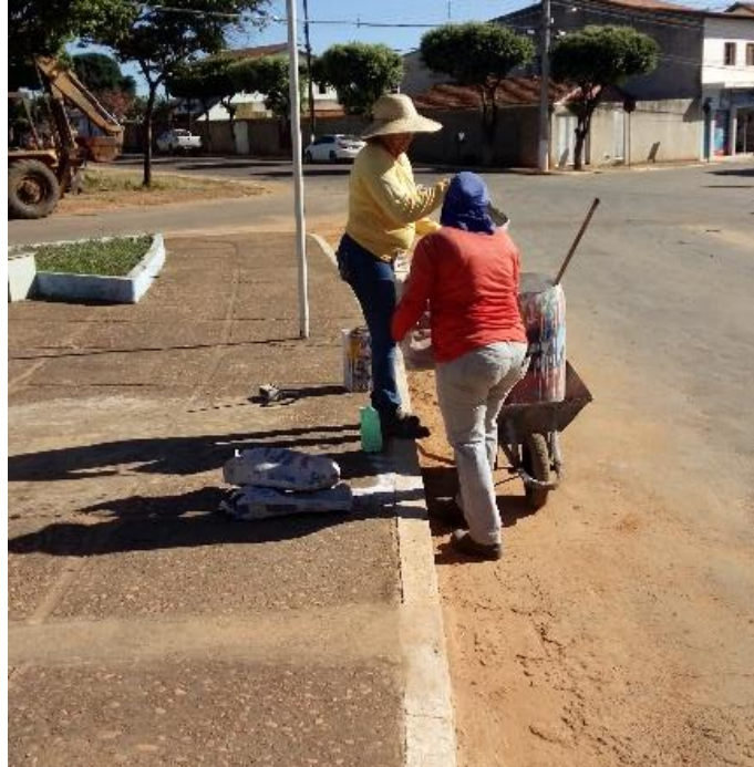
Figura 11.10 – Funcionários dos serviços de pintura de meio fio
