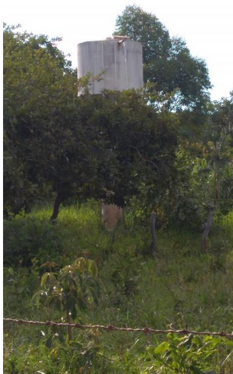
Figura 9.65 – Reservatório 2 - Santa Maria
