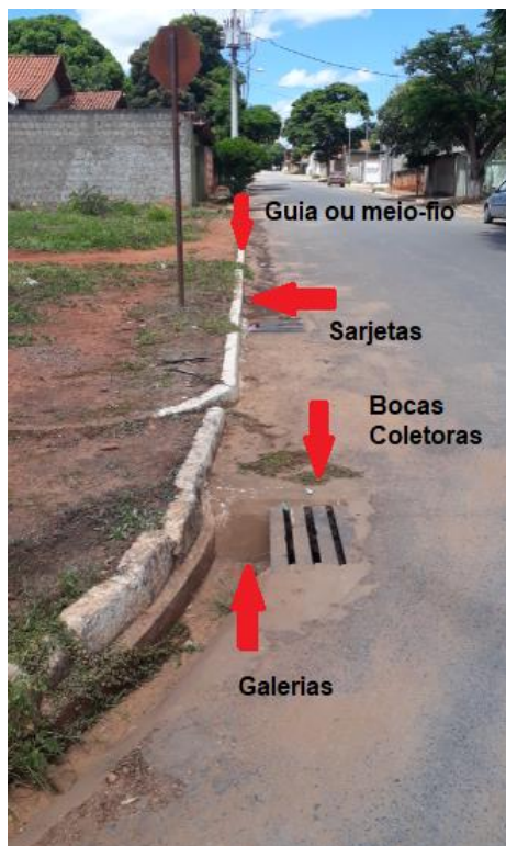
Figura 12.5 – Estruturas de microdrenagem existentes - Sede
