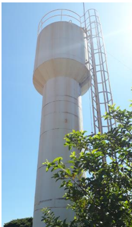
Figura 9.31 – Reservatório elevado setor 1 - Brejo
