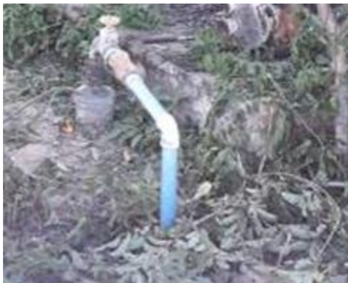
Figura 9.23 – Proteção do Poço 04 - Brejo
