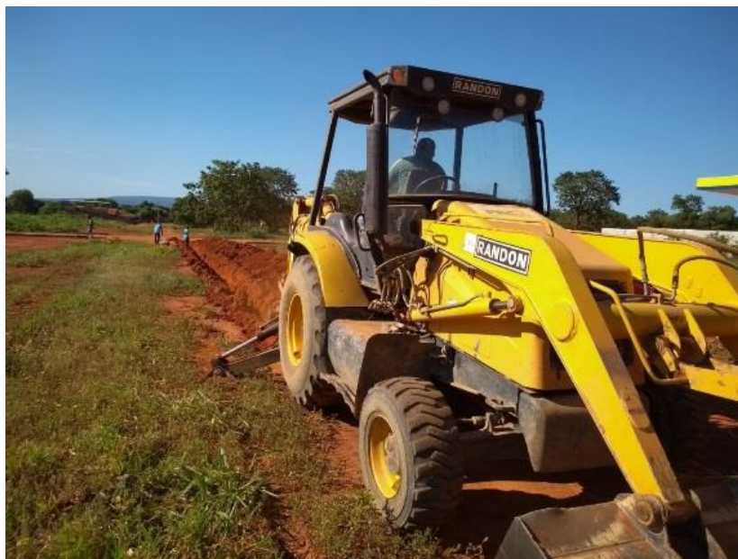
Figura 11.16 – Retroescavadeira para recolhimento de RCC na sede do município de Lassance
