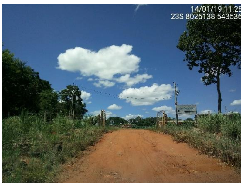
Figura 11.31 – Entrada da UTC da sede municipal de Lassance
