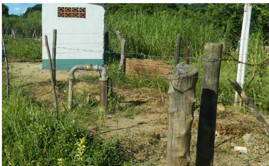
Figura 9.13 – Proteção do Poço Sr. Osmar
