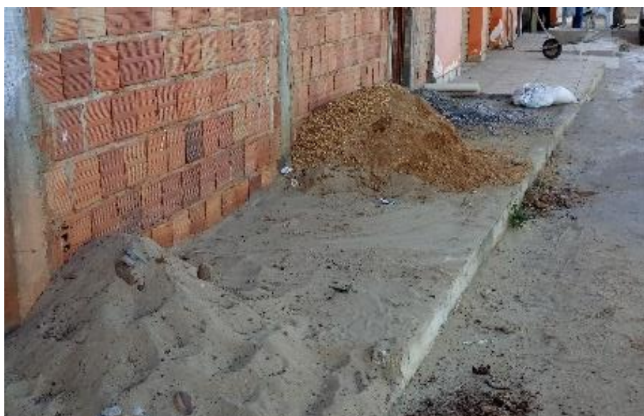
Figura 11.13 – RCC na sede do município de Lassance
