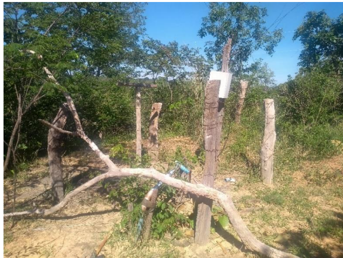
Figura 9.62 – Poço tubular 2 - Onça
