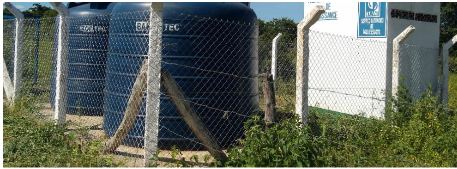
Figura 9.21 – Proteção do Poço 03 - Brejo
