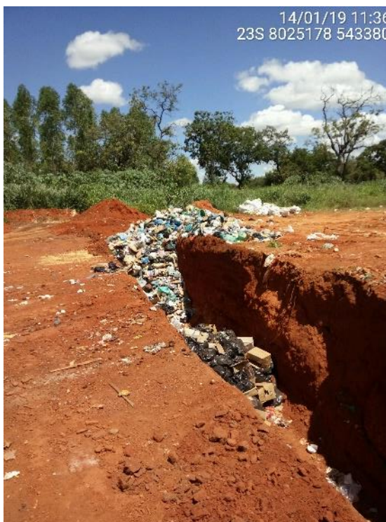
Figura 11.36 – Disposição final na UTC da sede municipal de Lassance
