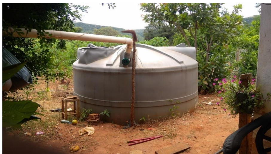
Figura 9.35 – Cisternas para captação de água pluvial
