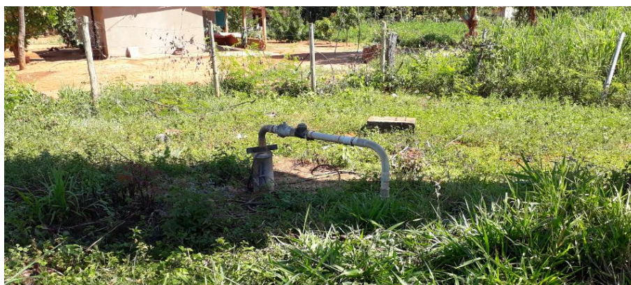
Figura 9.19 – Proteção do Poço 02 - Brejo
