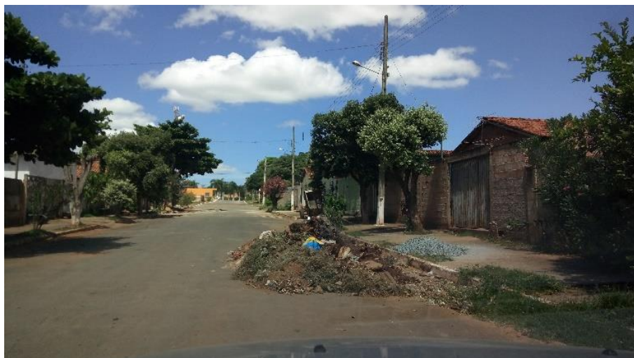
Figura 11.14 – RCC e outros tipos de resíduos na sede do município de Lassance
