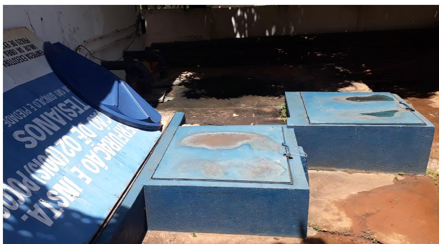
Figura 9.28 – Reservatório enterrado - Sede
