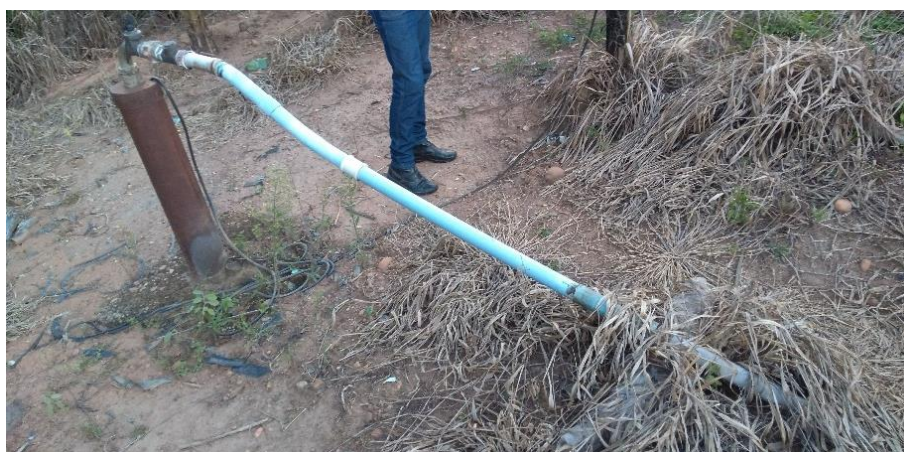
Figura 9.57 – Poço tubular 2 - Morada Nova
