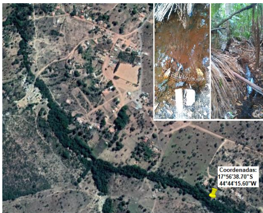
Figura 9.37 – Captação superficial - Morada Nova
