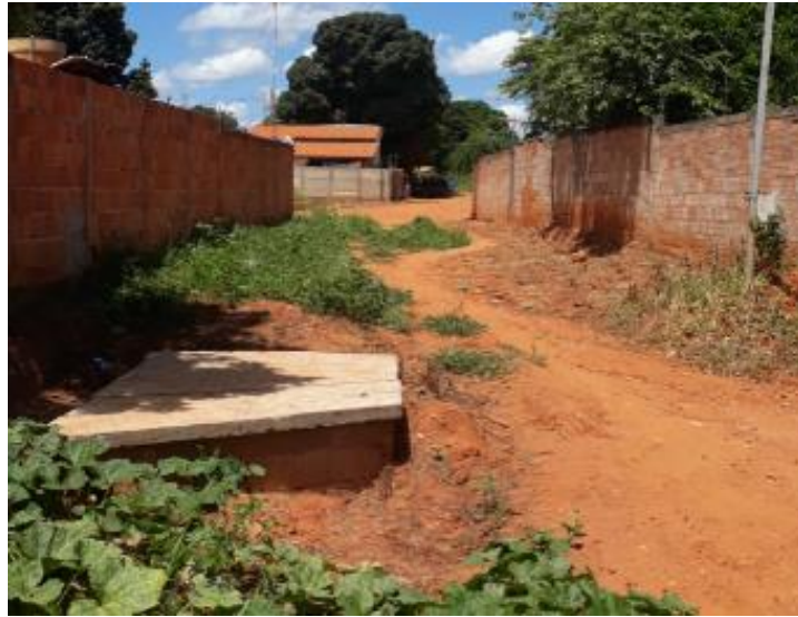
Figura 12.6 – Caixa de passagem instalada na sede de Lassance
