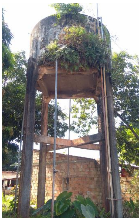
Figura 9.32 – Reservatório elevado setor 2 - Brejo
