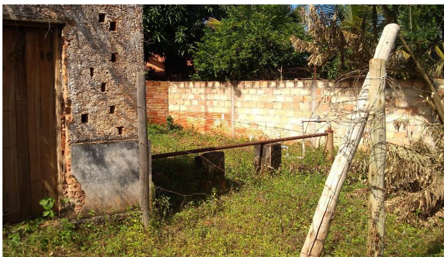
Figura 9.17 – Proteção do Poço 01 – Brejo
