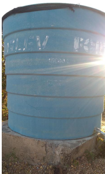
Figura 9.71 – Reservatório 8 - Santa Maria
