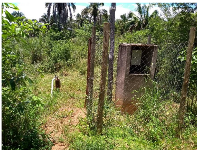
Figura 9.58 – Poço tubular - Cotovelo
