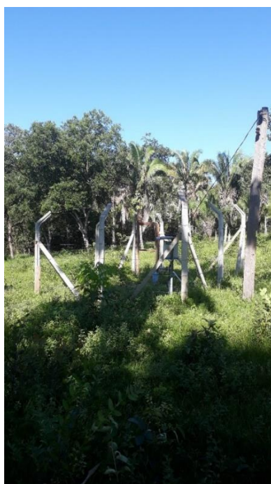
Figura 9.60 – Poço tubular - Resfriado
