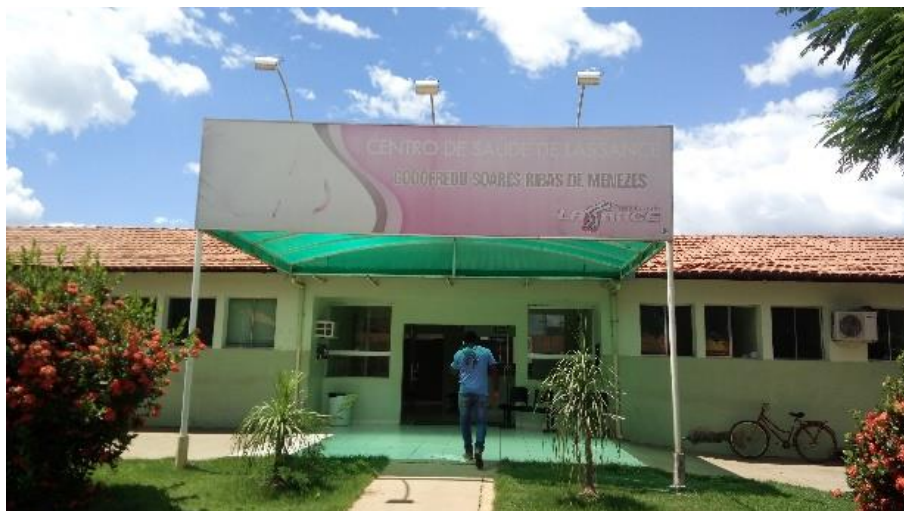
Figura 11.19 – Centro de Saúde de Lassance
