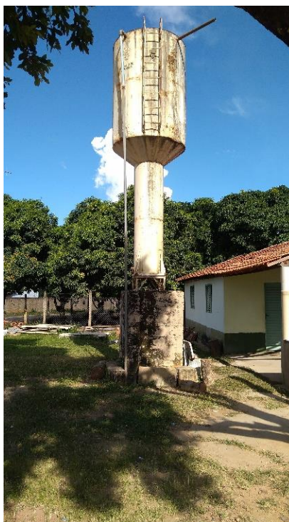
Figura 9.64 – Reservatório 1 - Santa Maria
