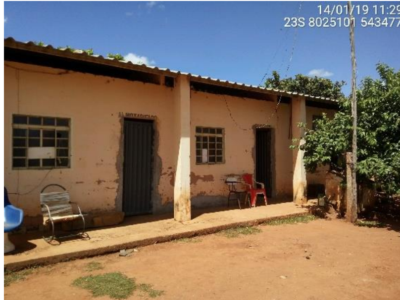
Figura 11.32 – Estrutura da UTC da sede municipal de Lassance
