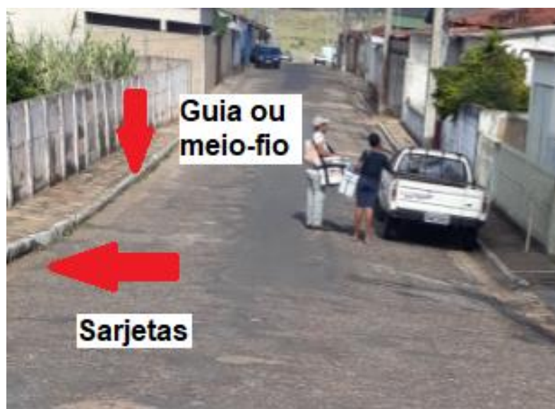
Figura 12.7 – Estruturas de microdrenagem - Sede
