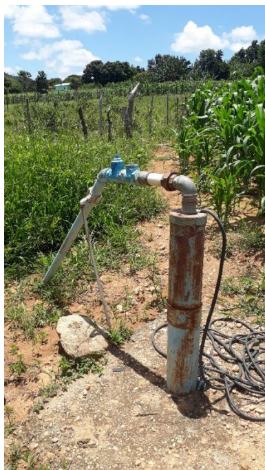
Figura 9.33 – Poço Tombado - vazão 2.3 L/s
