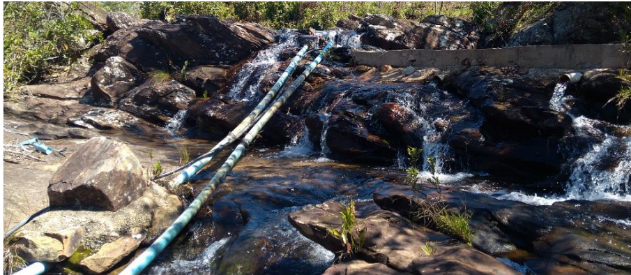
Figura 9.28 – Captação Superficial Tombadouro – Foto 1
