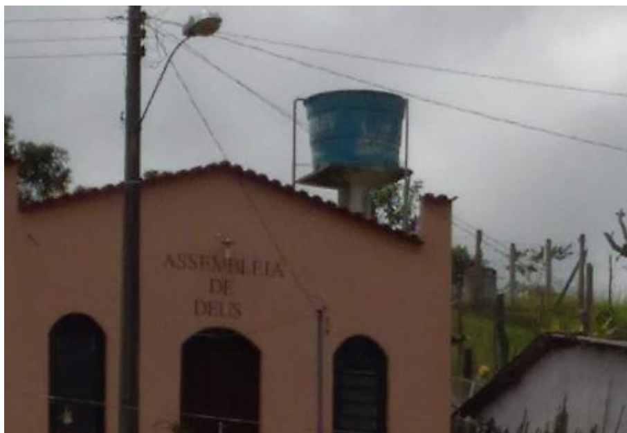
Figura 9.43 – Reservatório elevado - Cachimbos
