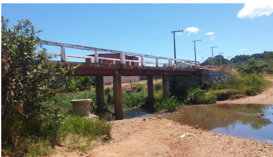
Figura 12.2 – Ponte de acesso ao bairro Tropinha
