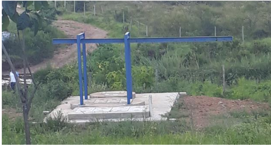
Figura 10.4 – Estação Elevatória de Esgoto – 01
