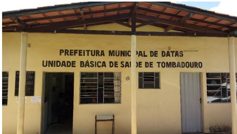
Figura 11.18 – UBS-ESF Renascer em Tombadouro
