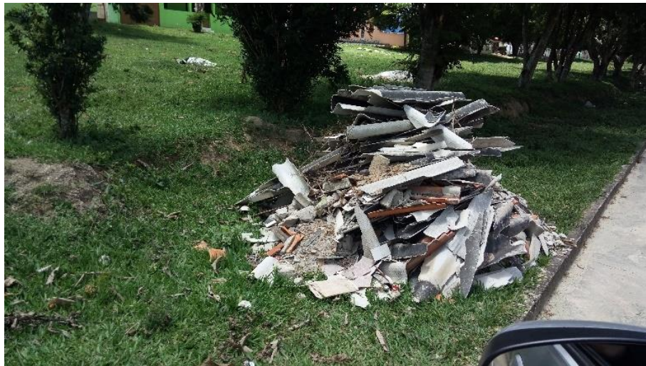
Figura 11.16 – RCC descartados no distrito de Tombadouro
