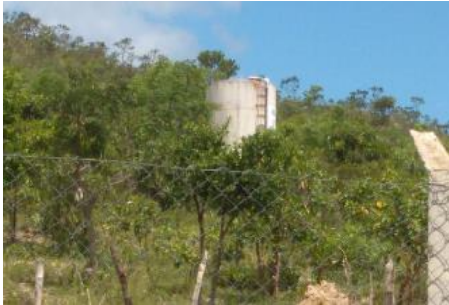
Figura 9.42 – Reservatório apoiado 02 -Tombadouro
