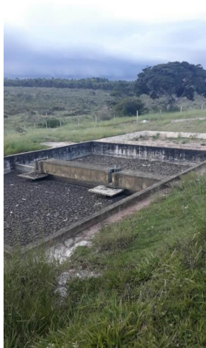
Figura 10.11 – Leito de Secagem
