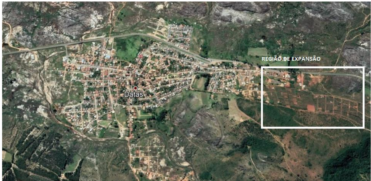
Figura 10.3 – Área sem coleta de esgoto – região em expansão
