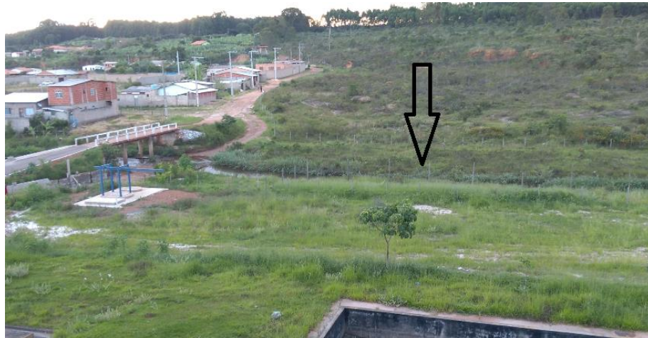
Figura 10.13 – Ponto de Lançamento de Esgoto
