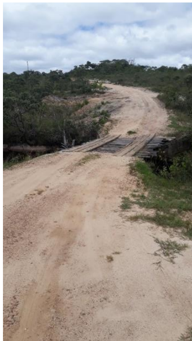
Figura 12.19 – Ponte na Fazenda de Santa Cruz
