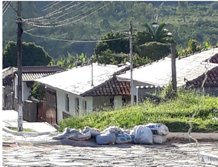
Figura 12.8 – Divisor de enxurradas na rua Florêncio Marques
