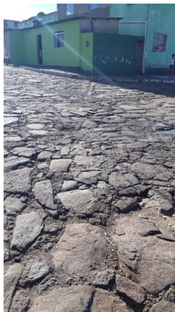
Figura 12.10 – Via pavimentada (pedras irregulares) – Sede
