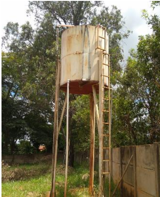
Figura 9.48 – Reservatório elevado - Palmital
