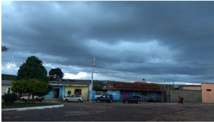
Figura 12.17 – Local onde ocorre enxurrada (ponto 3)
