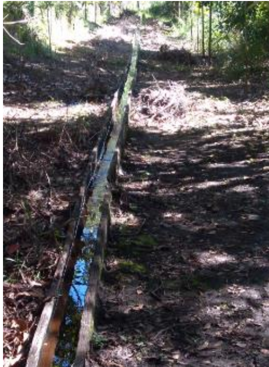
Figura 9.6 – Canal de madeira – adução de água bruta
