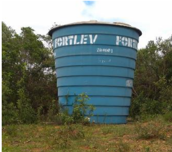
Figura 9.46 – Reservatório apoiado - Poço Fundo
