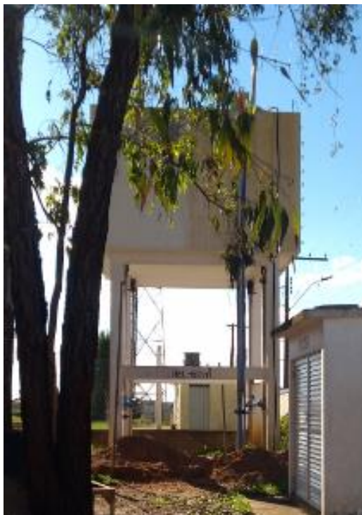
Figura 9.17 – Reservatório elevado – 50 m 3
