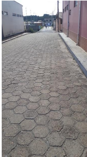
Figura 12.11 – Via pavimentada (Poliedros) - Sede
