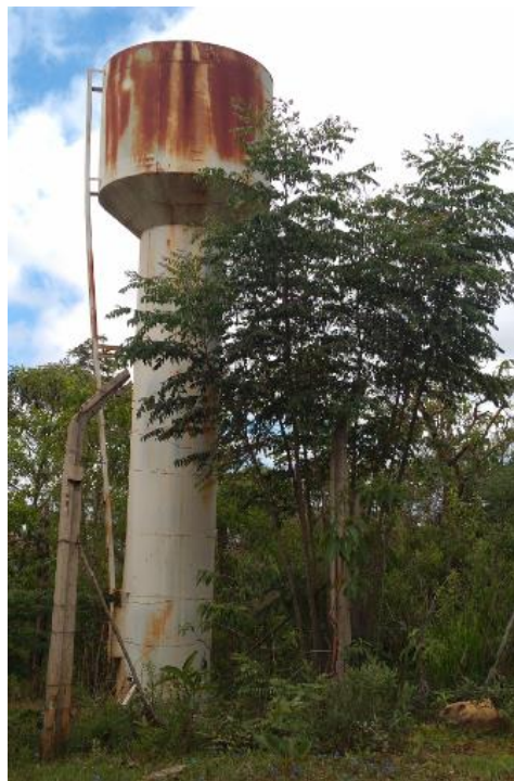
Figura 9.45 – Reservatório elevado - Poço Fundo
