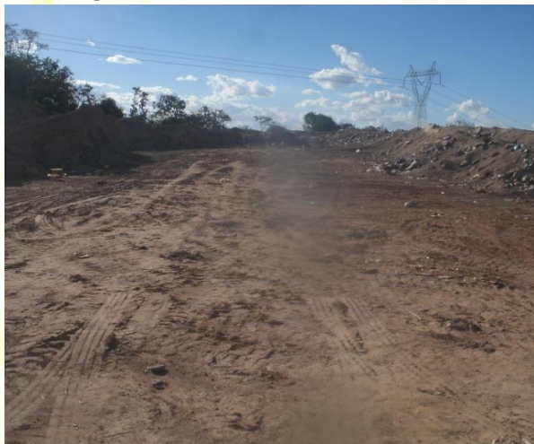
Figura 33 - Valas encerradas com cobertura correta de terra
