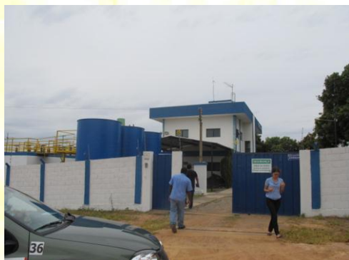
Figura 25 - Estação de Tratamento de Água – agosto de 2013
