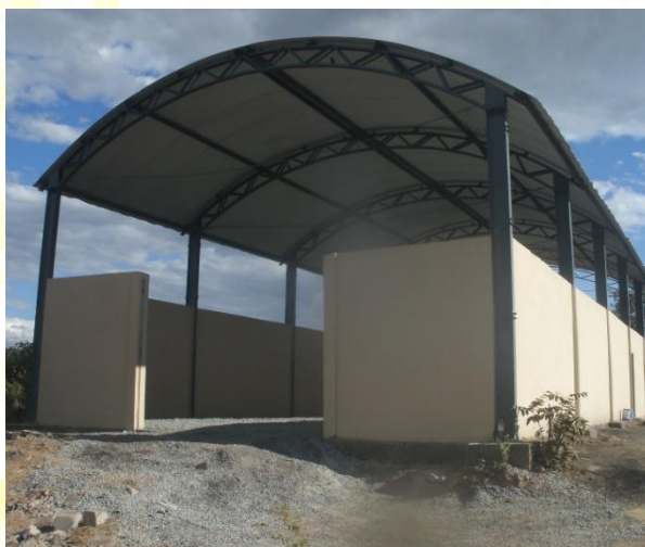
Figura 35 - Galpão para triagem aguardando o início das atividades de coleta seletiva
