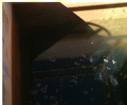
Figura 30 - Estação de Tratamento de Esgoto – agosto de 2013
