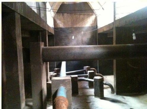
Figura 27 - Estação de Tratamento de Esgoto – agosto de 2013
