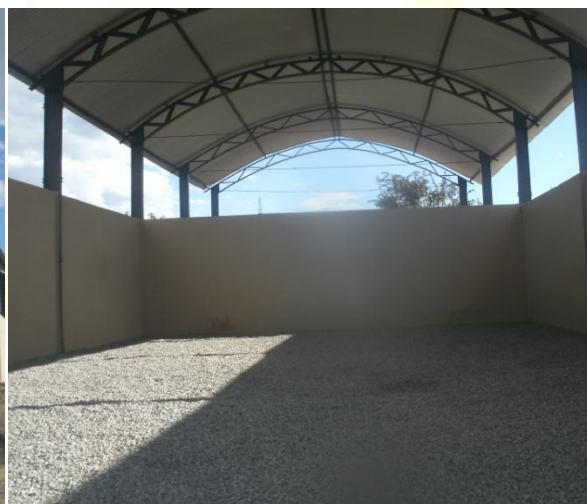
Figura 36 - Galpão para triagem aguardando o início das atividades de coleta seletiva
