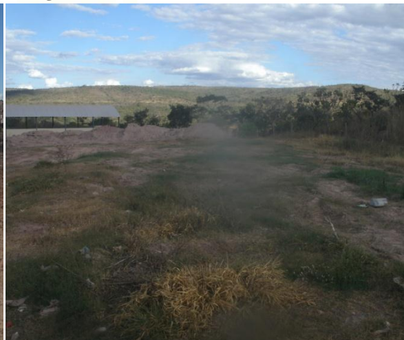
Figura 34 - Valas encerradas com cobertura correta de terra
