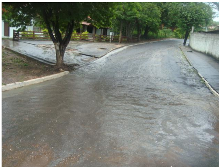
Figura 4.8 – Deficiência no sistema de microdrenagem – Sede do município
