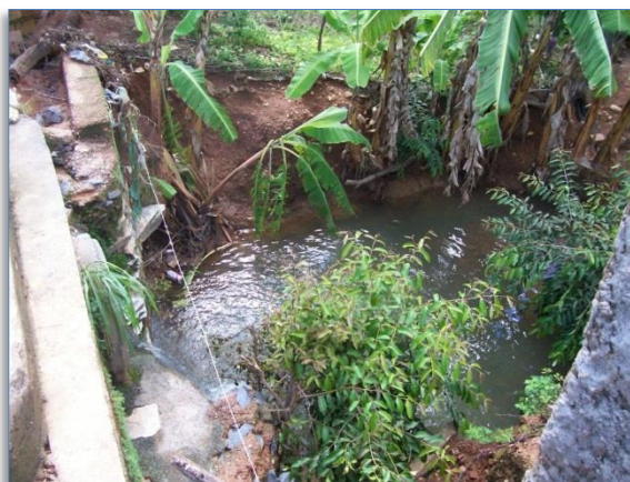
Figura 8: Lançamento de Esgoto em Curso D' Água em Corinto
