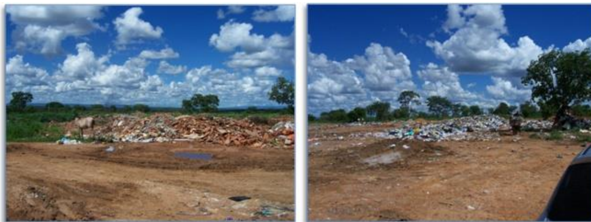
Figura 9: Aterro Sanitário “Lixão” de Corinto
