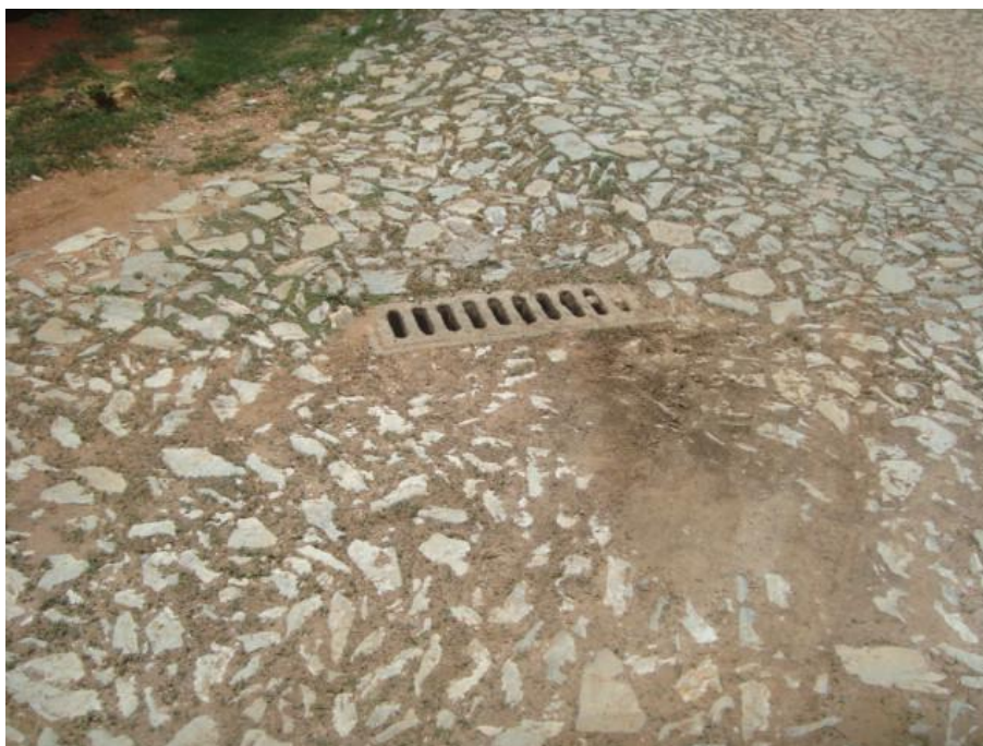
Figura 4.7 – Estrutura de drenagem – Grelha – Sede do Município
