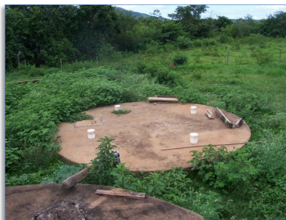
Figura 9: Estação de tratamento de esgoto
