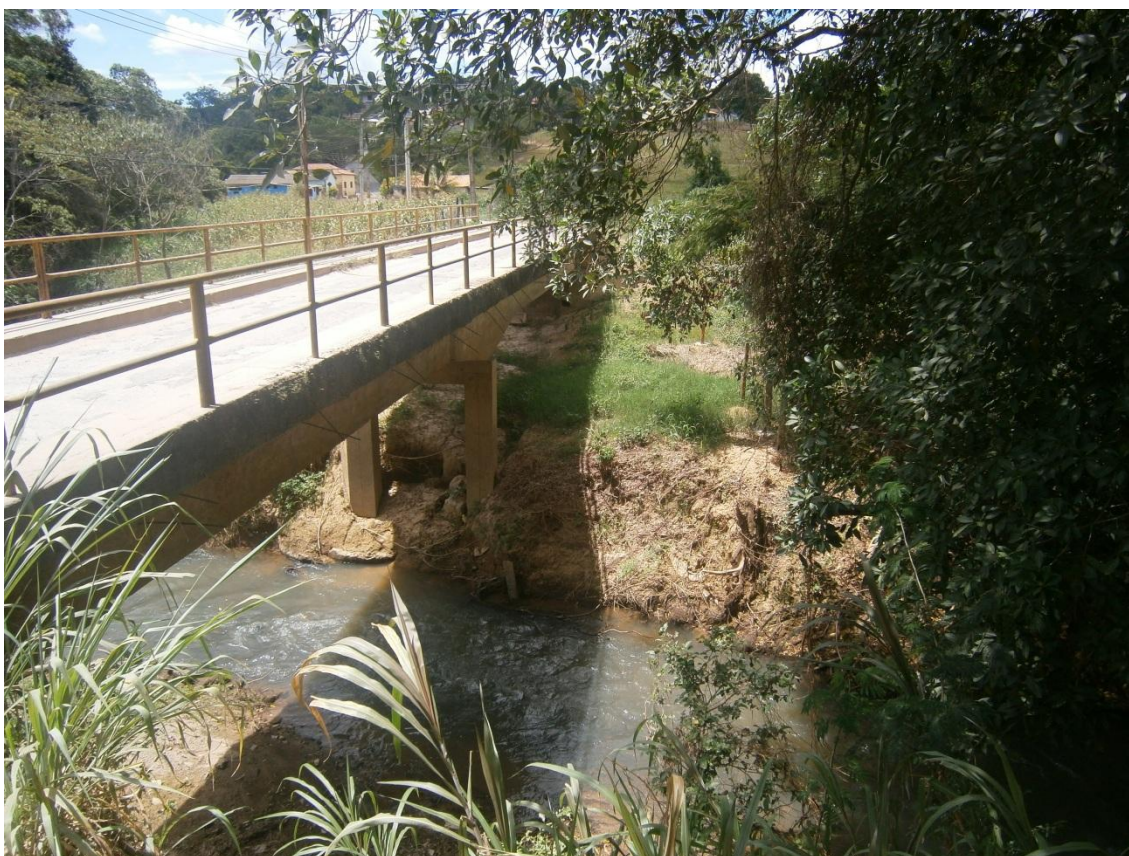
Figura 8- Ponte sobre o córrego Santo Antônio.
