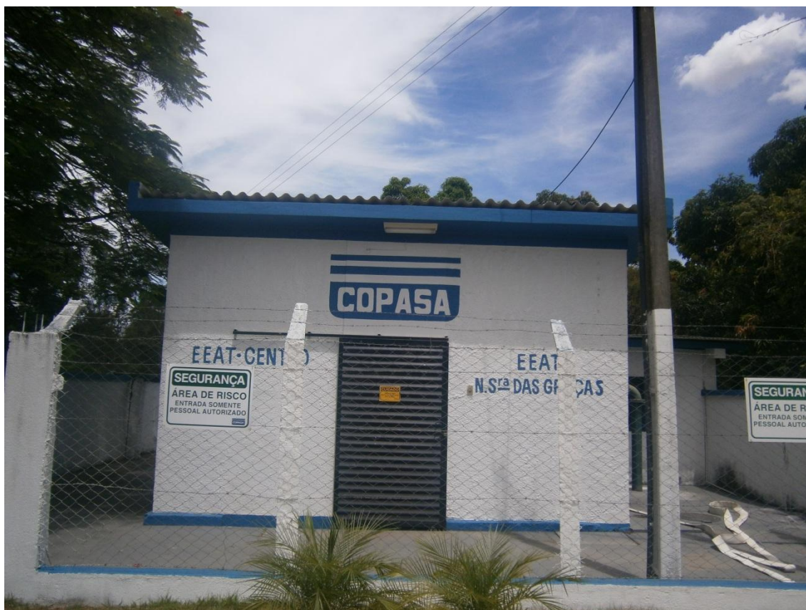
Figura 6 - Estação Elevatória de Água Tratada em Inimutaba.
