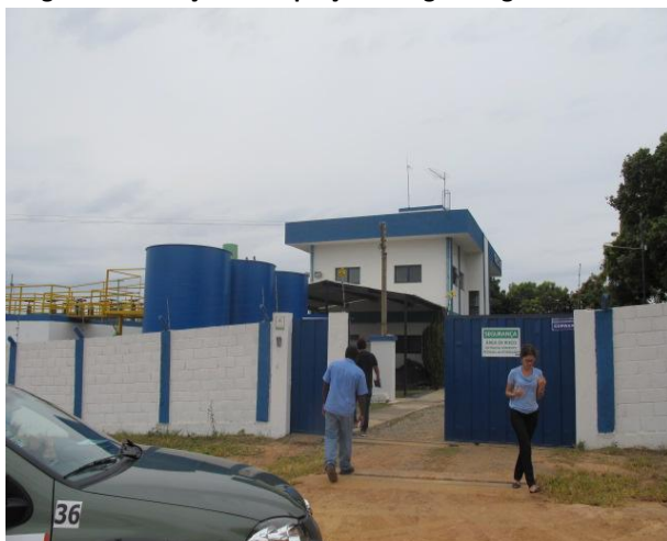
Figura 27 - Estação de Tratamento de Água – agosto de 2013
