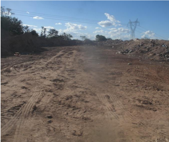
Figura 35 - Valas encerradas com cobertura correta de terra
