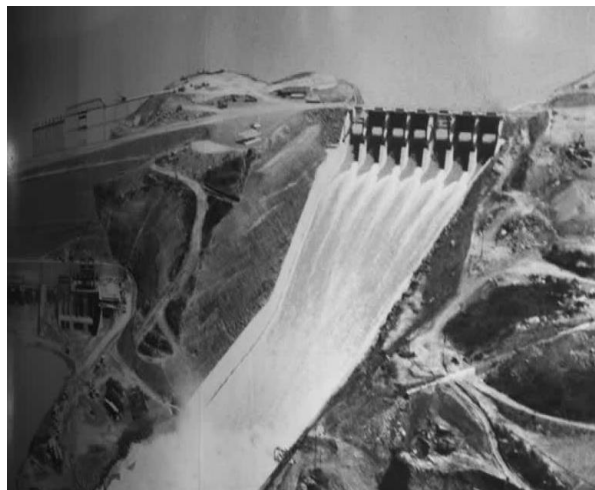
Figura 2 - Barragem de Três Marias em 1961– MG
