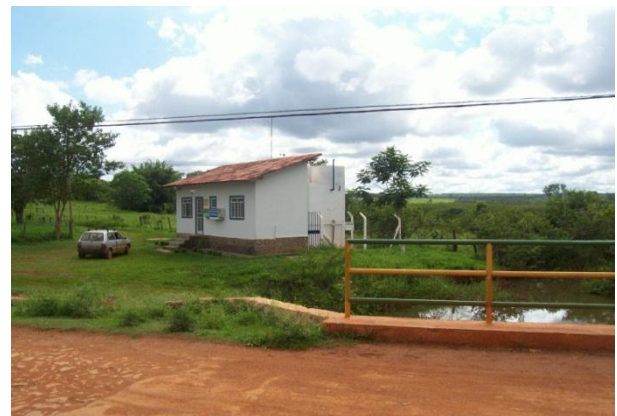
Figura 7: Sede, tratamento e bombeamento, próximo ao Córrego do Morro Fonte: Gesois, 2014
