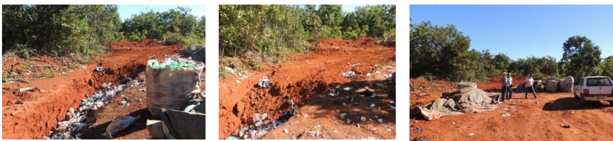
Figura 13: Valas em operação, em cobrimento e coberta Fonte: Gesois, 2014
