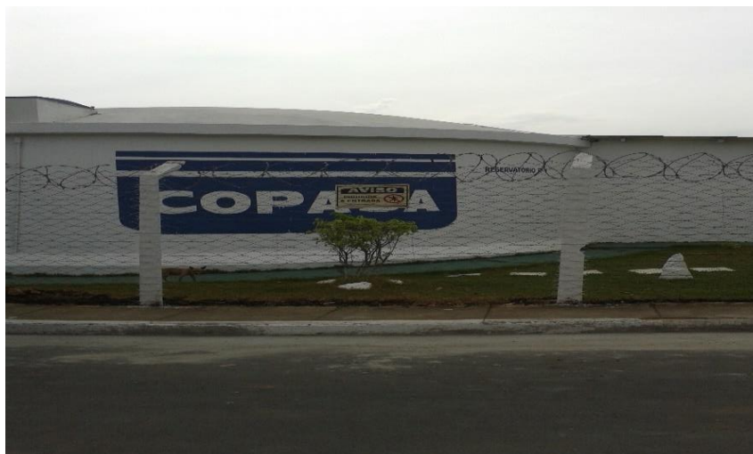
Figura 11: Reservatórios de água da sede Fonte: Prefeitura Municipal de Cordisburgo, 2015
