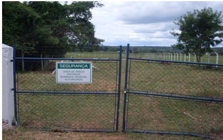
Figura 9: Poço artesiano da sede Fonte: Prefeitura Municipal de Cordisburgo, 2015
