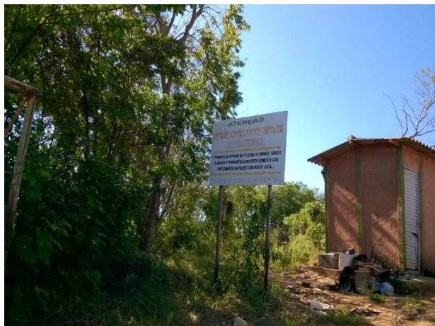
Figura 22: Entrada do aterro controlado municipal
