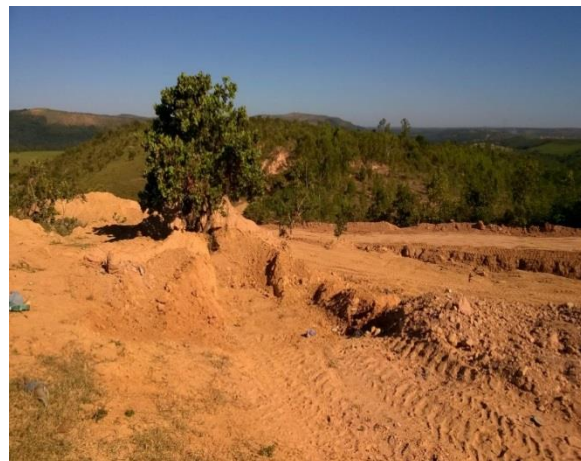
Figura 23: Vala com os resíduos cobertos
