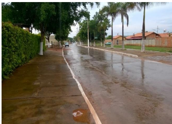
Figura 30: Rua sem sistema de drenagem Fonte: Prefeitura Municipal de Araçá, 2015
