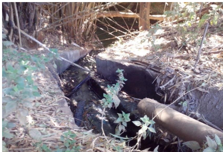
Figura 21: Lançamento de esgotos in natura no Córrego do Candoca
