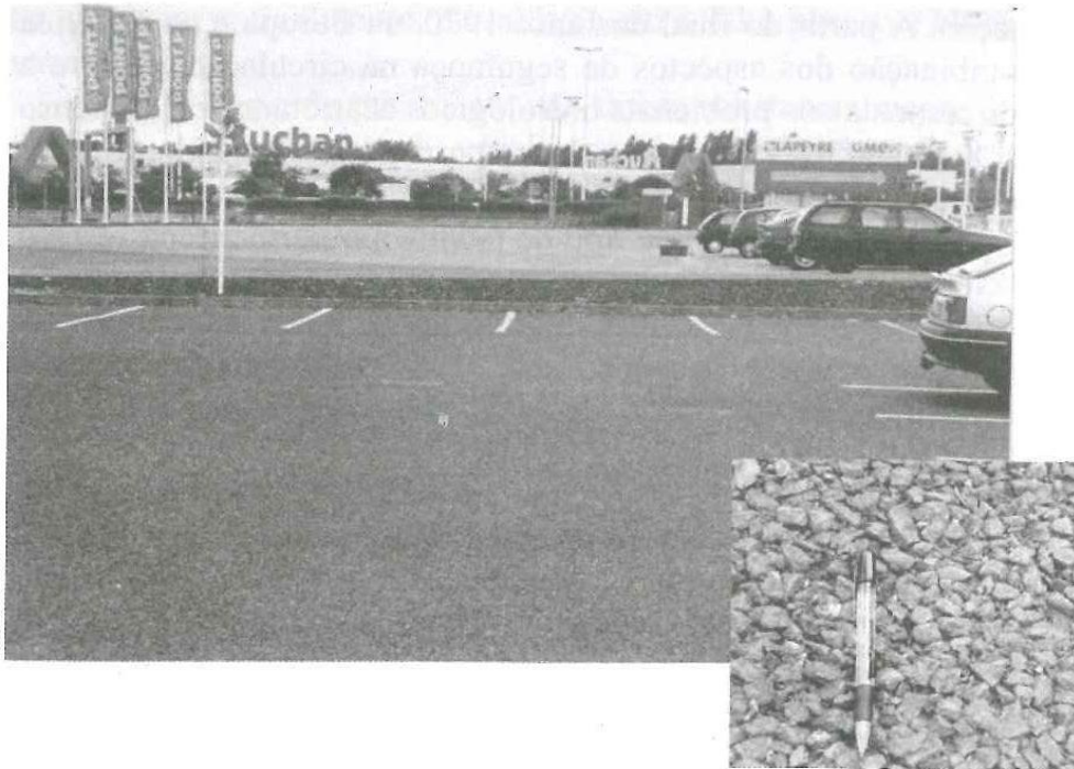
Figura 10.7 – Utilização de pavimento poroso em estacionamento
