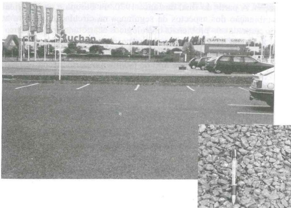
Figura 9.7 – Utilização de pavimento poroso em estacionamento
