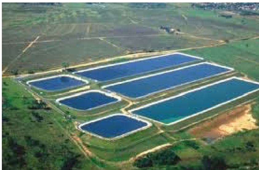
Figura 27: Lagoas de Estabilização Fonte: USP, 2014
