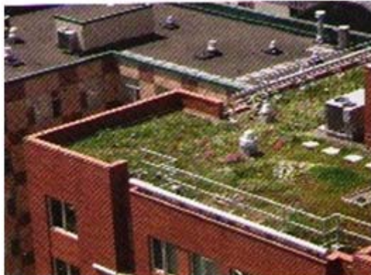
Figura 55: Telhado reservatório / telhado verde Fonte: Portland, 2002
