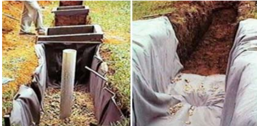
Figura 47: Exemplos de trincheira de infiltração
