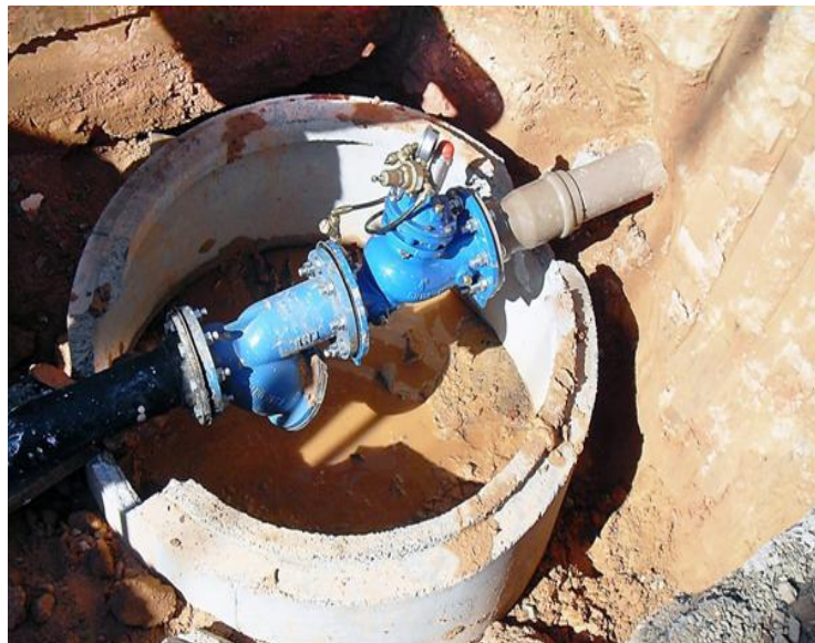
Figura 20: Válvula redutora de pressão Fonte: MINISTÉRIO DAS CIDADES, 2014
