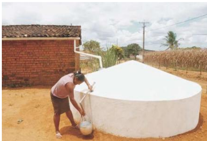
Figura 17: Armazenamento de água das chuvas Fonte: FUNASA, 2011
