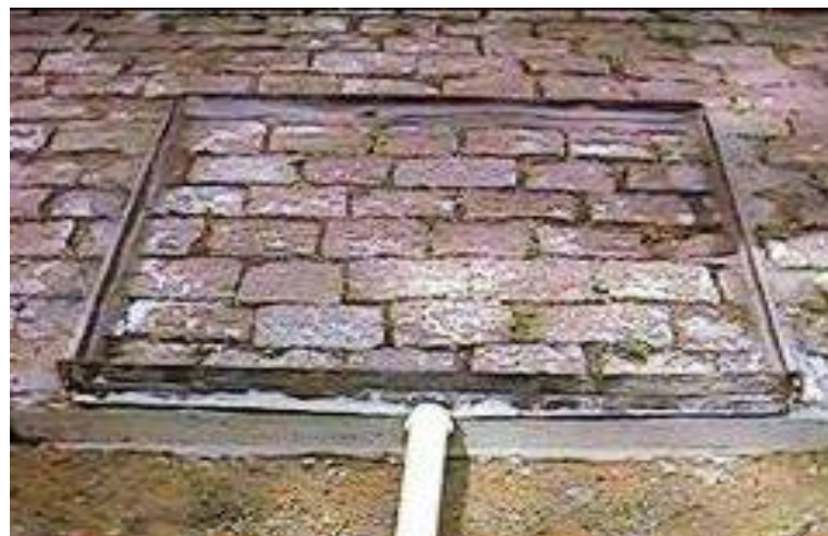
Figura : Pavimento permeável
