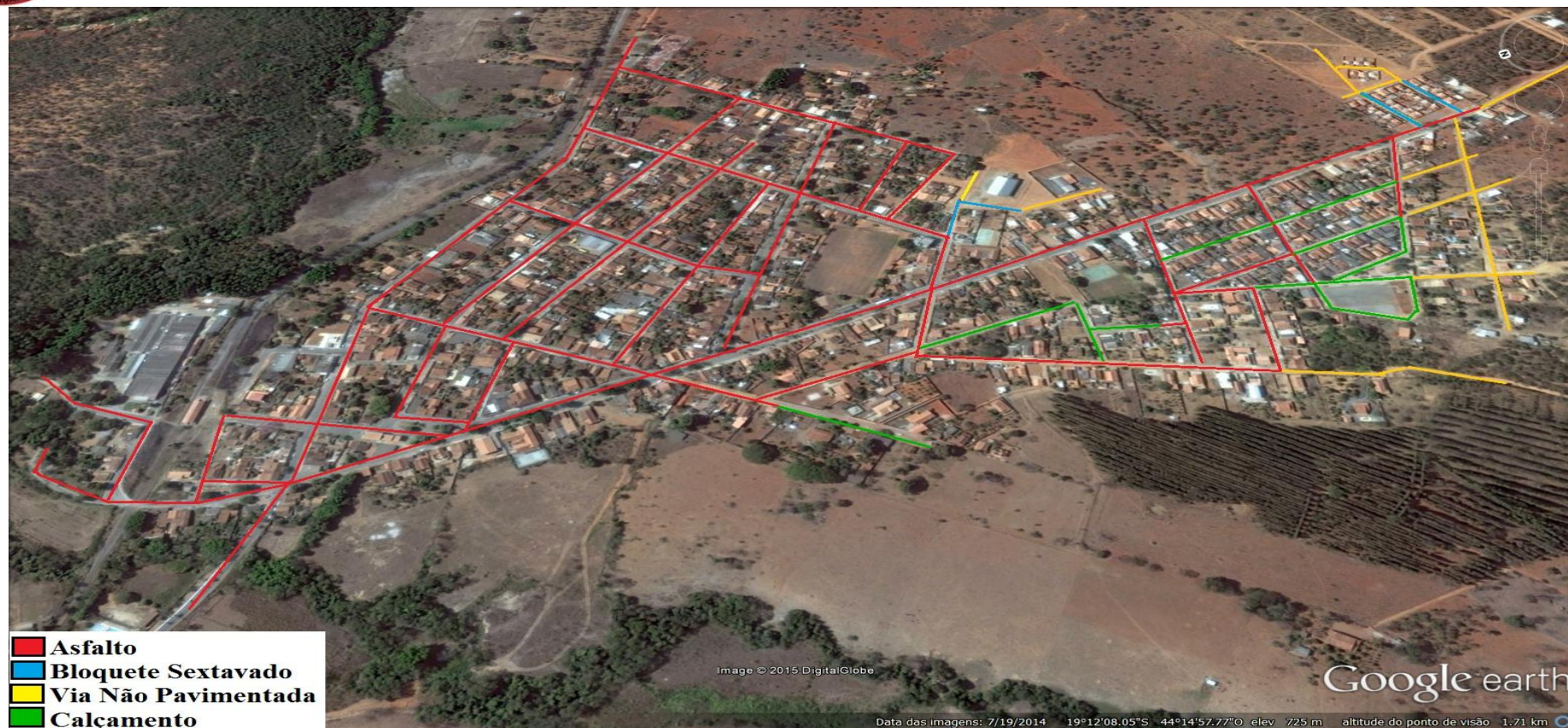
Figura : Pavimentação da área urbana Fonte: Prefeitura Municipal de Araçá, 2015
