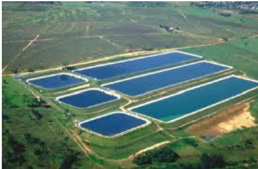
Figura 31: Lagoas de Estabilização Fonte: USP, 2014
