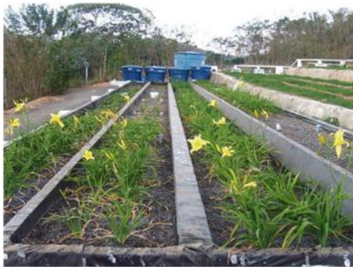
Figura 30: Tratamento de esgoto sanitário em sistemas alagados construídos cultivados com lírio amarelo Fonte: Costa et al., 2003
