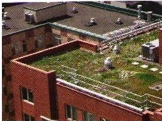
Figura 60: Telhado reservatório / telhado verde Fonte: Portland, 2002
