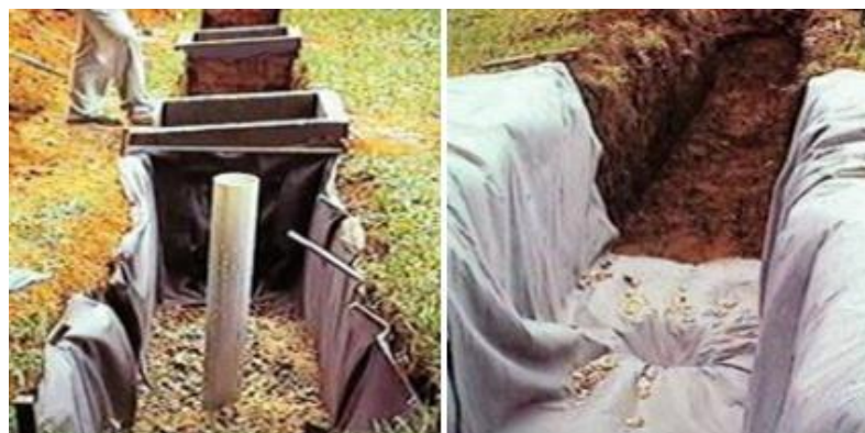
Figura 52: Exemplos de trincheira de infiltração Fonte: Collischonn, 2008
