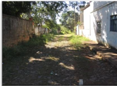
Figura 192: Rua onde tem a saída de água dos bueiros da Professor Ricardo Souza Cruz Fonte: Gesois, 2014
