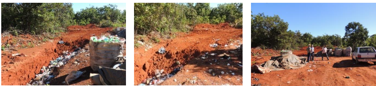
Figura 183: Valas em operação, em cobertura e coberta Fonte: Gesois, 2014
