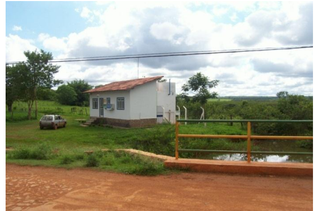
Figura 122: Sede, tratamento e bombeamento, próximo ao Córrego do Morro Fonte: Gesois, 2014
