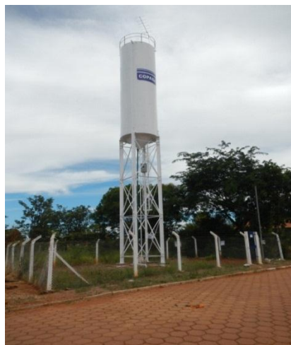
Figura 123: Reservatório Fonte: Gesois, 2014
