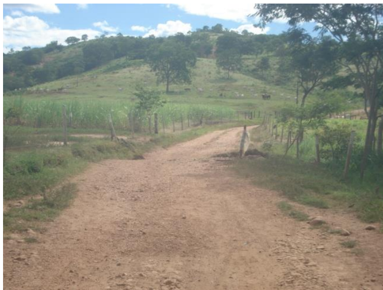
Vista geral da estrada localizada na Fazenda Tabocal
