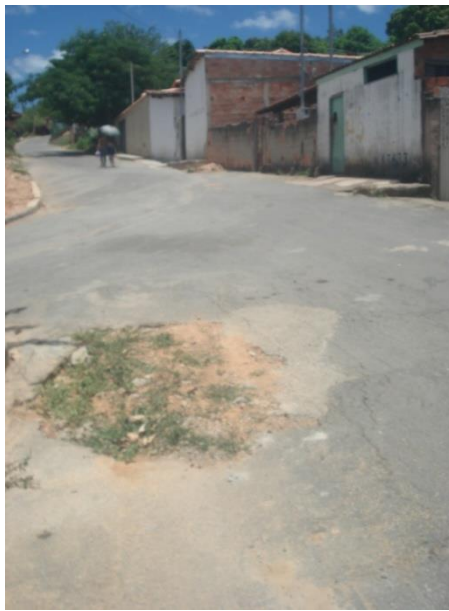
Vista geral da Rua São João
