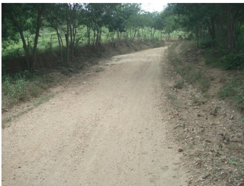
Figura 7.38 – Estrada de terra que dá acesso ao distrito de Fechados.
