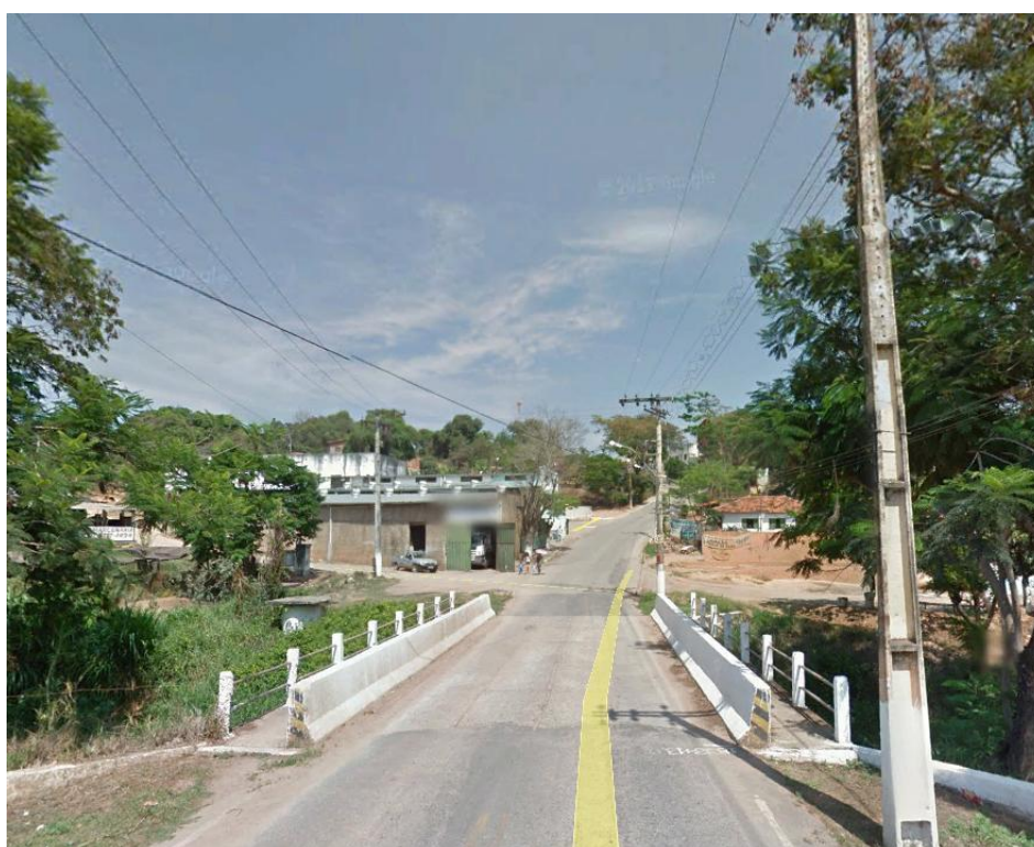
Figura 7.143 – Ponte localizada na Rua Rodrigues Lima
