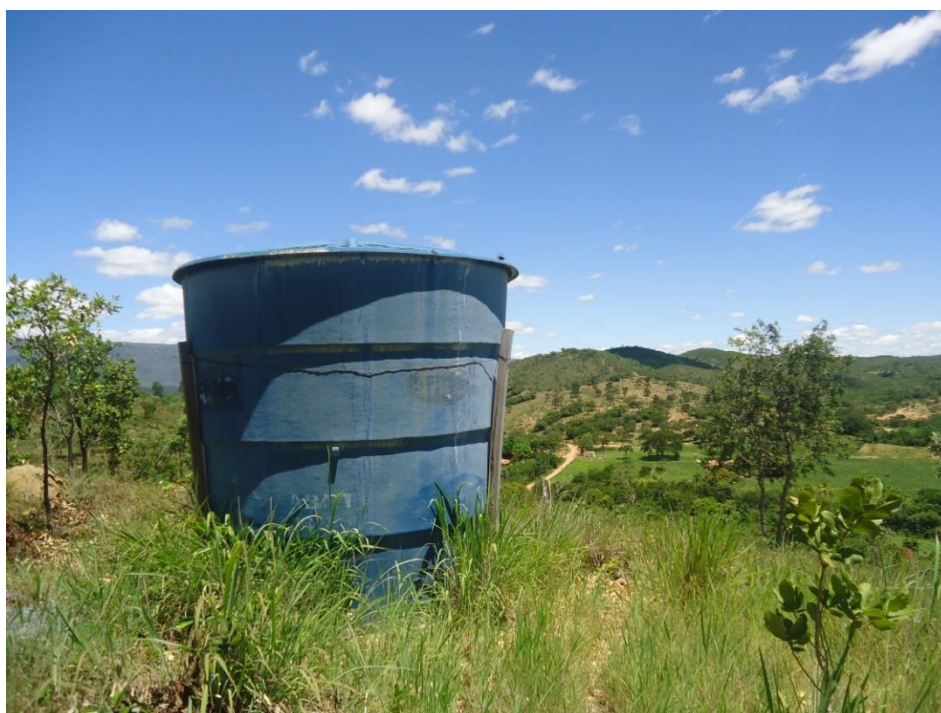
Figura 7.79 – Reservatório Guariba (15m 3 )
