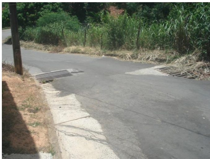
Vista geral da Rua com as duas grades instaladas
