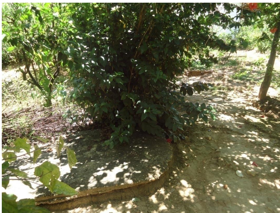
Figura 7.96 – Fossa negra localizada em área rural
