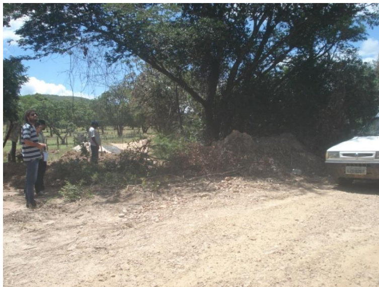
Vista geral do local danificado
