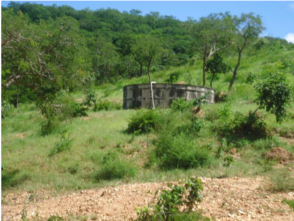
Figura 7.76 — Reservatório Coberto Pequeno (Volume não informado)
