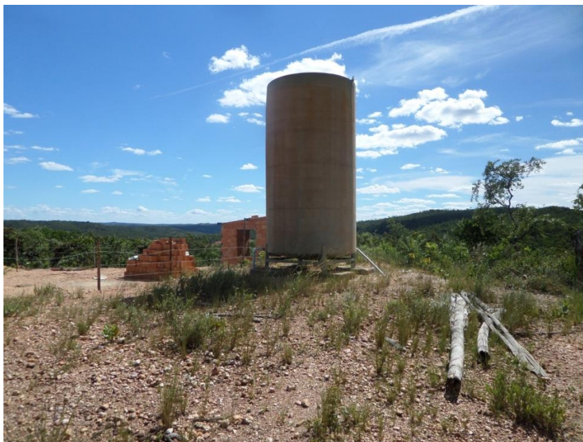
Figura 7.72 – Reservatório Campo Alegre (20m 3 )
