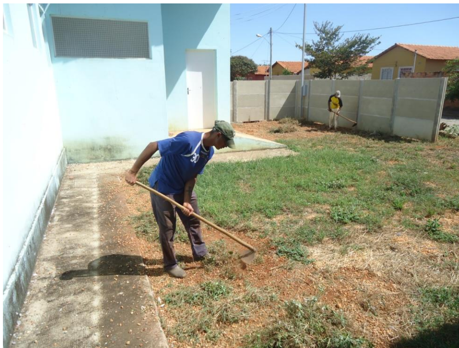
Figura 7.112– Funcionários temporários realizando capina
