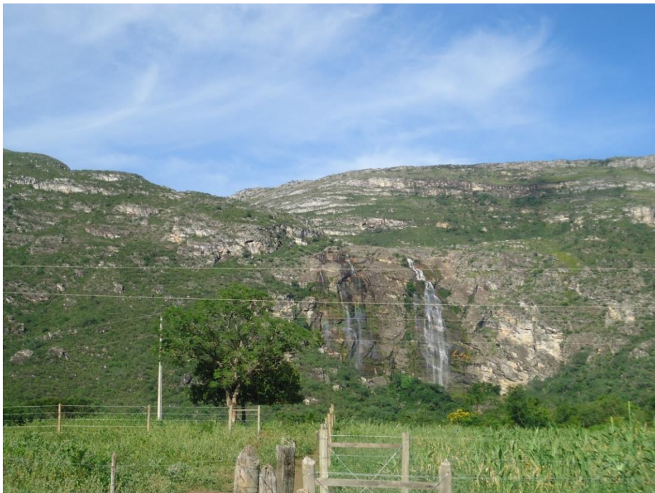
Figura 7.67 - Captação superficial: Inhames
