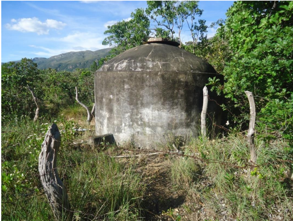
Figura 7.80 – Reservatório Inhames (R1) (Volume não informado)
