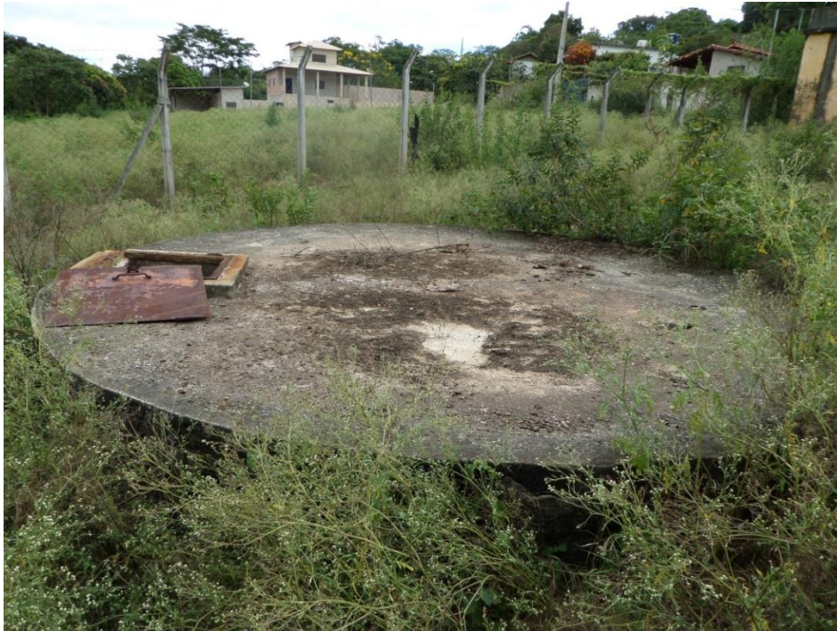
Figura 7.91 – Sistema Fossa Filtro: filtro anaeróbio
