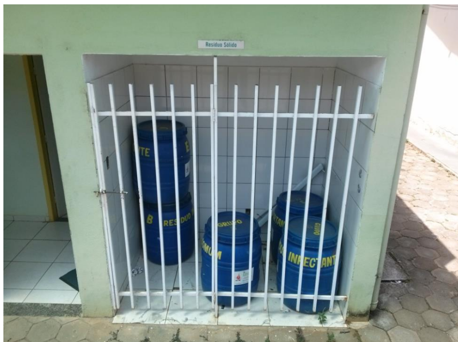
Figura 7.125 – Abrigo para armazenamento das bombonas – Unidade Básica de Saúde do Centro - UBS Centro
