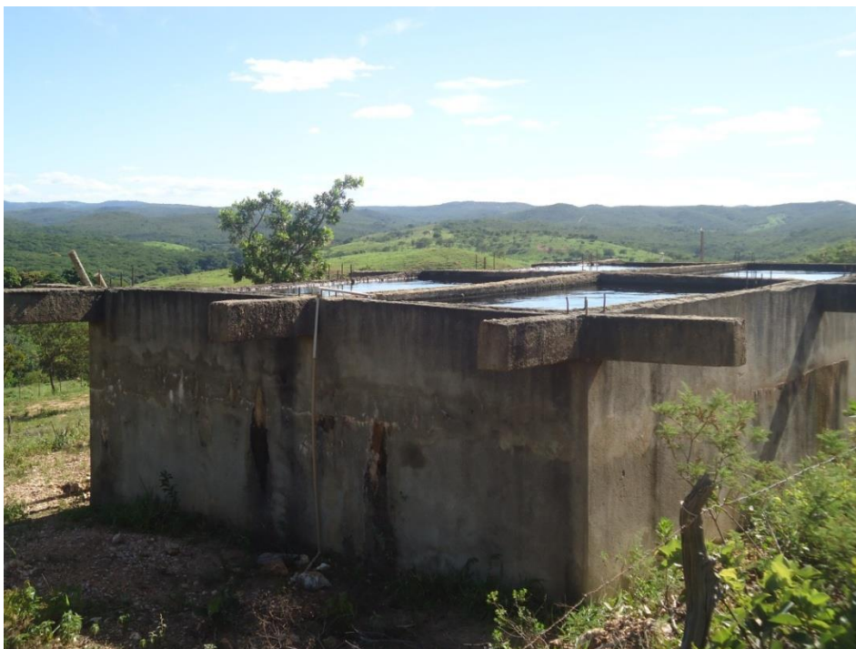
Figura 7.81 – Reservatório Inhames (R2) (Volume não informado)
