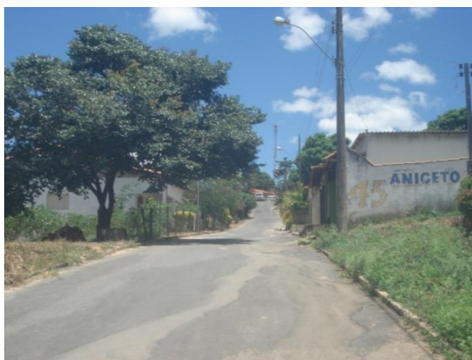
Vista geral da Rua São João
