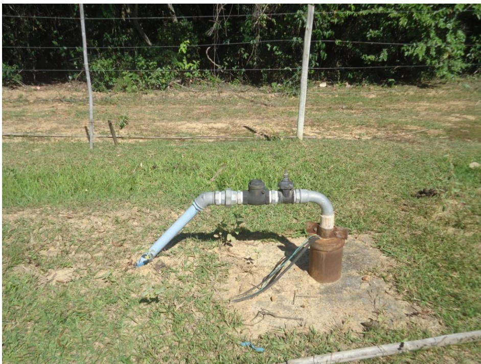
Figura 7.61 - Captação subterrânea: Capão do Inocêncio
