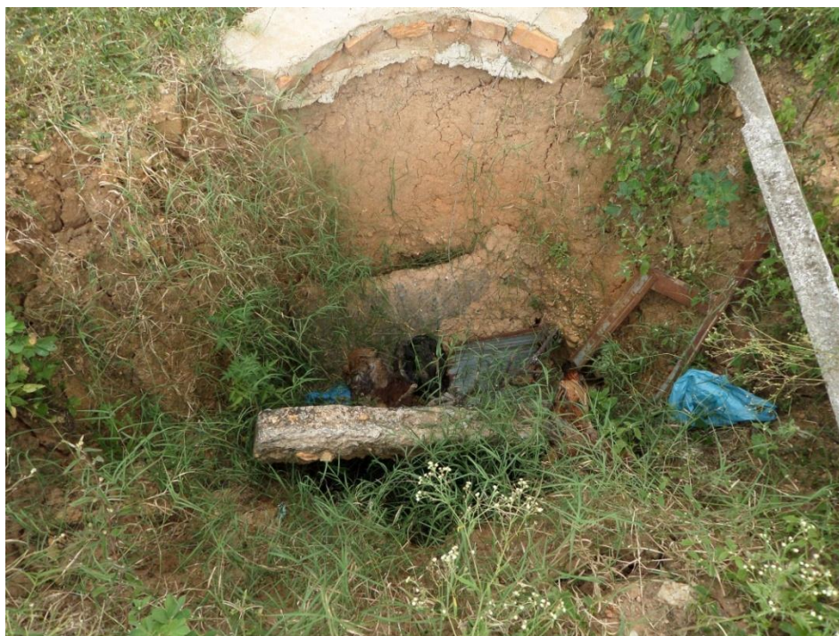
Figura 7.93 – Disposição de resíduos e carcaças de animais nas instalações da ETE
