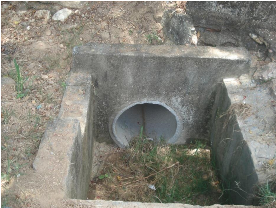
Caixa de captação localizada na Rua das Traíras
