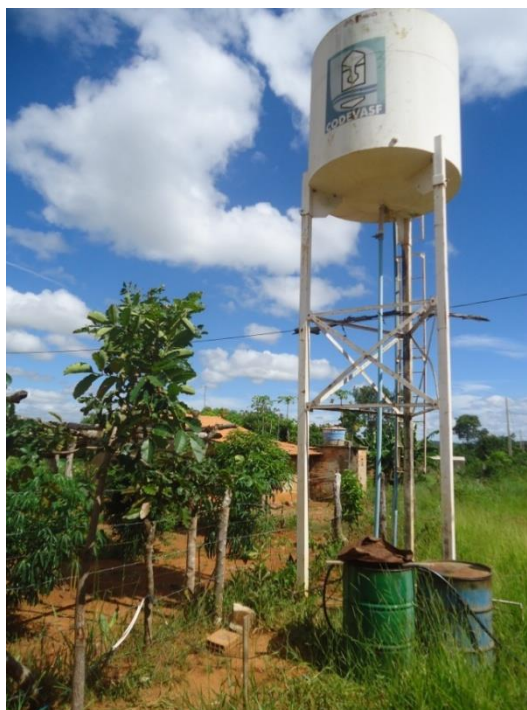
Figura 7.85 – Reservatório Tibuna (15m 3 )
