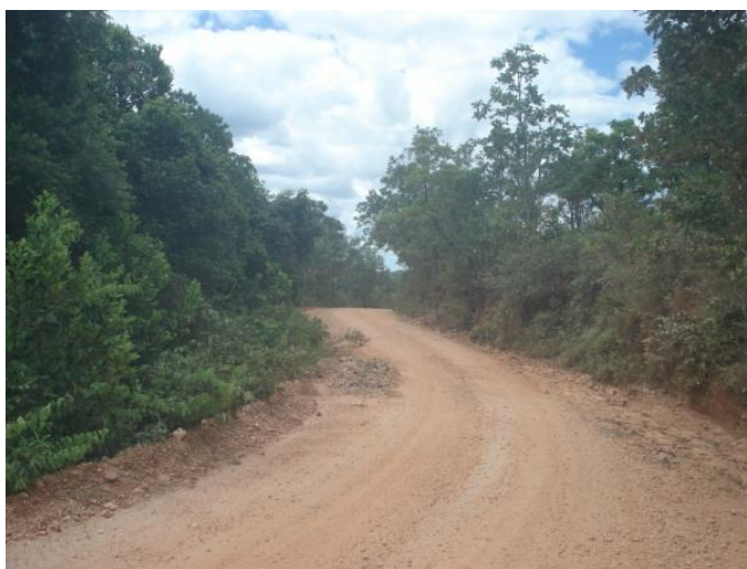
Vista geral da estrada
