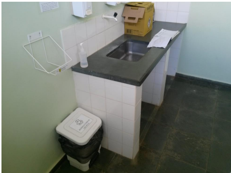
Figura 7.121– Recipientes para acondicionamento de resíduos perfurocortantes (sobre a pia) e resíduos comuns (lado esquerdo) – Unidade Mista de Saúde
