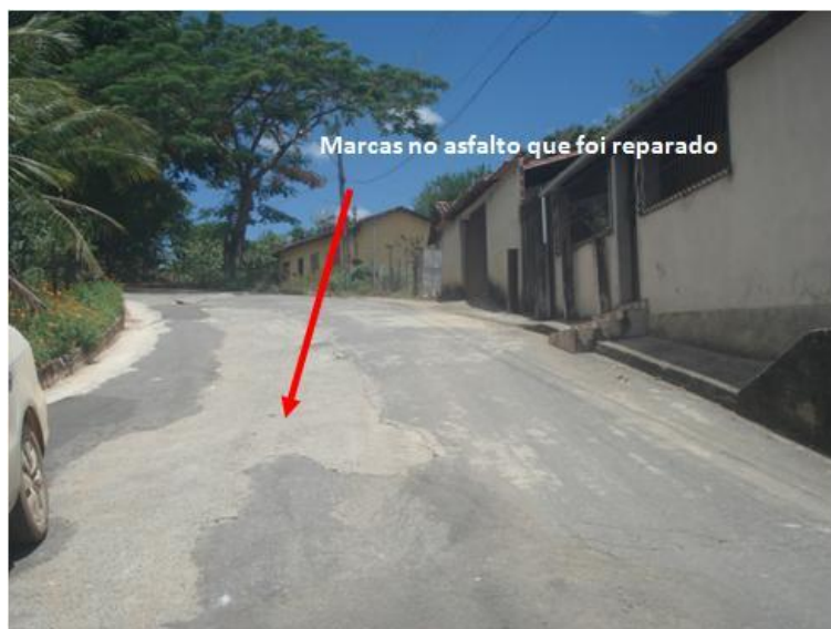
Rua São Joaquim – parte superior da rua
