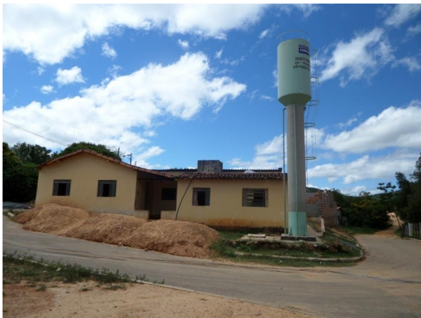
Figura 7.55 – Reservatório R1 de 10m 3
