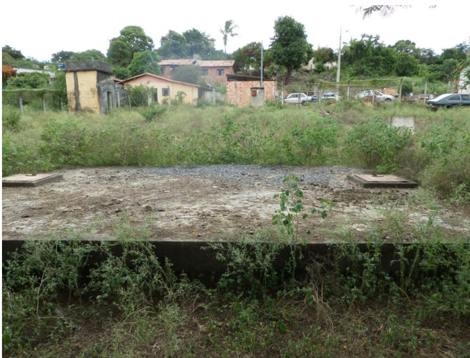
Figura 7.92 – Sistema Fossa Filtro: tanque séptico
