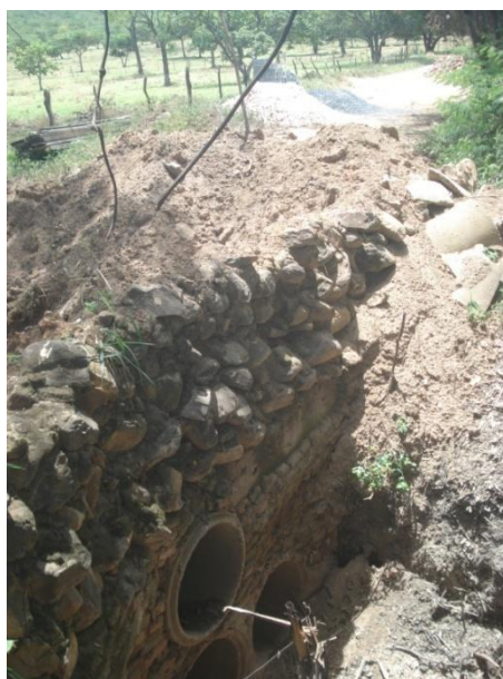
Detalhe da estrada original e o sistema de drenagem de águas pluviais
