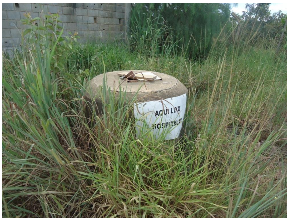
Figura 7.126– Poço do aterro controlado na qual eram dispostos os RSS
