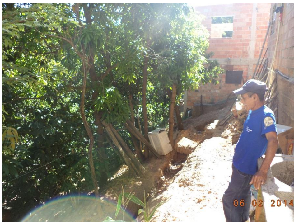
Figura 7.9 – Área de Risco/ Deslizamento de Terra I
