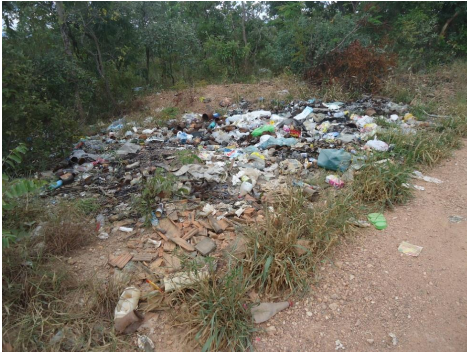
Figura 7.106– Resíduos depositados às margens da Estrada de acesso à Inhames
