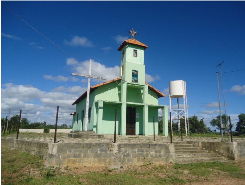
Figura 7.74 – Reservatório Capão do Inocência (10m 3 )
