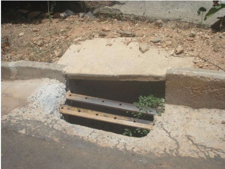
Figura 7.146 -Boca de lobo com grelha – Rua São Joaquim
