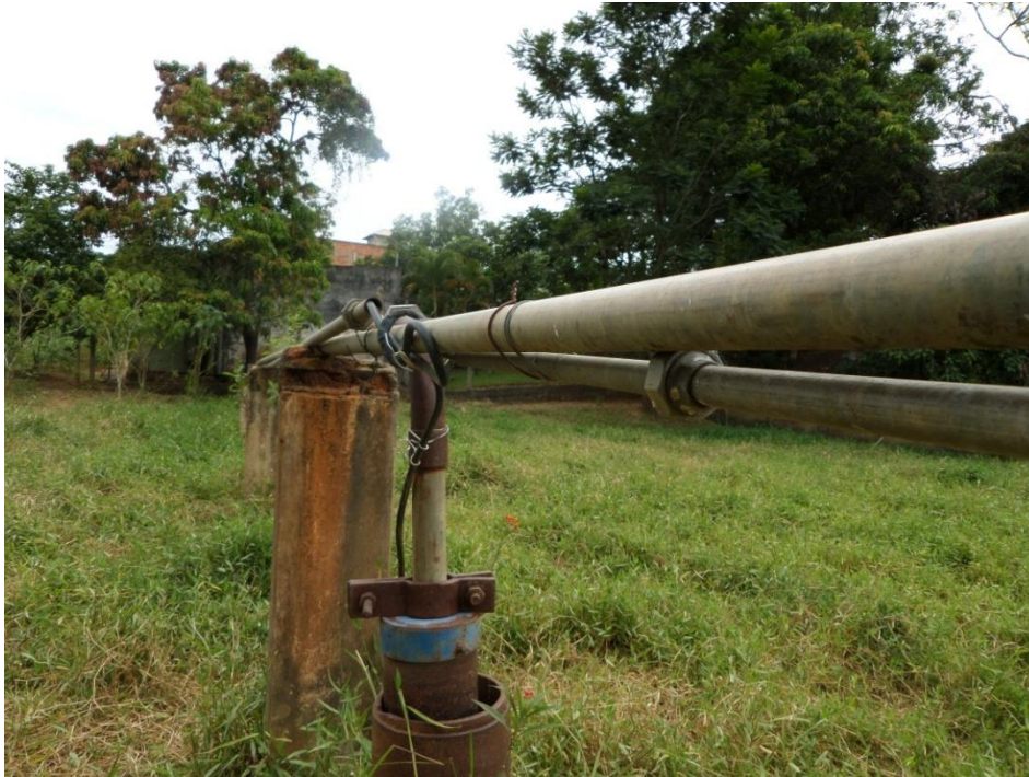
Figura 7.47 – Poço artesiano (P5) para abastecimento da sede municipal
