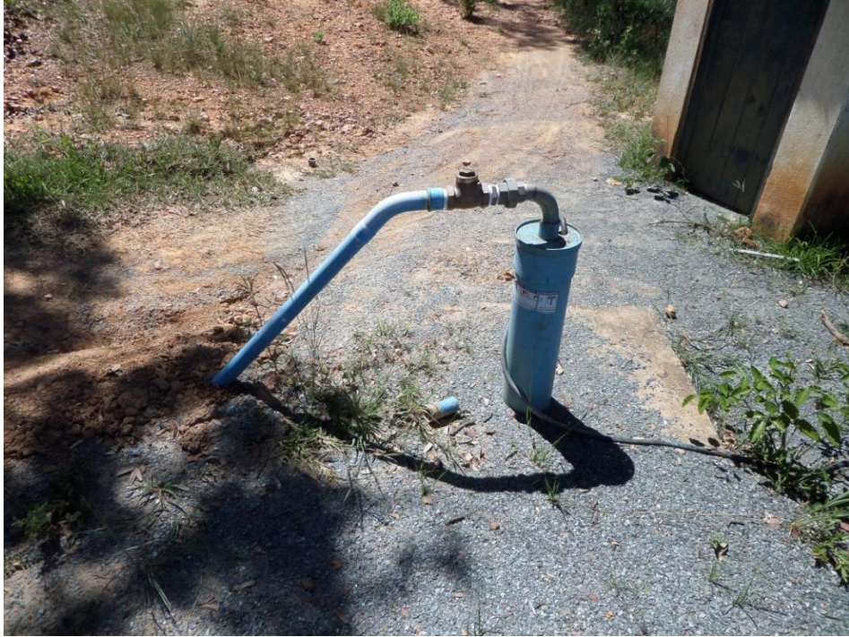
Figura 7-61 - Captação subterrânea: Lapinha (P2)
