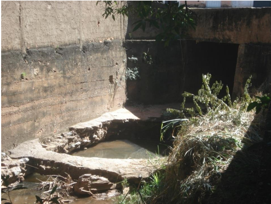
Figura 7-156 - Córrego Salobro – Av.Messias de Castro – trecho canalizado
