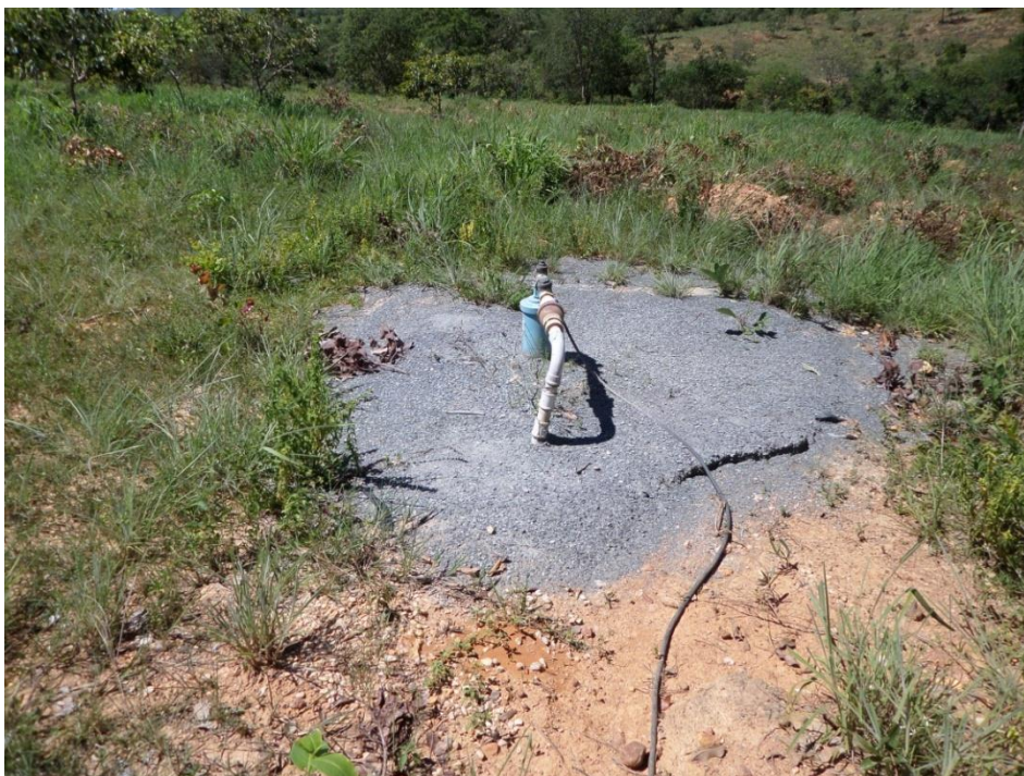
Figura 7-60 - Captação subterrânea: Lapinha (P1)
