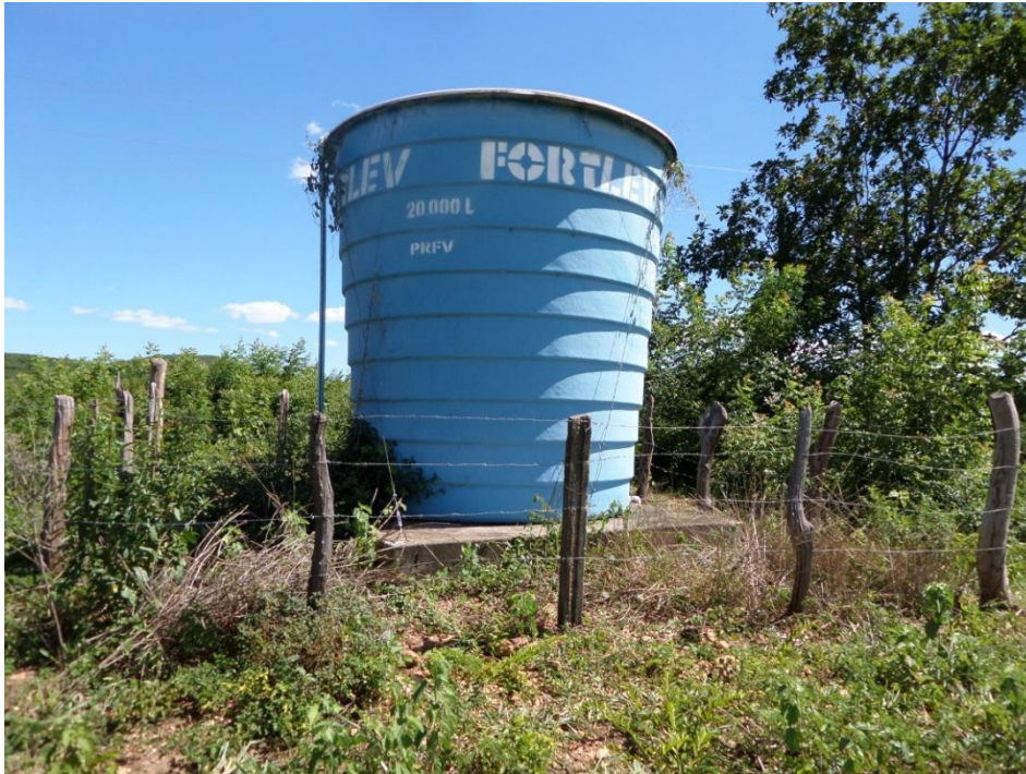
Figura 7-77– Reservatório Fazenda do Sobrado
