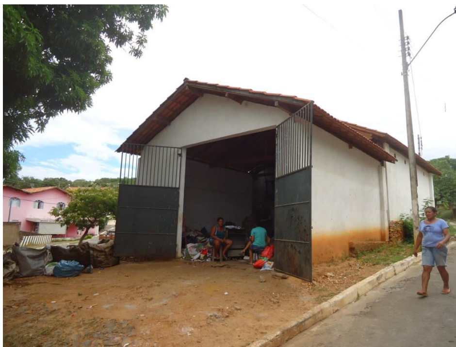
Figura 7.135 – Galpão da Associação de trabalhadores com resíduos recicláveis
