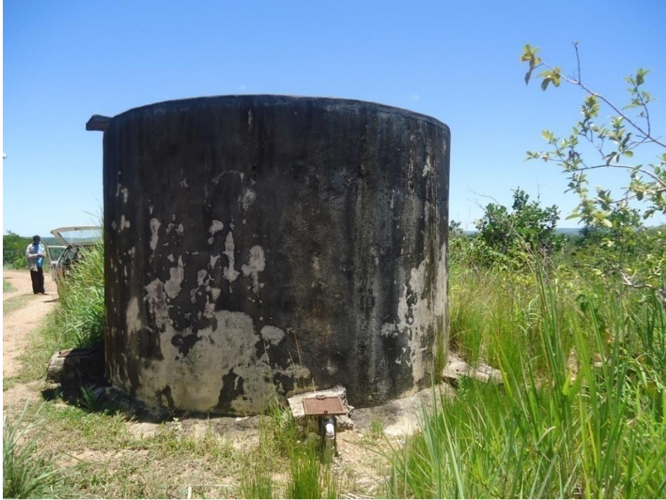
Figura 7-89 – Reservatório Vila São Joaquim (R2)
