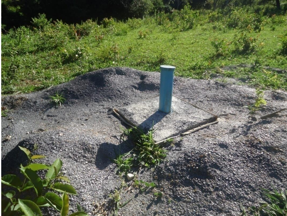
Figura 7-55 - Captação subterrânea: Brejo Tapuio
