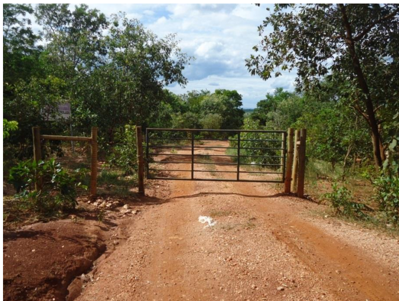
Figura 7.140 – Entrada do aterro controlado municipal
