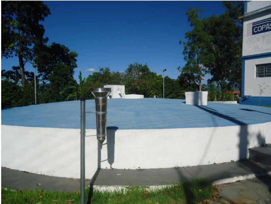
Figura 7-49 – Reservatório enterrado de 150m 3 - COPASA
