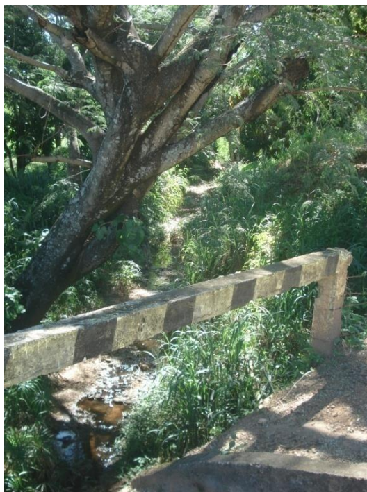
Figura 7-158- Córrego Salobro - trecho natural
