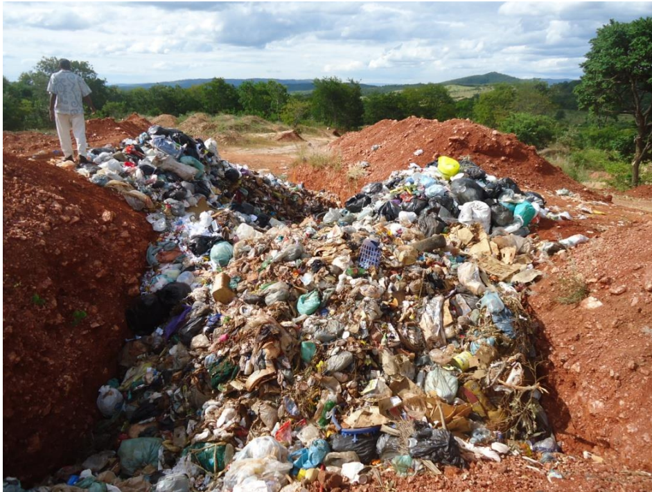
Figura 7.144 – Vala para disposição de RSD
