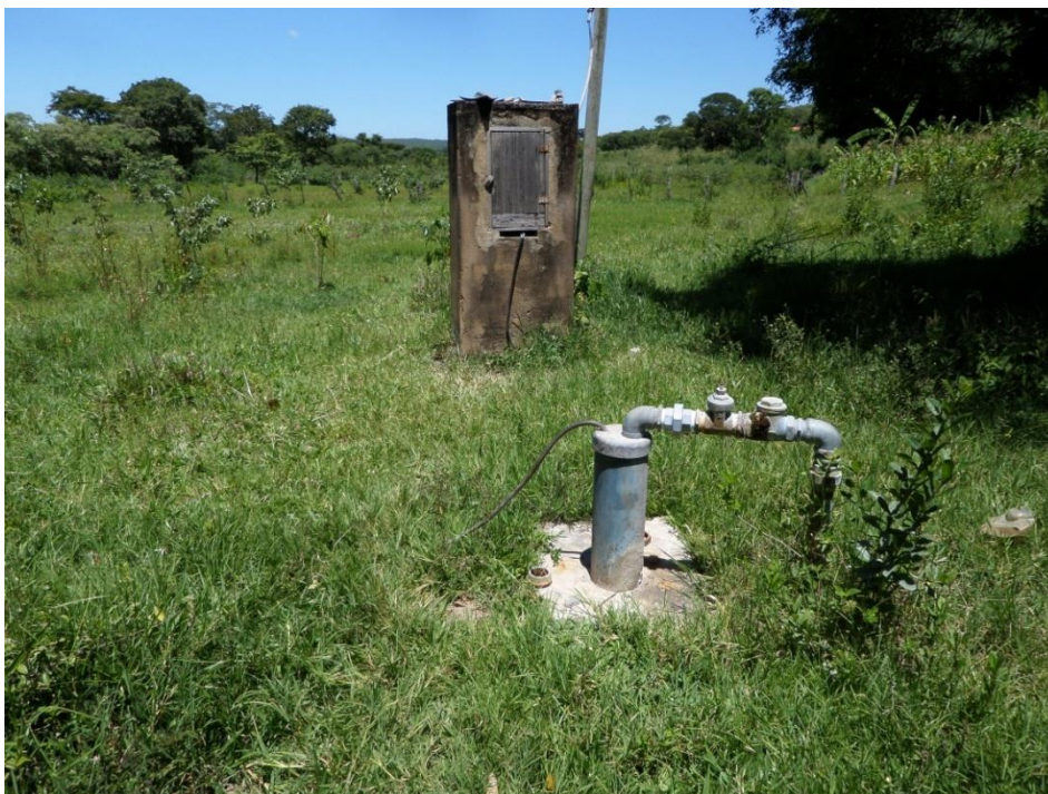
Figura 7-56 - Captação subterrânea: Capão (P1)
