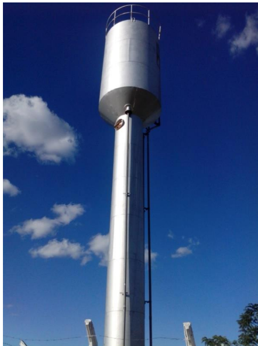
Figura 7-50 – Reservatório elevado de 20m 3 - COPASA
