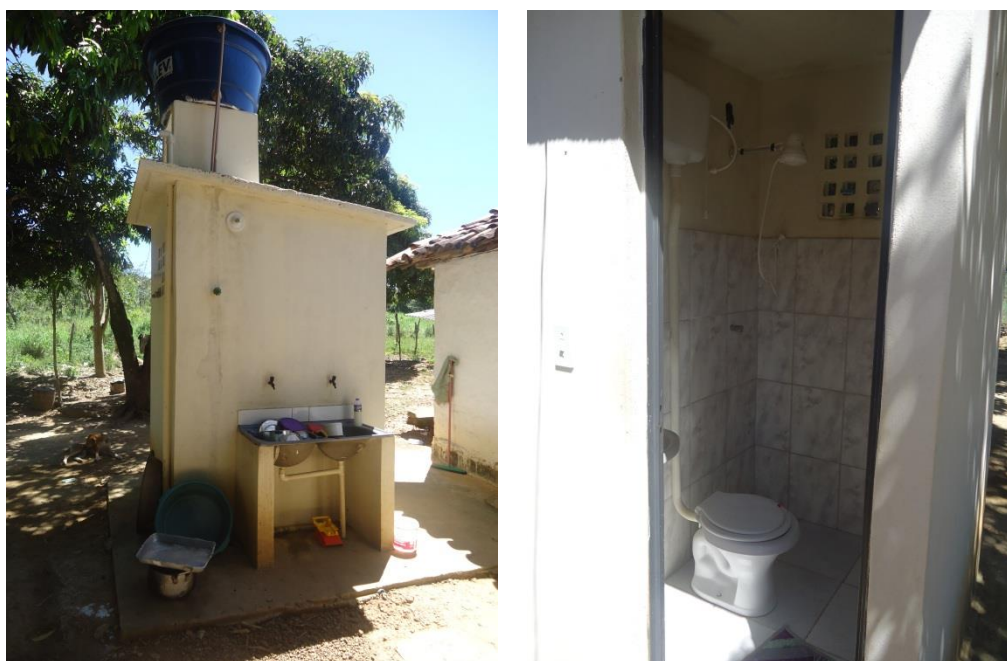
Figura 7-99 – Módulo sanitário instalado na área rural do município
