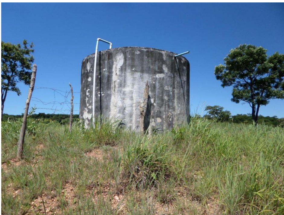
Figura 7-80 – Reservatório Lapinha (R2)
