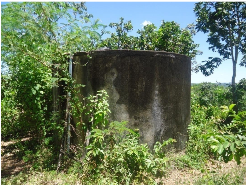
Figura 7-90– Reservatório Vila São Joaquim (R3)
