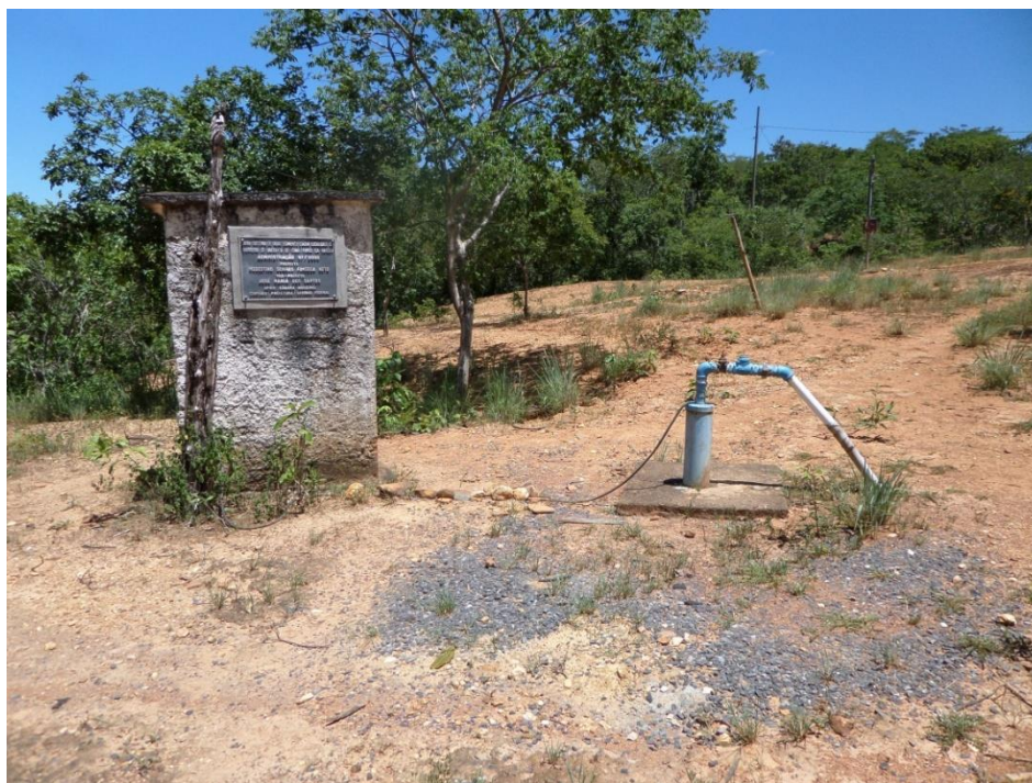
Figura 7-52- Captação subterrânea: Barreiro
