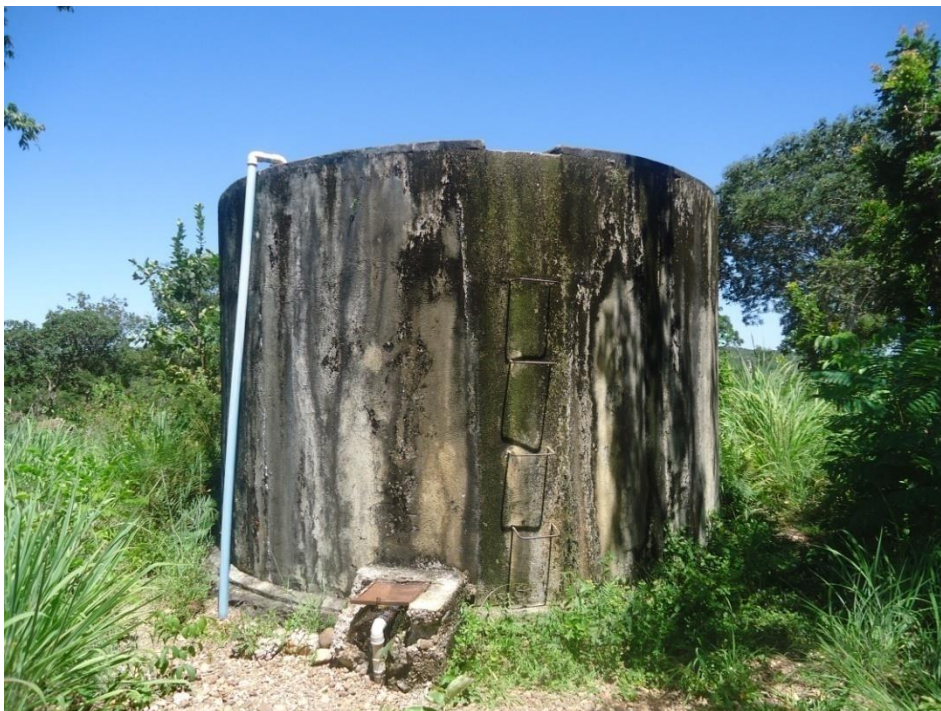
Figura 7-88– Reservatório Vila São Joaquim (R1)
