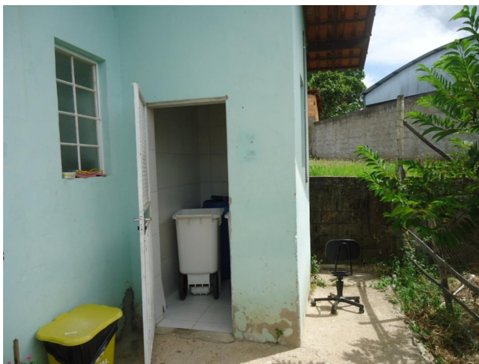
Figura 7.133 – Abrigo para armazenamento de RSS – Unidade Básica de Saúde do Centro – UBS Centro
