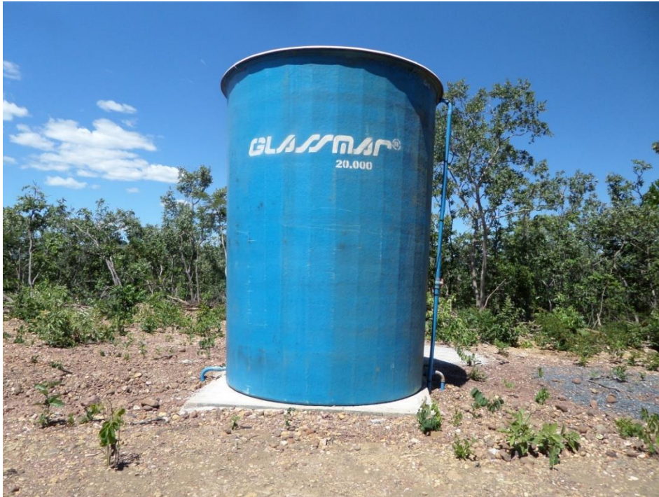
Figura 7-73 – Reservatório Brejinho/Fazenda do Jatobá
