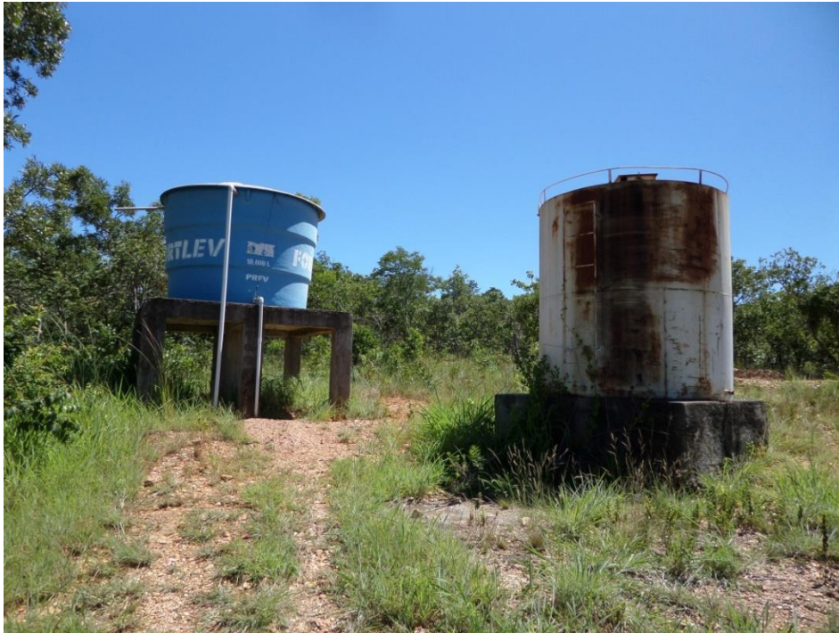
Figura 7-79 – Reservatório Lapinha (R1)
