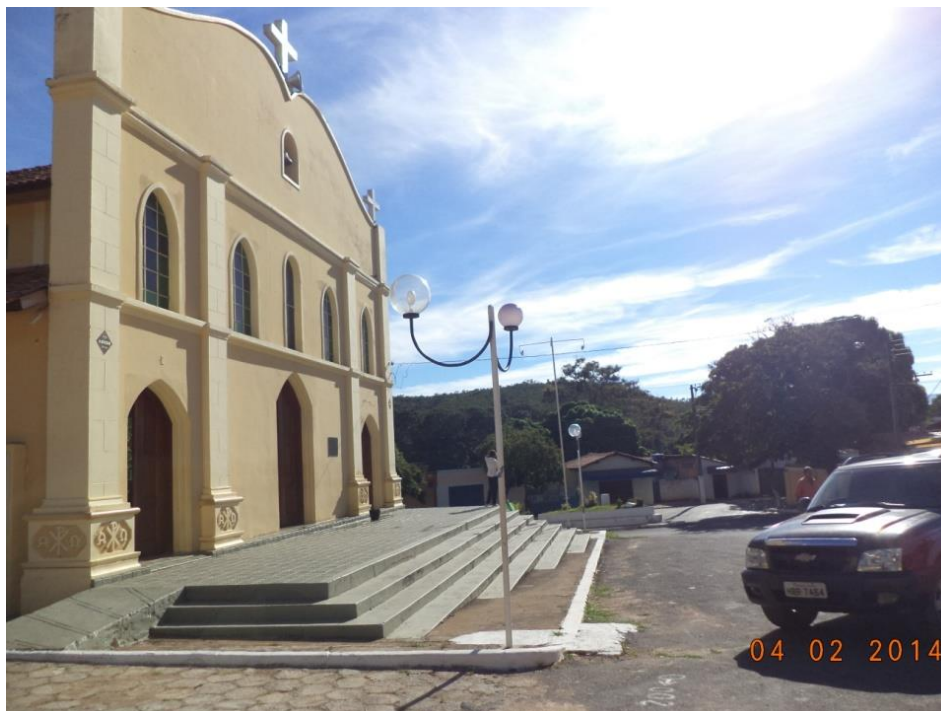
Igreja São Sebastião atingida pela inundação do Rio Paraúna em 1979
