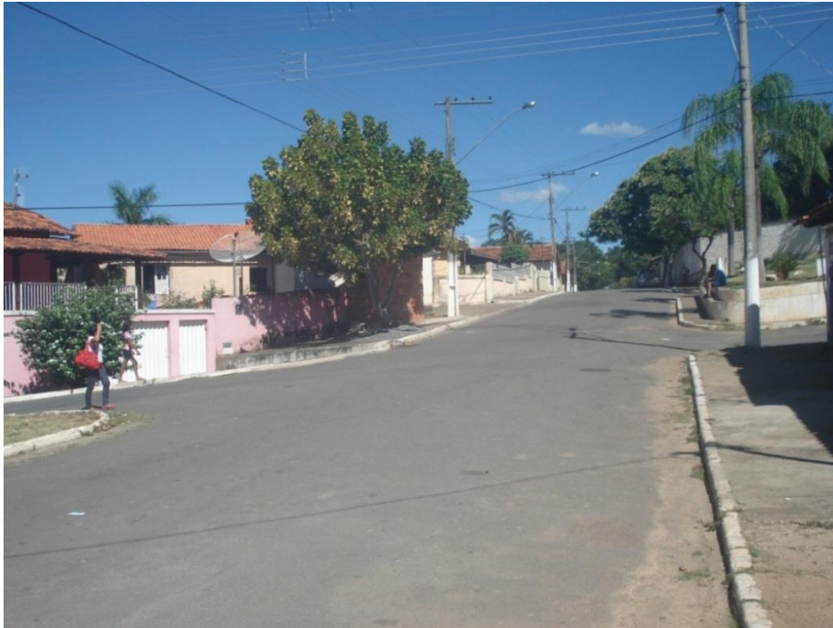
Figura 7-34 – Asfaltamento da Avenida Messias de Castro na sede urbana de Presidente Juscelino
