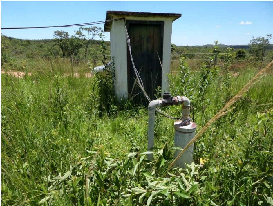
Figura 7-57 Captação subterrânea: Capão (P2)
