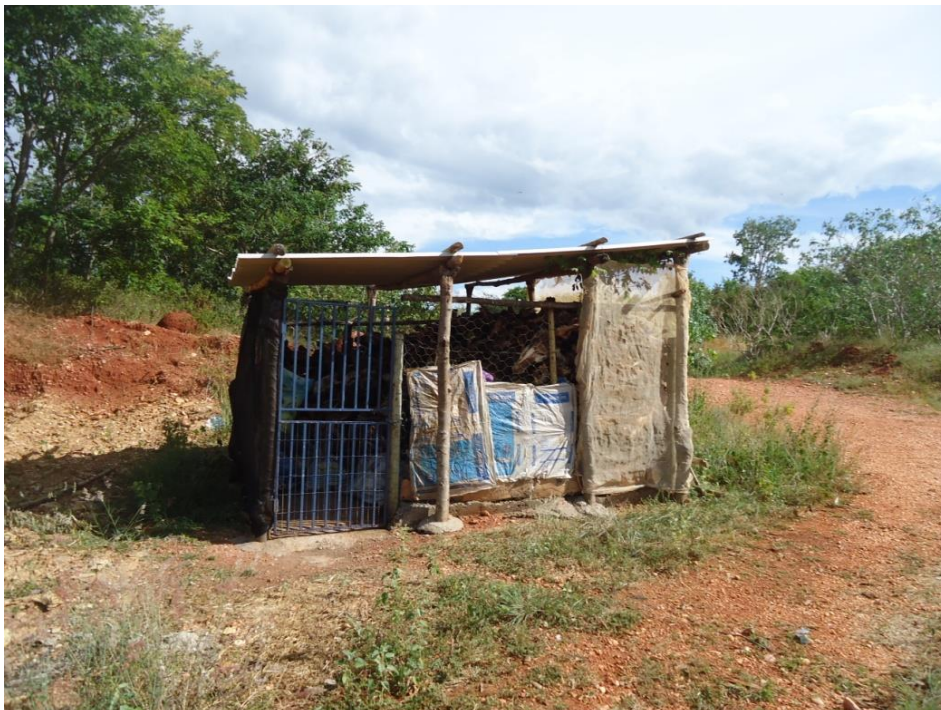
Figura 7.148 – Área para depósito de carcaças de animais após a secagem – Aterro controlado Presidente Juscelino
