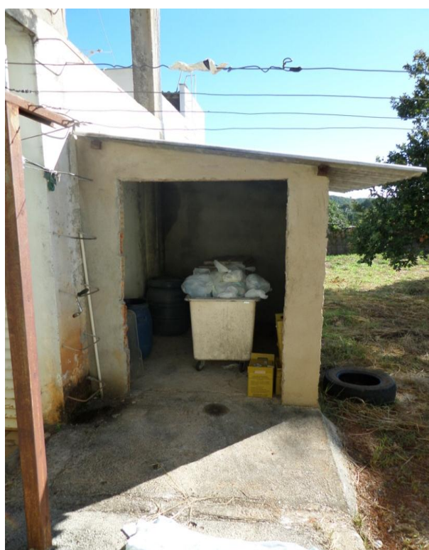
Figura 7.163–Armazenamento temporário de Resíduos de Serviço de Saúde (RSS) no Centro de Saúde de Baldim
