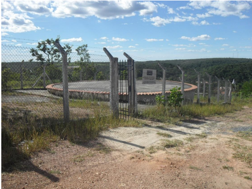
Figura 7.78 – Vista posterior do reservatório do sistema São Vicente
