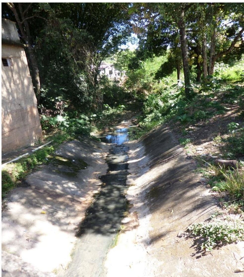
Figura 7.17 – Córrego João da Cruz no centro de Baldim
