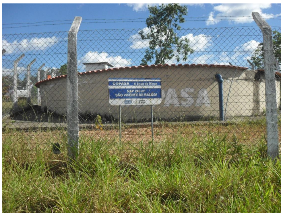
Figura 7.77 – Vista frontal e identificação do reservatório do sistema São Vicente
