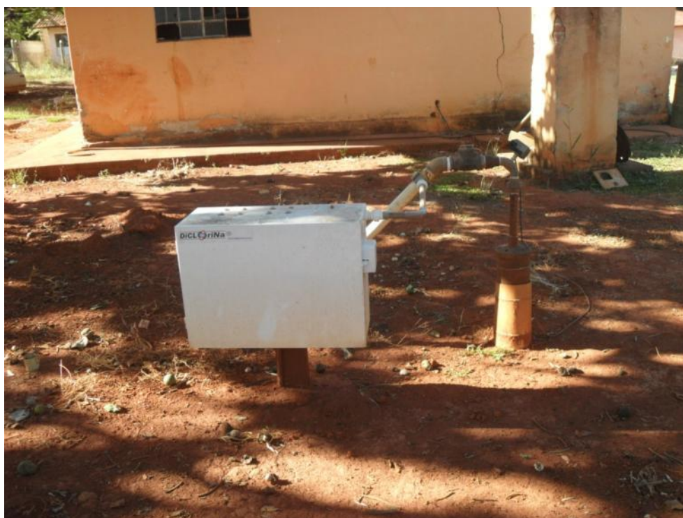
Figura 7.92 – Dosagem de cloro da água do poço de Gameleira da Palma
