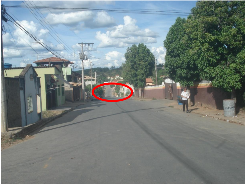
Detalhe do ponto baixo onde ocorrem os alagamentos
