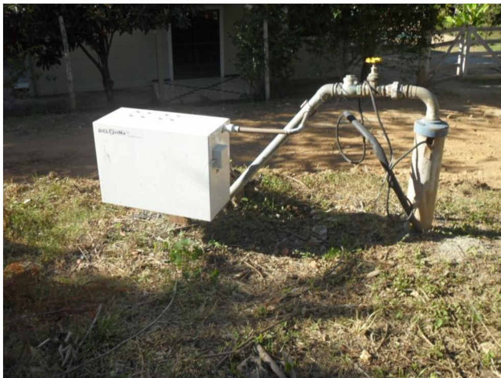
Figura 7.107– Dosador de cloro da água do poço de Timóteo
