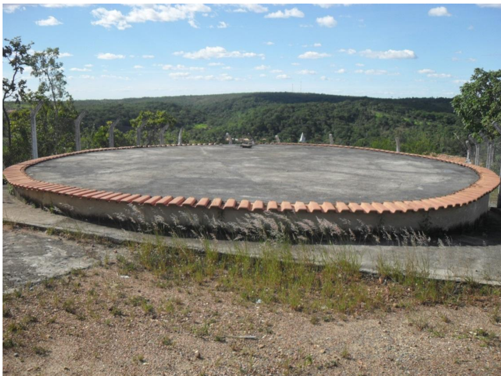
Figura 7.79 – Vista superior do reservatório do sistema São Vicente
