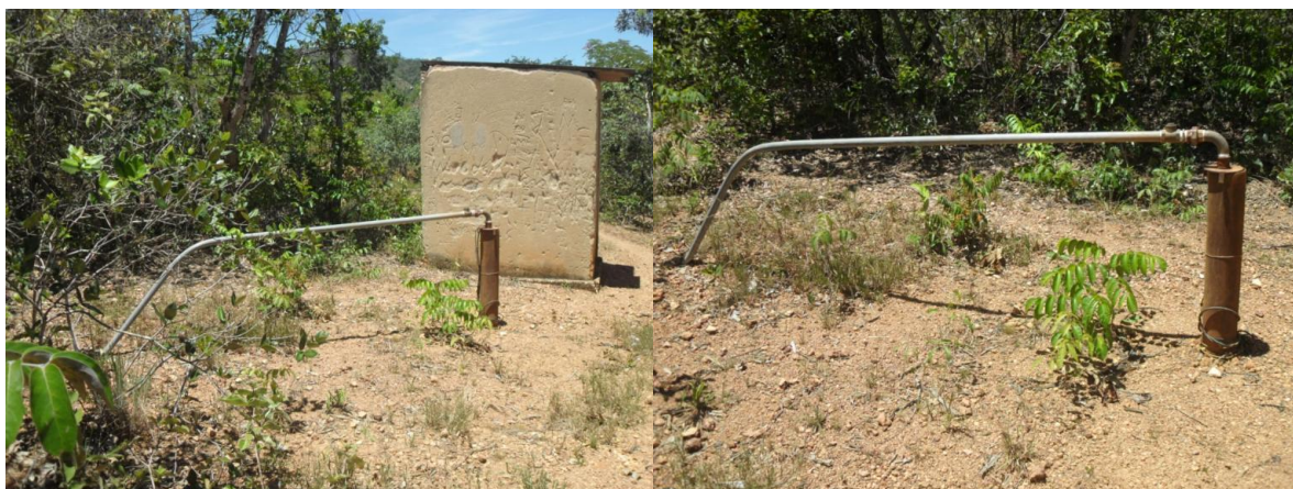
Figura 7.124 – Poço artesiano da Penha
