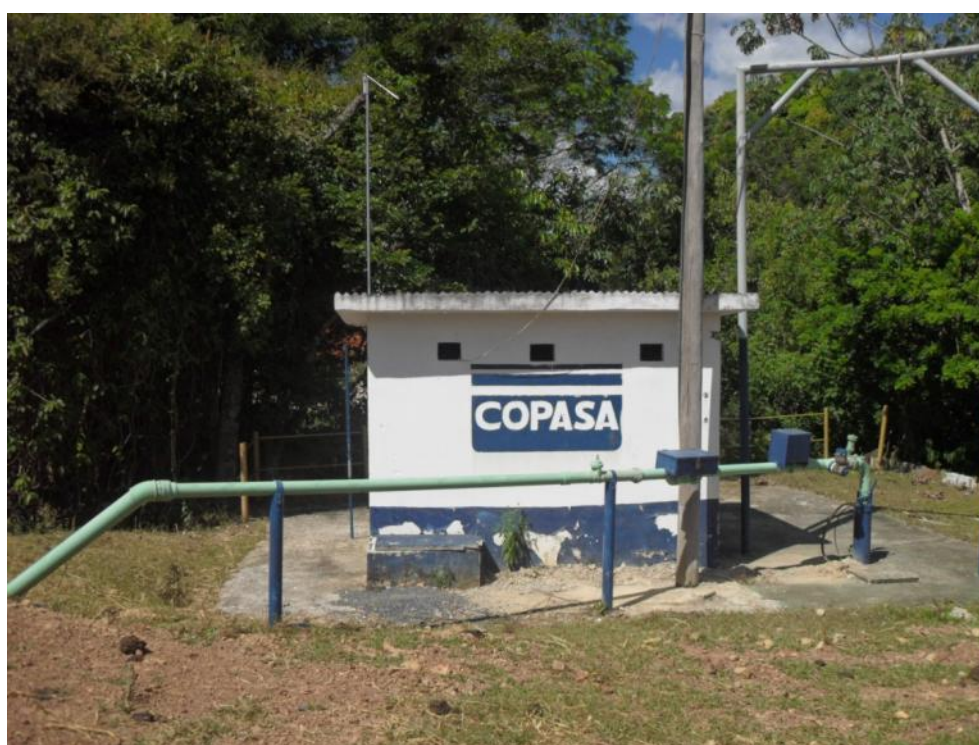
Figura 7.54– Vista geral do poço Chiquito (E-02 Baldim) na Sede
