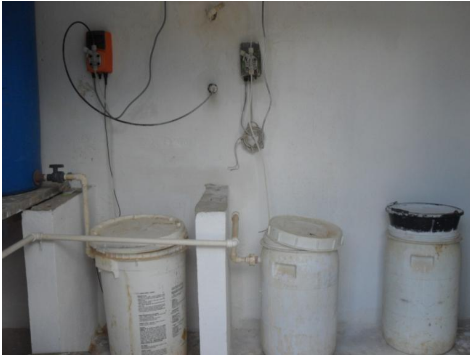
Figura 7.75 – Produtos químicos utilizados no tratamento (soluções de flúor e cloro) do poço Eucalipto (E-02 São Vicente) em São Vicente
