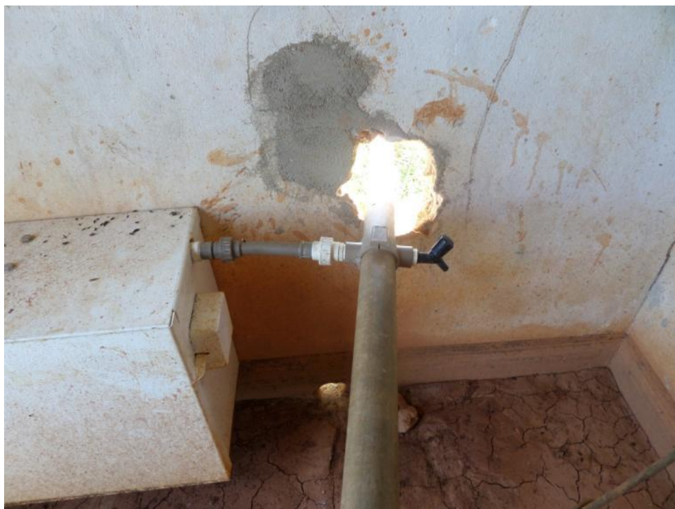
Figura 7.104 – Torneira para amostragem da água
