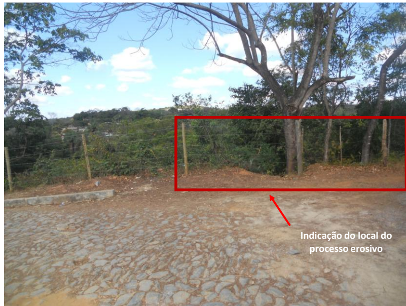
Figura 7.9 – Processo erosivo II - a: Rua Vitalino Francisco da Silva
