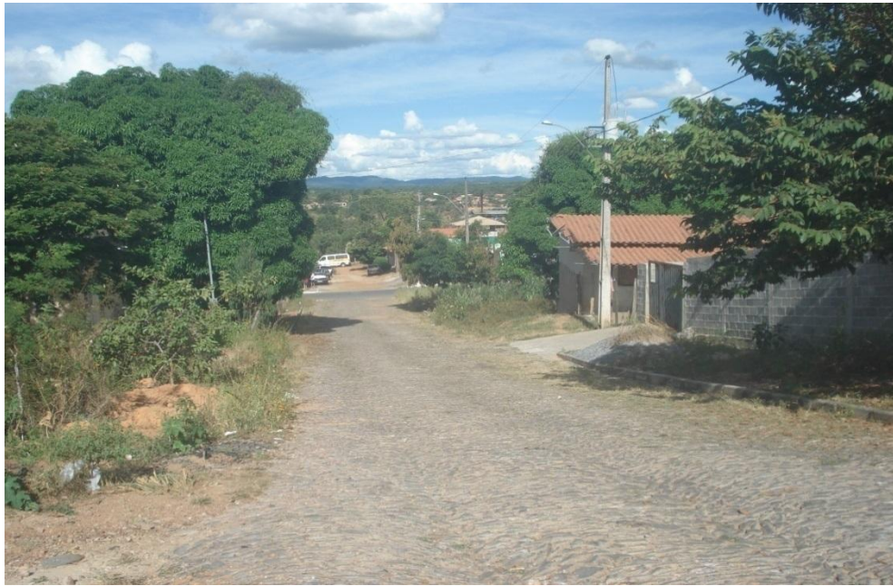
Figura 7.45– Piso poliédrico da Rua José de Carvalho, Sede urbana de Baldim
