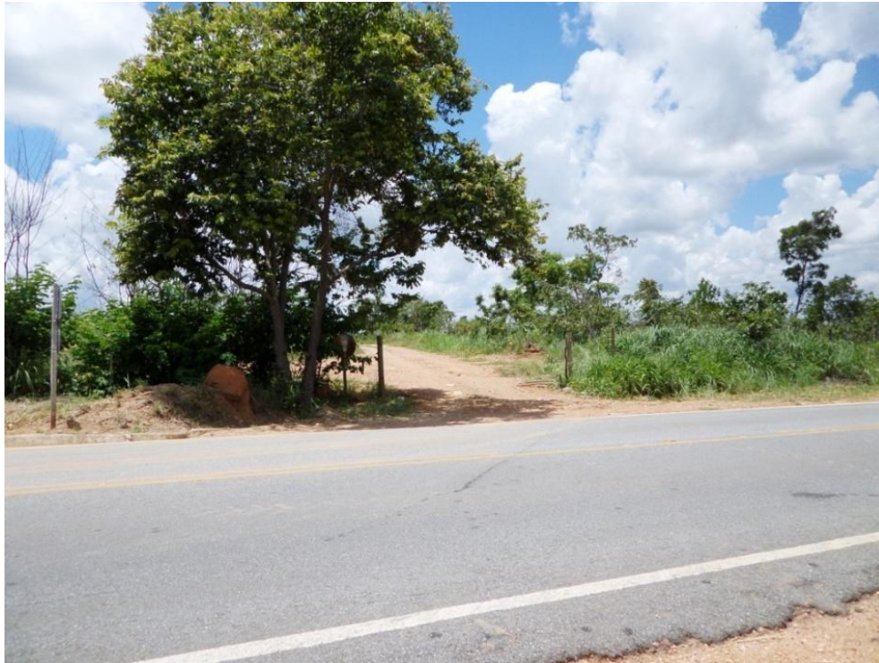
Figura 7.173 – Proximidade entre a entrada do lixão e a MG-323
