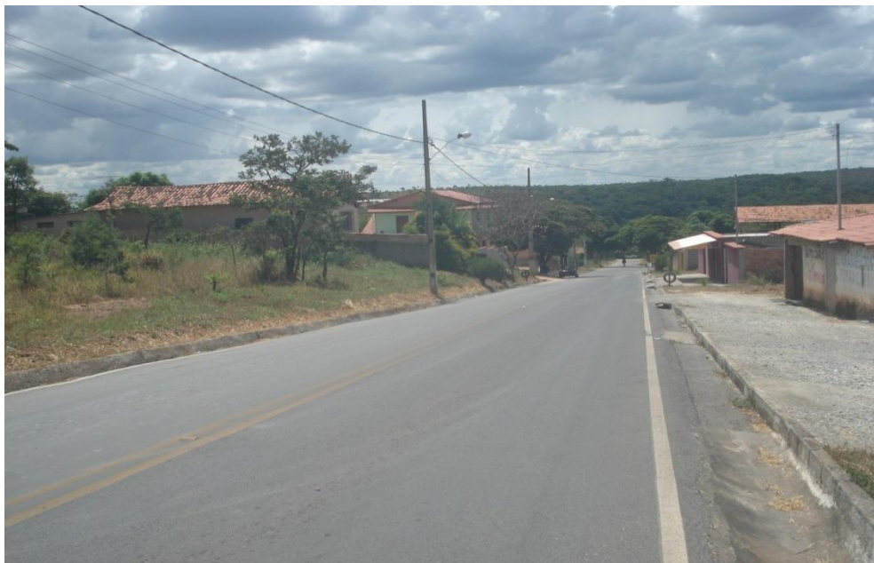
Figura 7.44 – Asfaltamento na MG-323, acesso ao distrito de São Vicente
