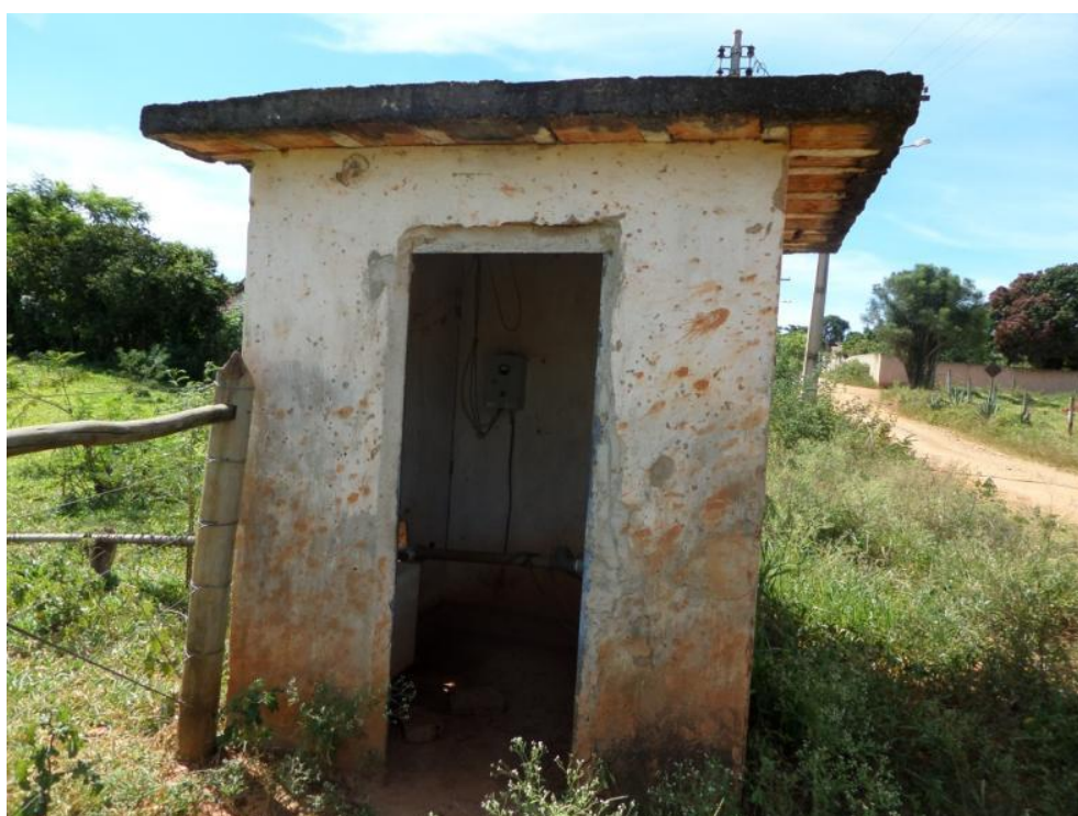
Figura 7.101 – Casa do poço de Sumidouro
