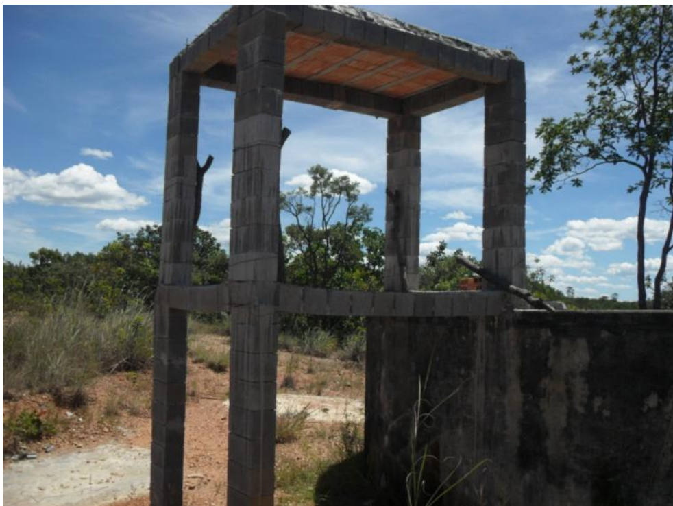
Figura 7.129 – Local onde será implantado o novo reservatório do Centro de Vargem Grande
