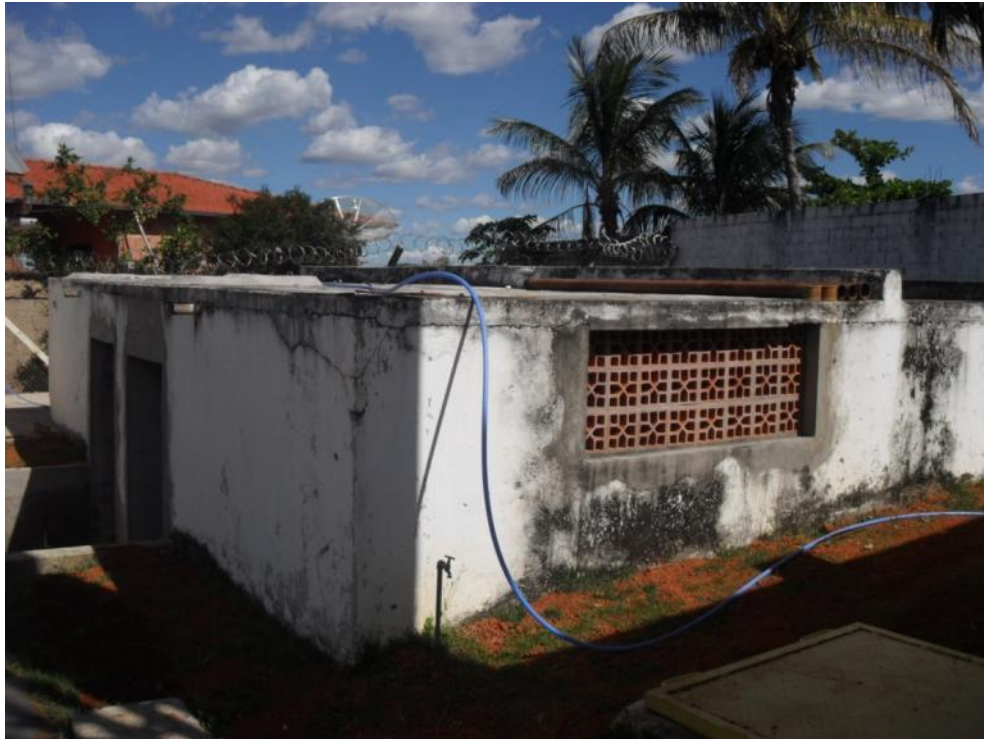
Figura 7.66 – Vista geral do galpão de armazenamento do sistema Baldim Sede Fonte: COBRAPE (2014)
