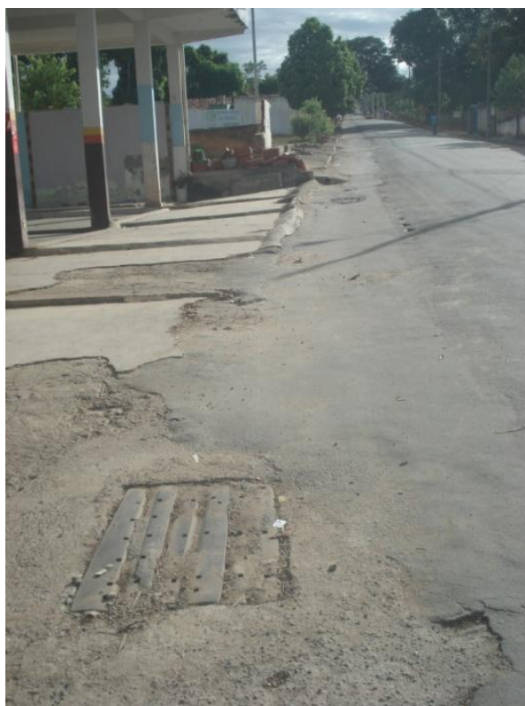
Detalhe da grelha de captação das águas pluviais
