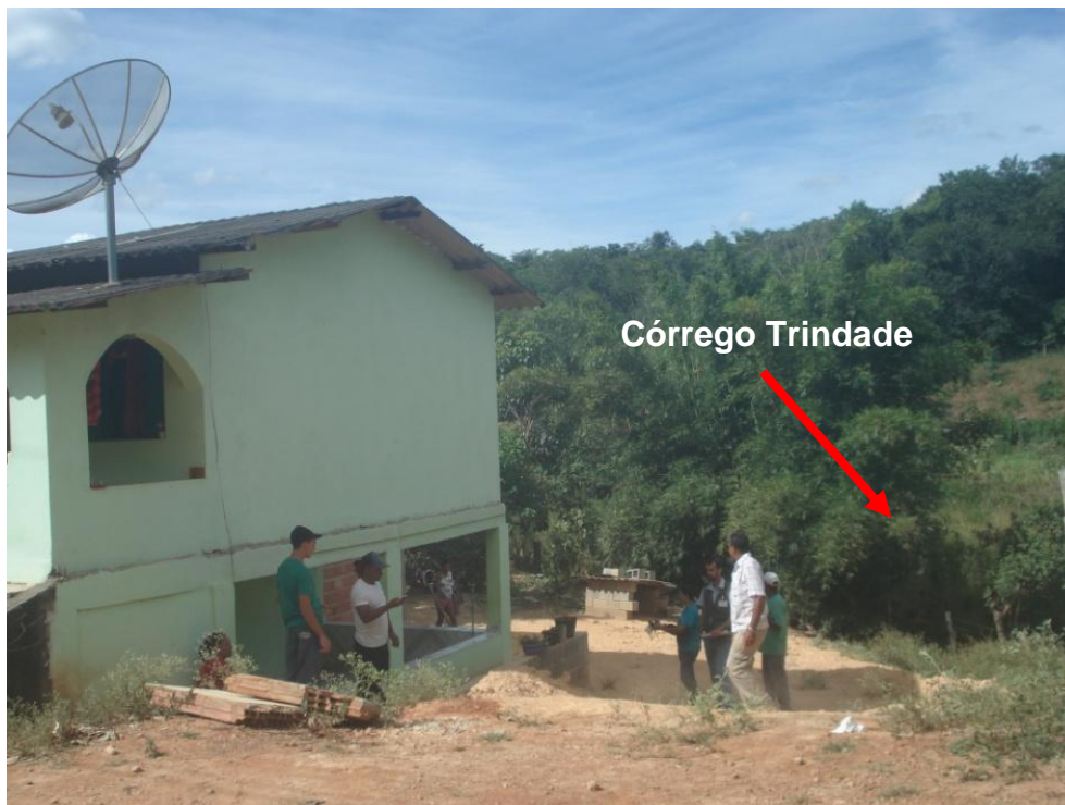
Residência afetada pela inundação do Córrego Trindade
