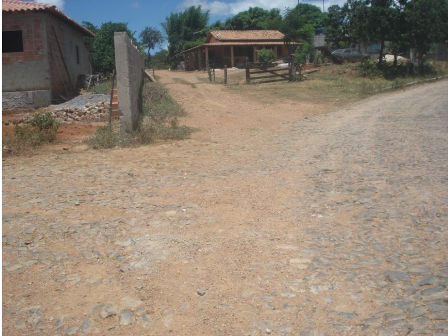
Vista geral da Rua 7
