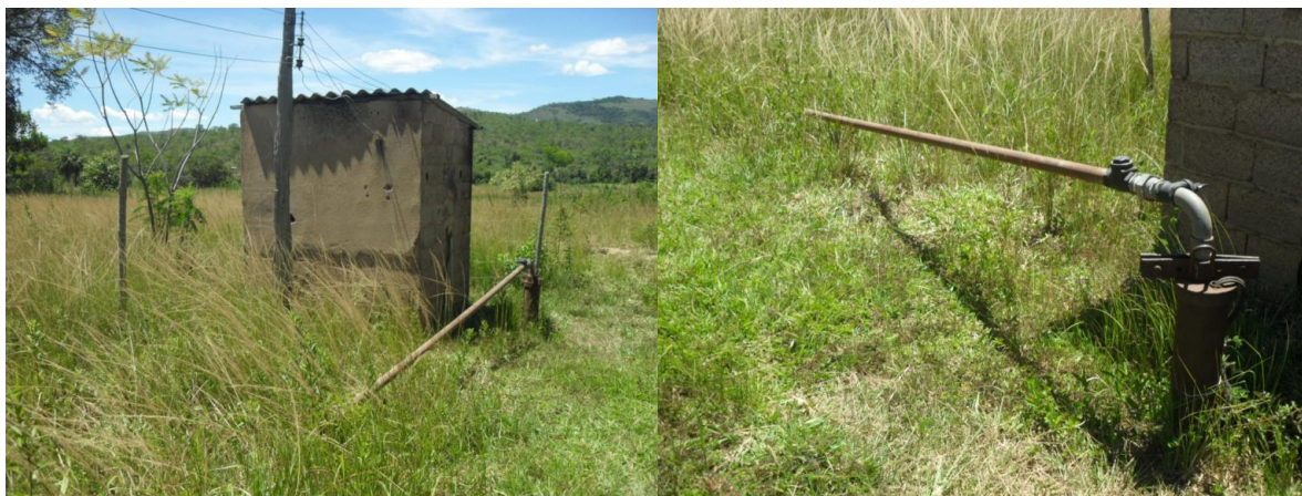
Figura 7.123 – Poço artesiano do Centro de Vargem Grande
