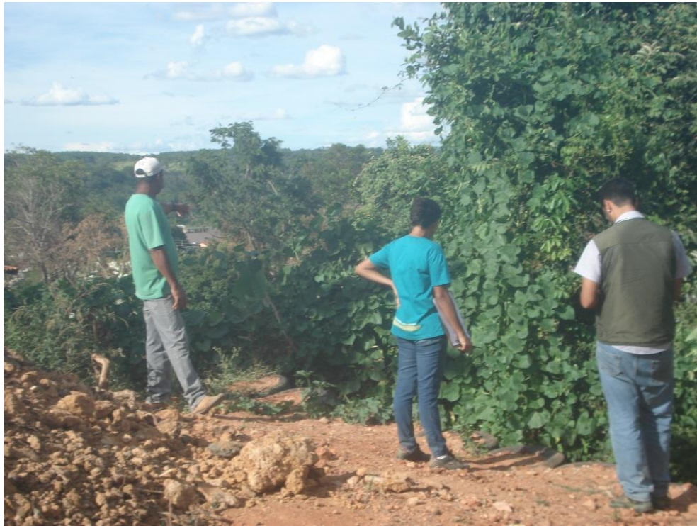
Figura 7.12 – Deslizamento de terra: Avenida Brasil
