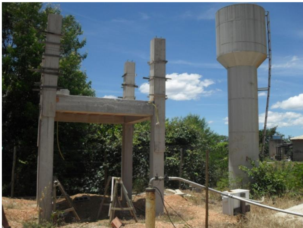
Figura 7.118 – Reservatório de Alto da Cuia e local de instalação para novo reservatório
