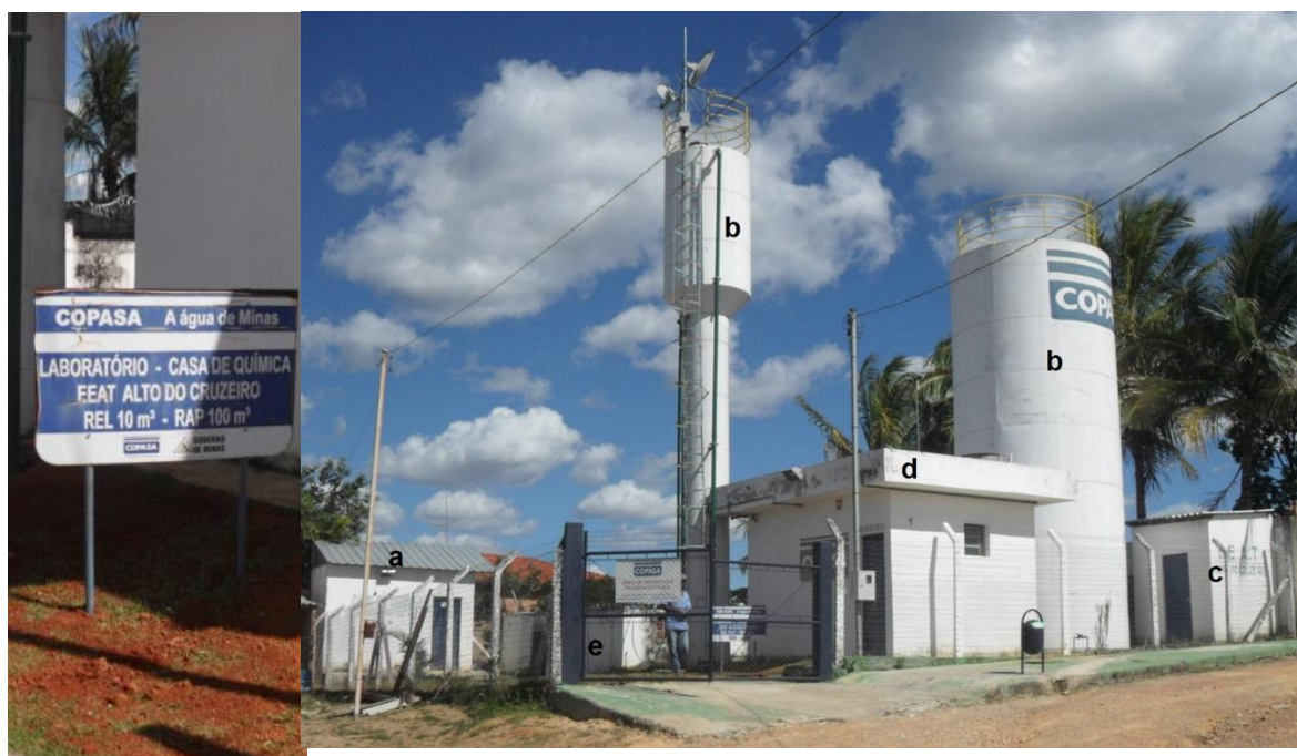
Figura 7.65 – Identificação e vista geral do local onde se encontram (a) a casa de química, (b) os reservatórios, (c) a elevatória de água tratada, (d) o laboratório de análises e (e) o galpão do sistema Baldim Sede
