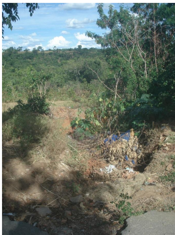
Figura 7.8 – Processo erosivo I: Rua Vitalino Francisco da Silva
