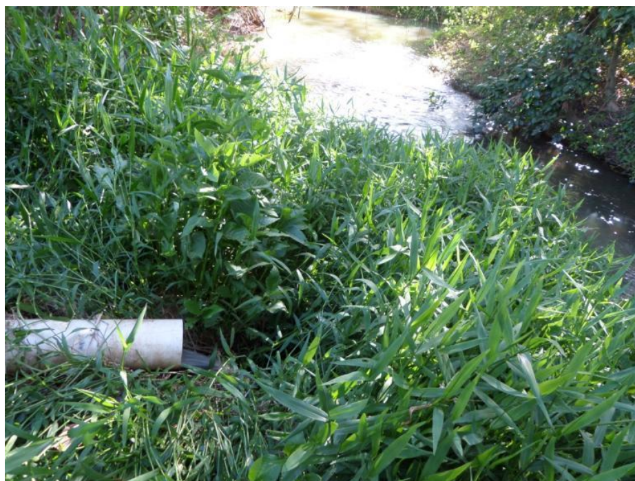
Figura 7.139– Principal lançamento de esgoto de São Vicente (córrego Grande)
