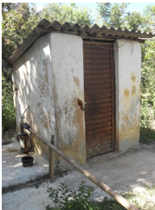
Figura 7.109– Poço artesiano e casa de apoio de Vila Amanda
