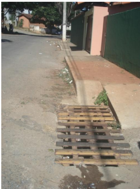
Boca de lobo com grelha localizada na Rua João Luiz
