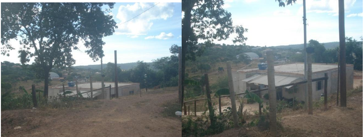
Residência afetada pelas enxurradas – Loteamento Aroeira
