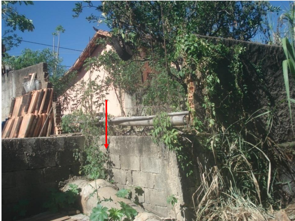
Galeria no terreno da residência
