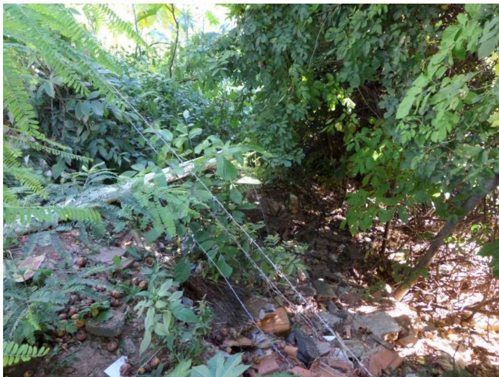
Figura 7.140– Lançamento no solo, próximo ao córrego Grande, em São Vicente
