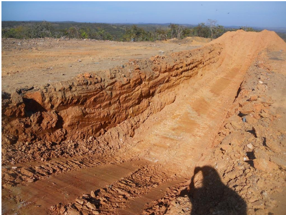
Figura 7.175 – Abertura de novas valas para destinação de RSU
