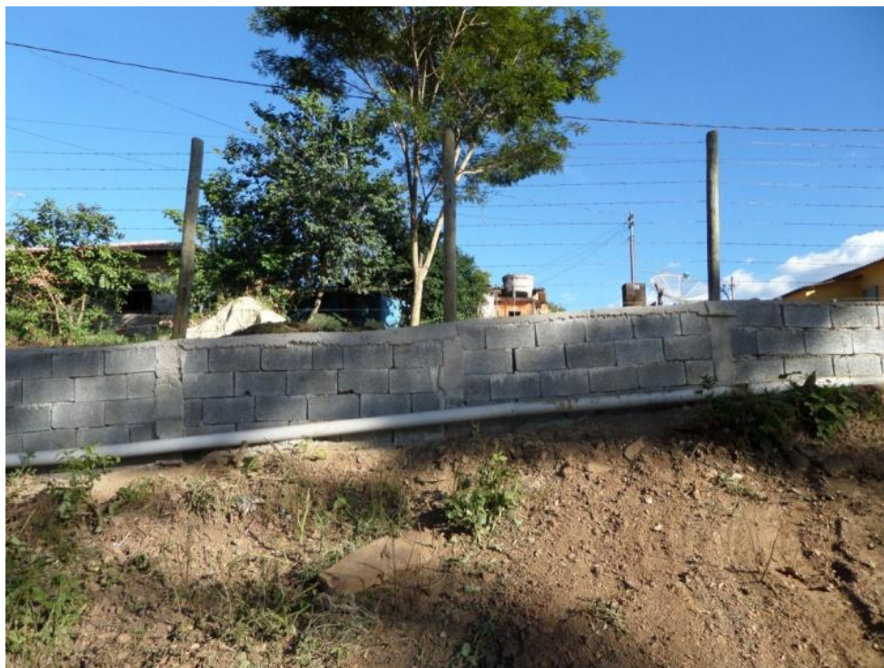
Figura 7.143– Trecho da rede coletora de esgoto em implantação por um morador no distrito de São Vicente
