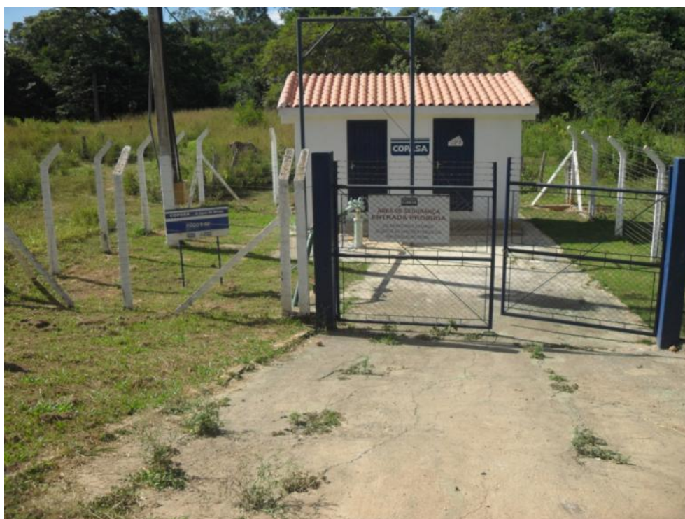
Figura 7.71– Entrada para o poço Eucalipto (E-02 São Vicente) em São Vicente
