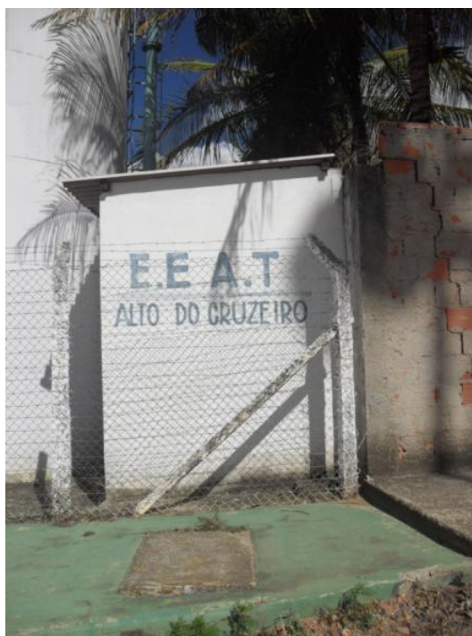
Figura 7.69 – Identificação da estação elevatória de água tratada do sistema Baldim Sede
