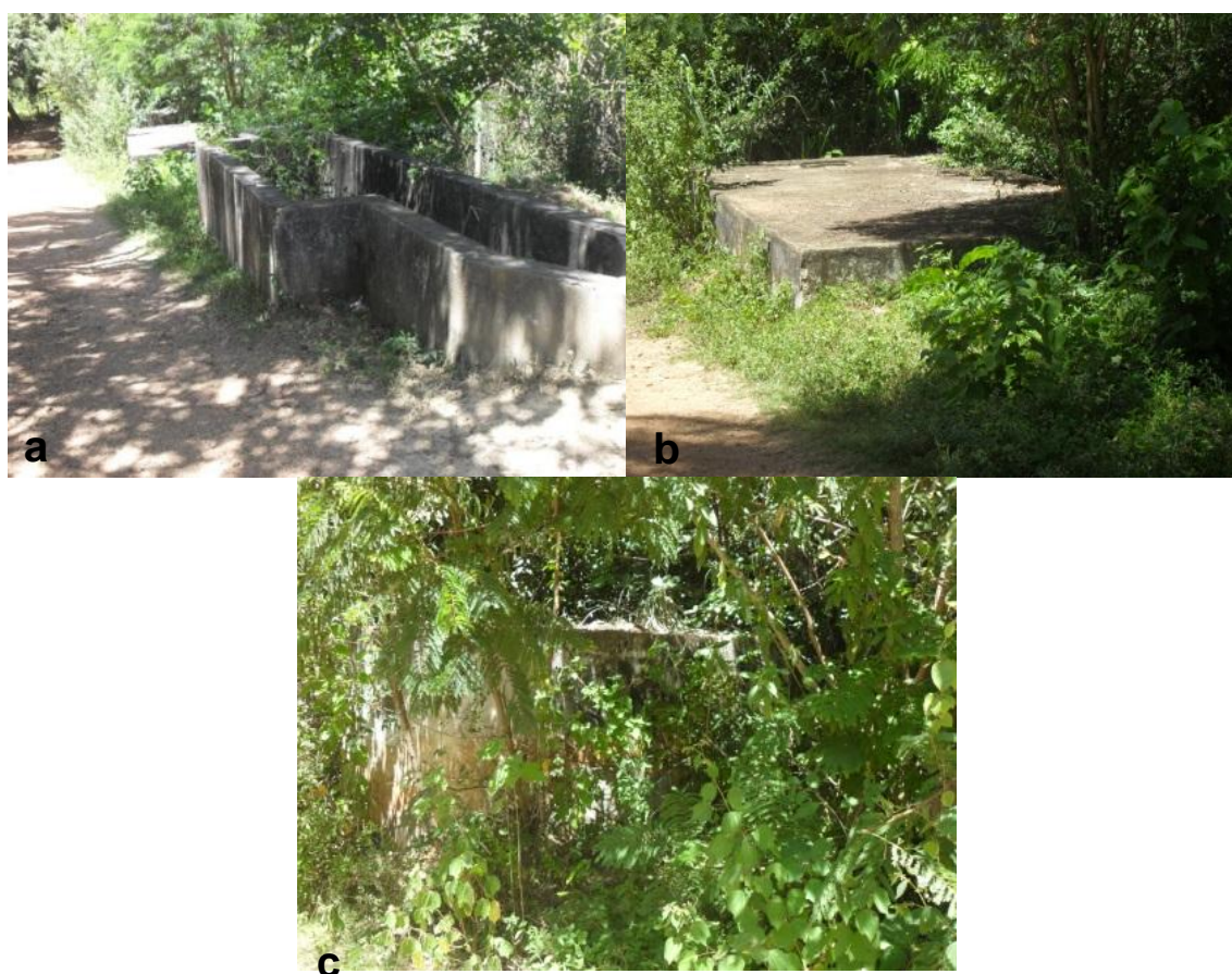
Figura 7.146 – Vista geral da ETE desativada em Vargem Grande: (a) tratamento preliminar; (b e c) tanques sépticos
