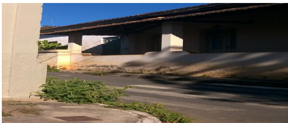
Figura 131: Local precisado de capina Fonte: Prefeitura Municipal de Cordisburgo, 2014
