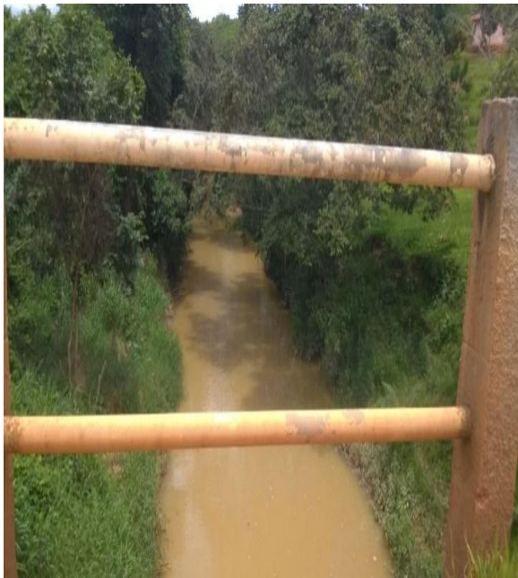
Figura 153: Macro drenagem de Cordisburgo
