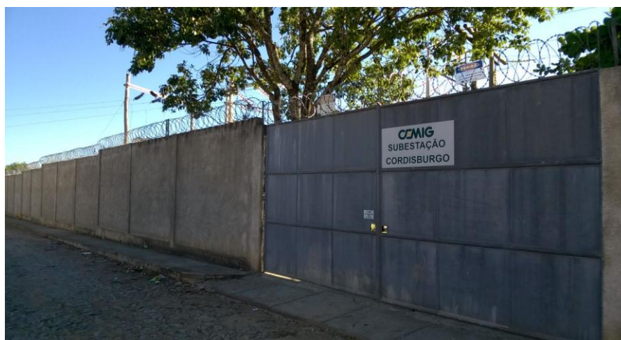
Figura 38: Subestação da CEMIG em Cordisburgo Fonte: Prefeitura Municipal de Cordisburgo, 2014
