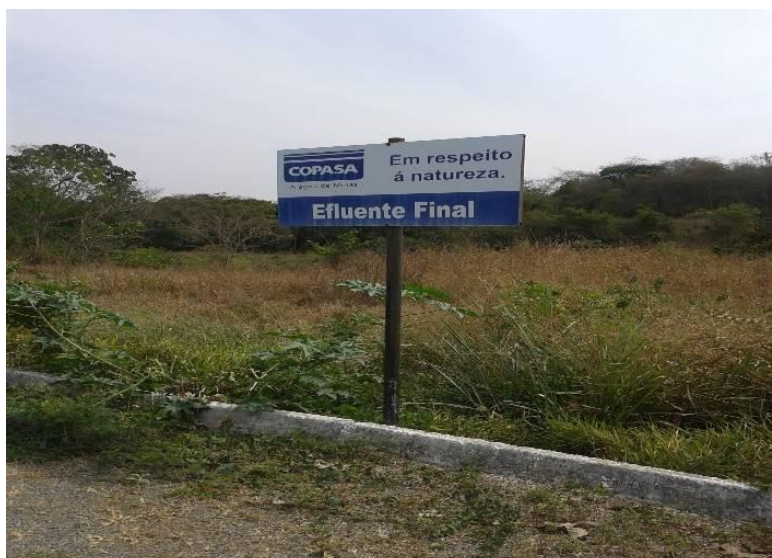
Figura 97: Saída do efluente final
