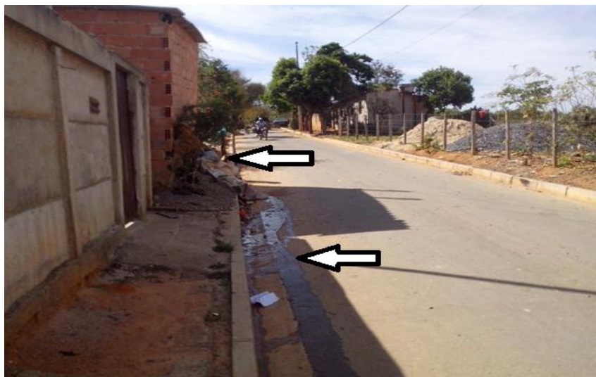
Figura 13: Lançamento de esgoto na rua e acondicionamento de RSU Fonte: Prefeitura Municipal de Cordisburgo, 2014
