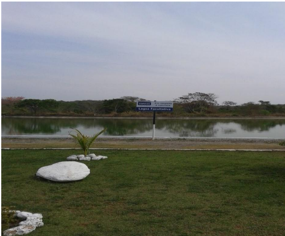
Figura 92: ETE Cordisburgo Fonte: Prefeitura Municipal de Cordisburgo, 2014
