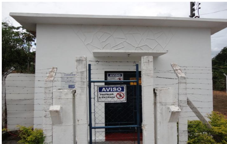
Figura 50: Estação elevatória Fonte: Prefeitura Municipal de Cordisburgo, 2014
