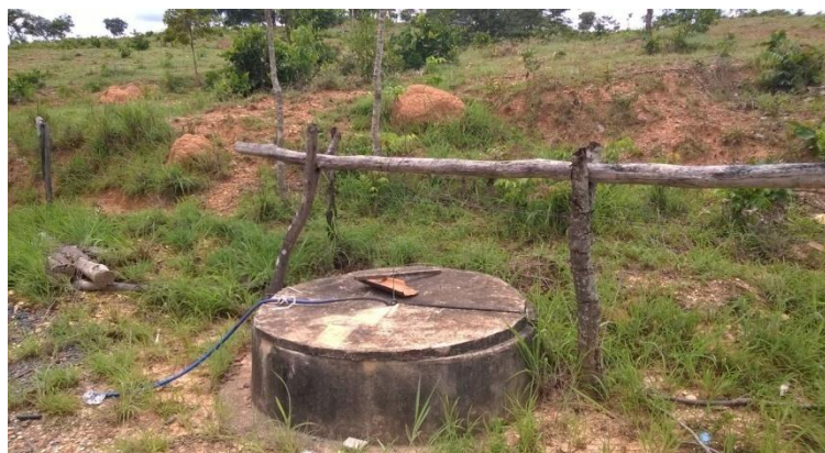
Figura 57: Cisterna na comunidade Bagagem Fonte: Prefeitura Municipal de Cordisburgo, 2014
