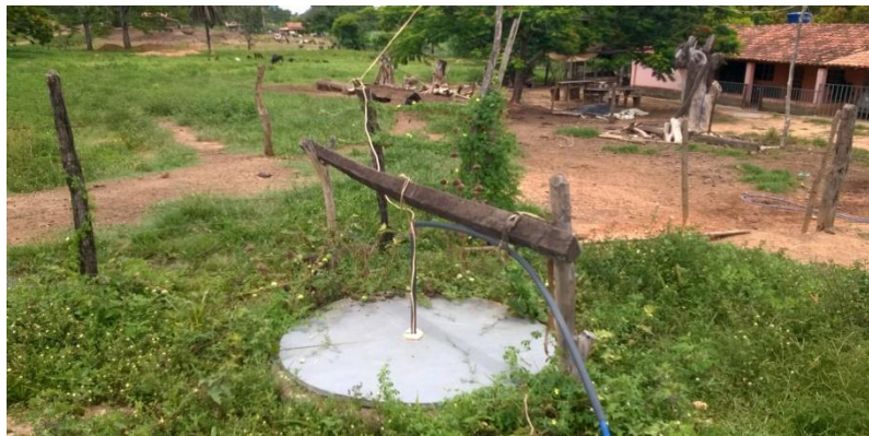
Figura 79: Cisterna em Logradouro Fonte: Prefeitura Municipal de Cordisburgo, 2014
