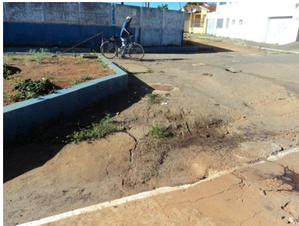
Figura 236: Rampa de Acesso Fonte: Gesois, 2014
