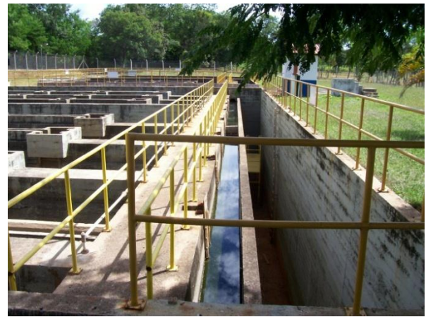
Figura 157: Reatores anaeróbicos Fonte: Gesois, 2014
