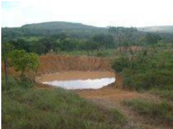
Figura 125: Barraginha construída na Capivara de Cima, zona rural de Corinto Fonte: Pereira, 2011
