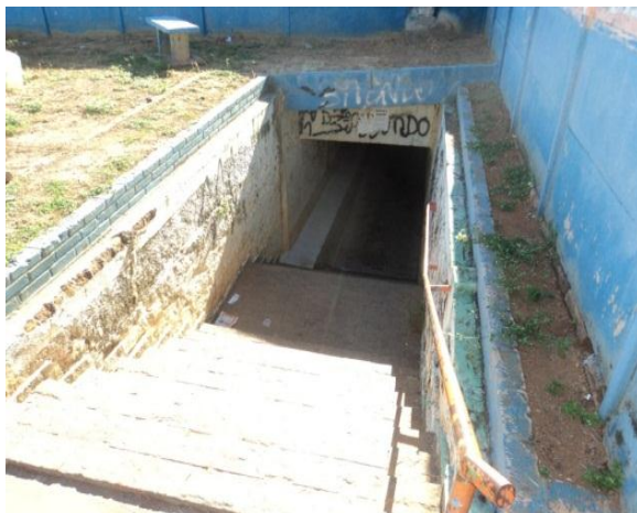
Figura 234: Passagem sob a FCA Fonte: Gesois, 2014
