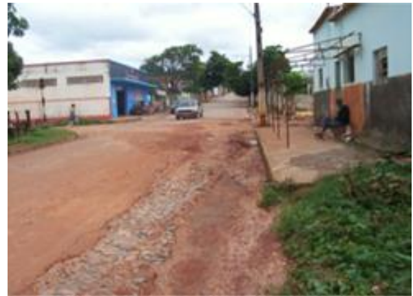
Figura 238: Rua Moacir Pereira Fonte: Gesois, 2014
