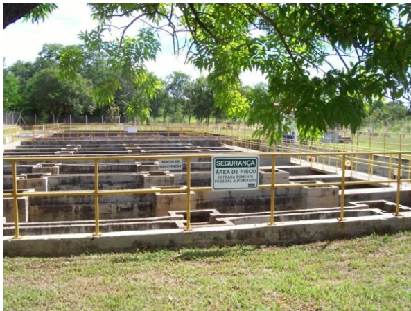
Figura 157: Reatores anaeróbicos Fonte: Gesois, 2014
