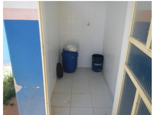
Figura 216: Acondicionamento UBS – Alvarenga Fonte: Gesois, 2014
