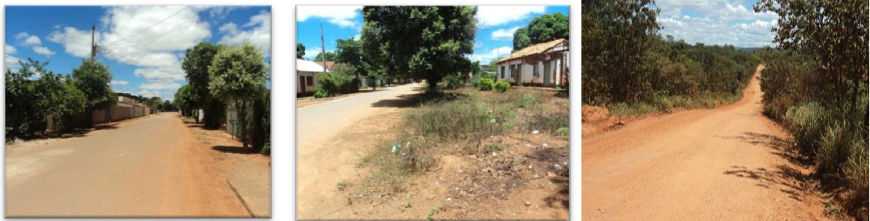
Figura 252: Aspecto dos acessos do município Fonte: Gesois, 2014
