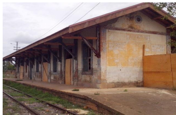
Figura 24: Estação Ferroviária em obras
