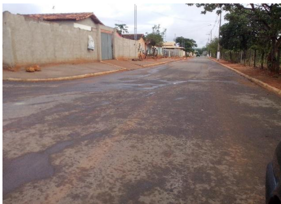
Figura 47: Asfaltamento da AV. Ulisses Batista
