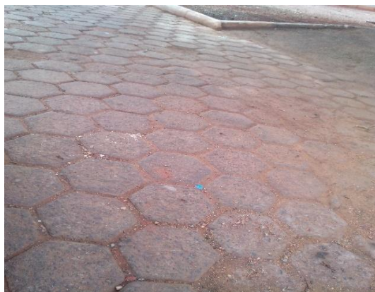
Figura 48: Bloquete Sextavado na Rua D
