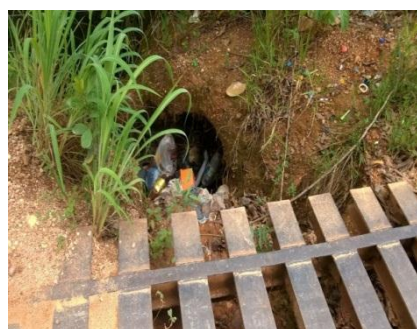
Figura 99: Resíduos dispostos de forma inadequada
