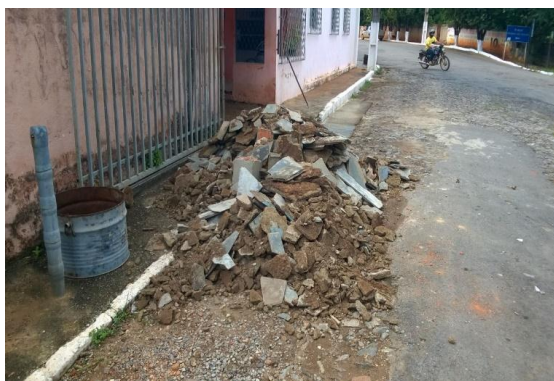
Figura 109: RCC dispostos em via pública
