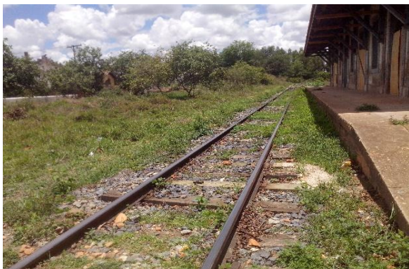
Figura 53: Ferrovia sentido Sete Lagoas
