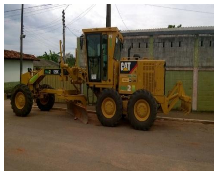
Figura 120: Máquina que realiza a cobertura dos resíduos
