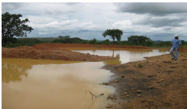
Figura 131: Barragem localizada no distrito Fazendinha Pai José Fonte: Prefeitura Municipal de Aracá, 2014
