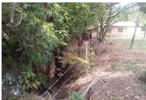
Figura 45: Residências em APP
