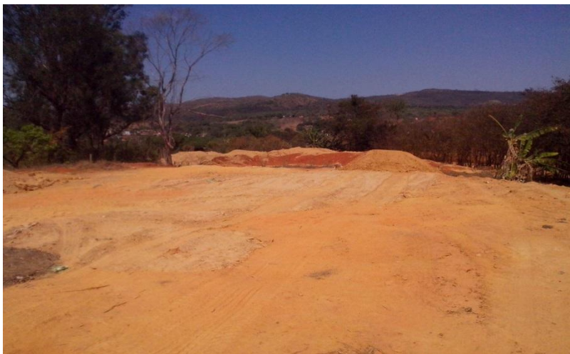
Figura 5: Aterro Controlado de Araçá.
