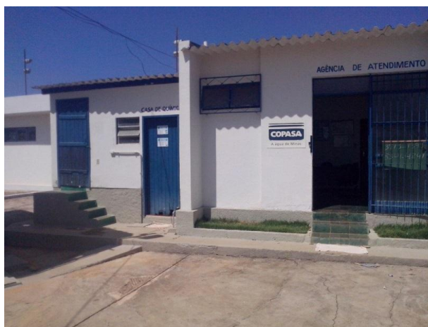
Figura 3: Reservatório de água e casa de química da COPASA. Fonte: Prefeitura Municipal de Araçai (2014)
