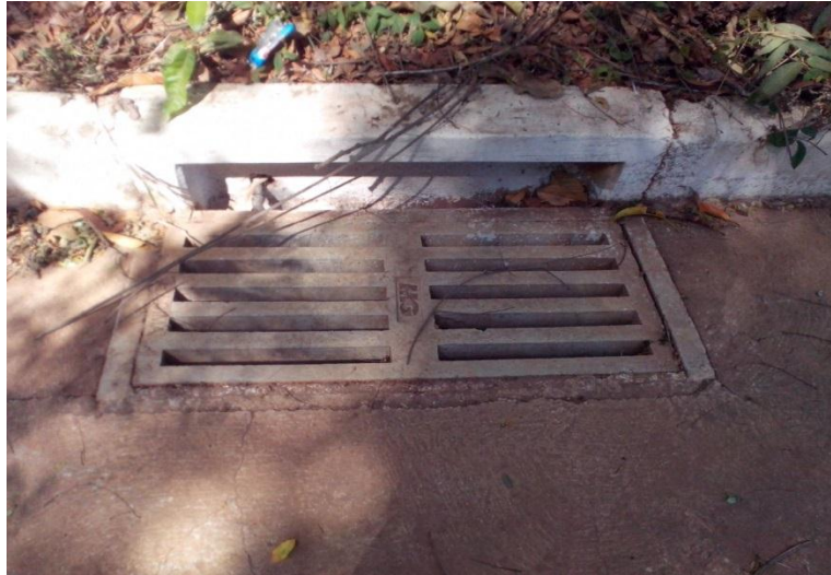
Figura 7: Boca de lobo localizada no Centro de Araçáí.
