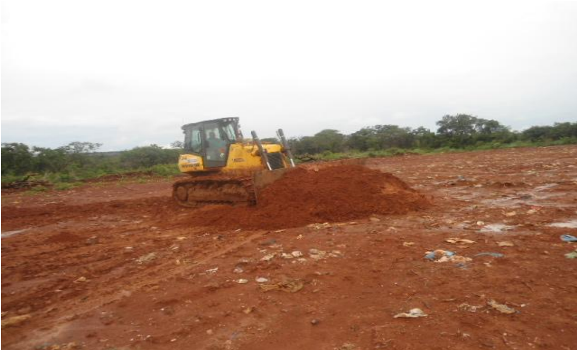
Figura 19 - Compactação do lixo em Aterro Sanitário de Curvelo
