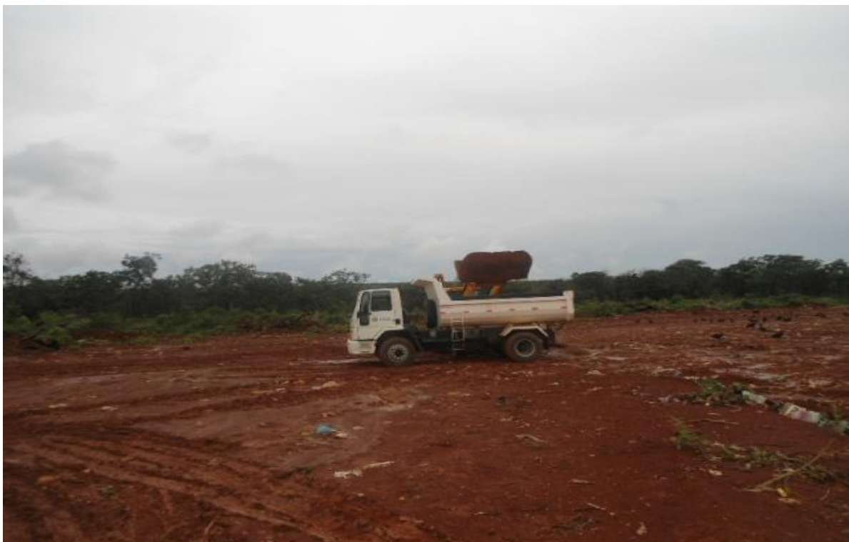
Figura 20 - Aterro Sanitário de Curvelo
