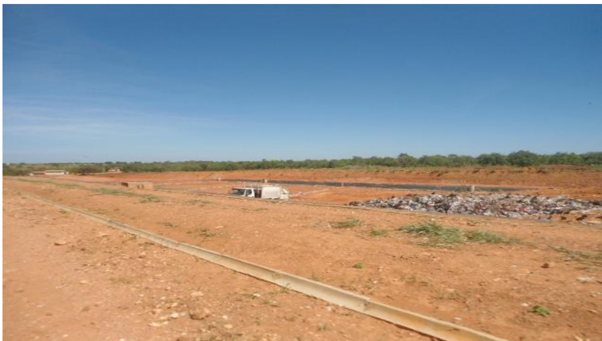
Figura 18- Área do Aterro Sanitário
